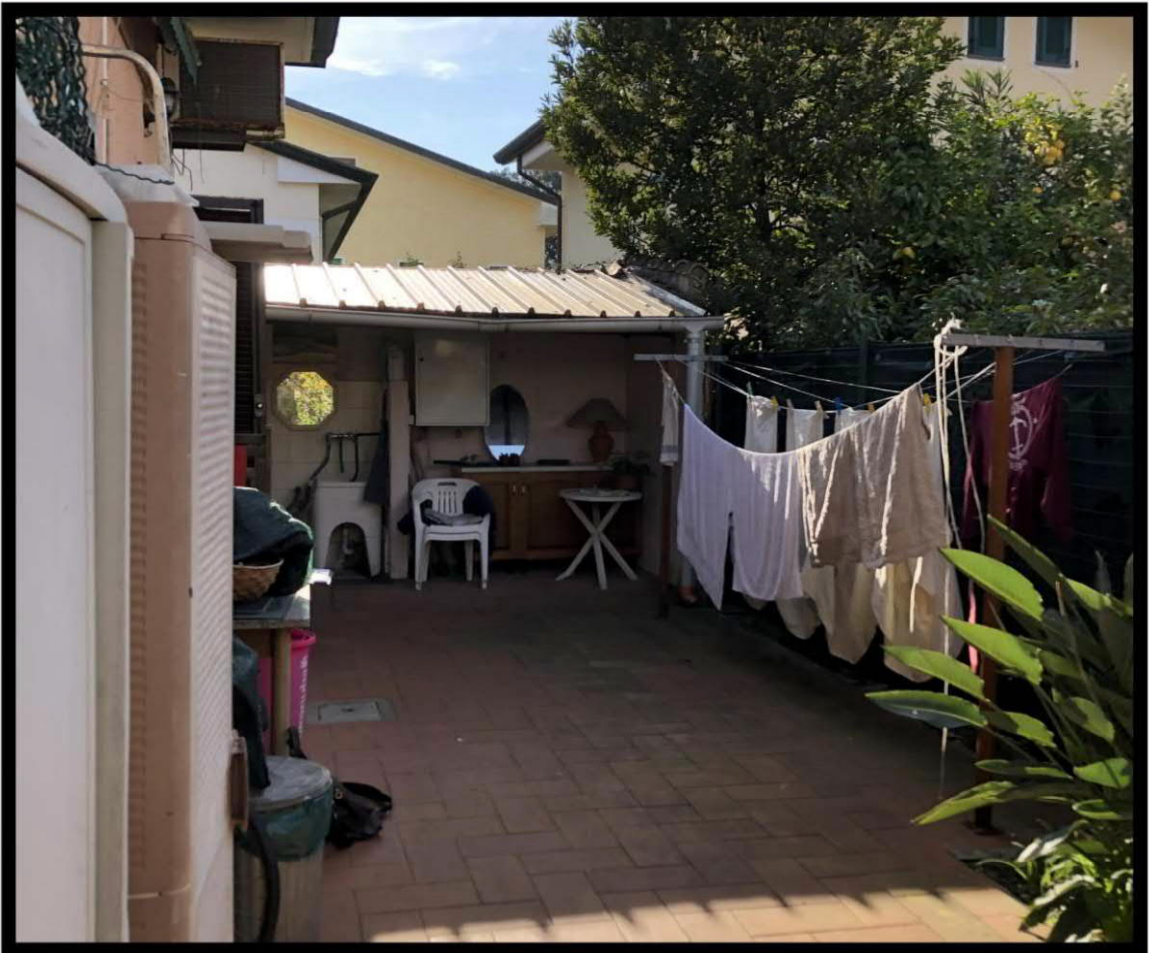
Foto 6 - Corte esterna di proprietà (Copertura da rimuovere)
