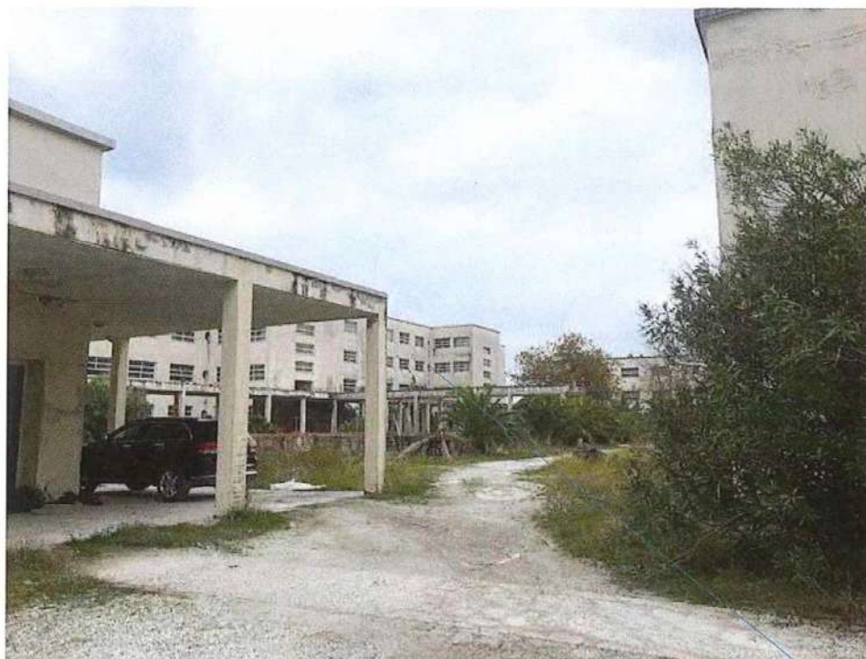
Vista dall'accesso verso il piazzale-cortile interno e fabbricati lato mare
