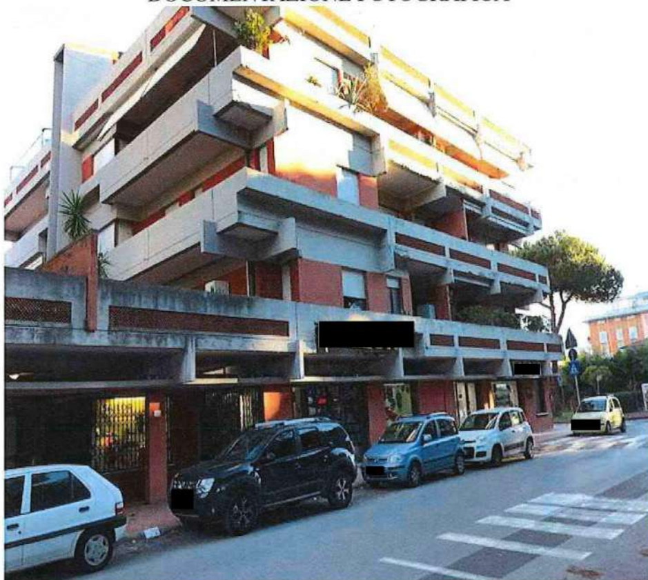
Vista del fabbricato condominiale lungo Via Bassagrande
