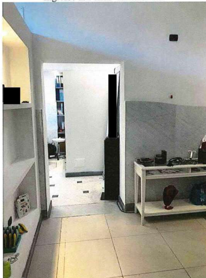
Vista dell'apertura di comunicazione fra i 2 Fondi commerciali
