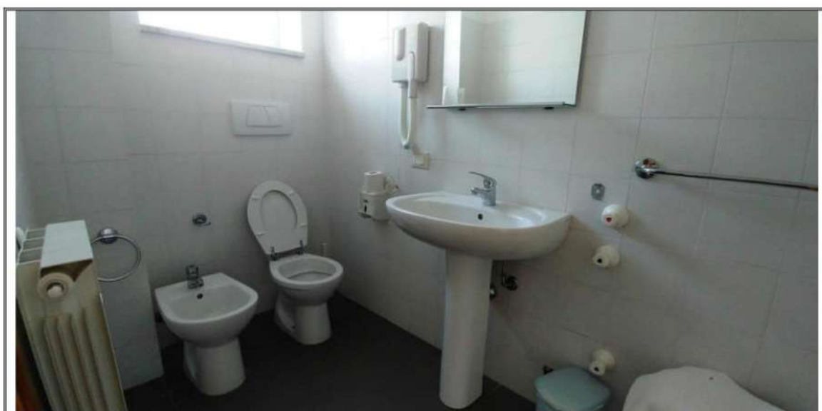
Foto n. 33 – Piano Secondo – Bagno ( nuovo blocco )
