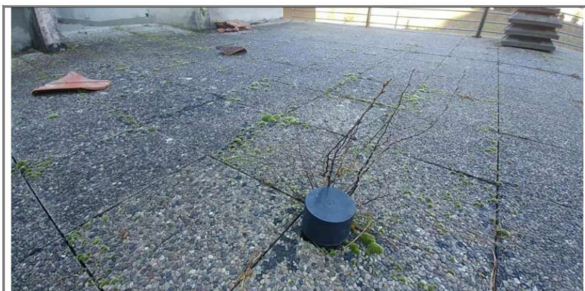
Foto n. 42 – Terzo livello – Particolare della pavimentazione
