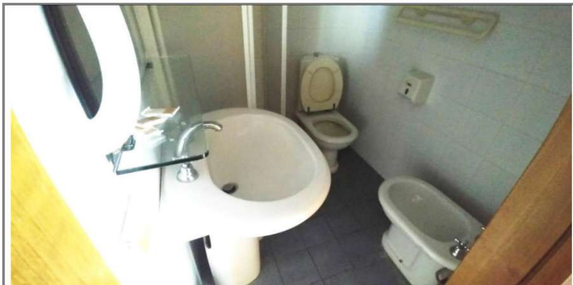
Foto n. 28 – Piano Primo – Bagno ( blocco preesistente)
