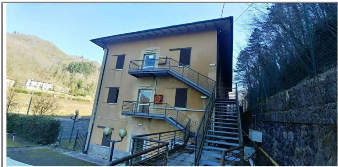
Foto n. 4 – Vista dell'immobile – Facciata lato OVEST
