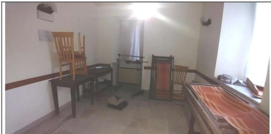
Foto n. 13 – Piano Terra – Saletta
