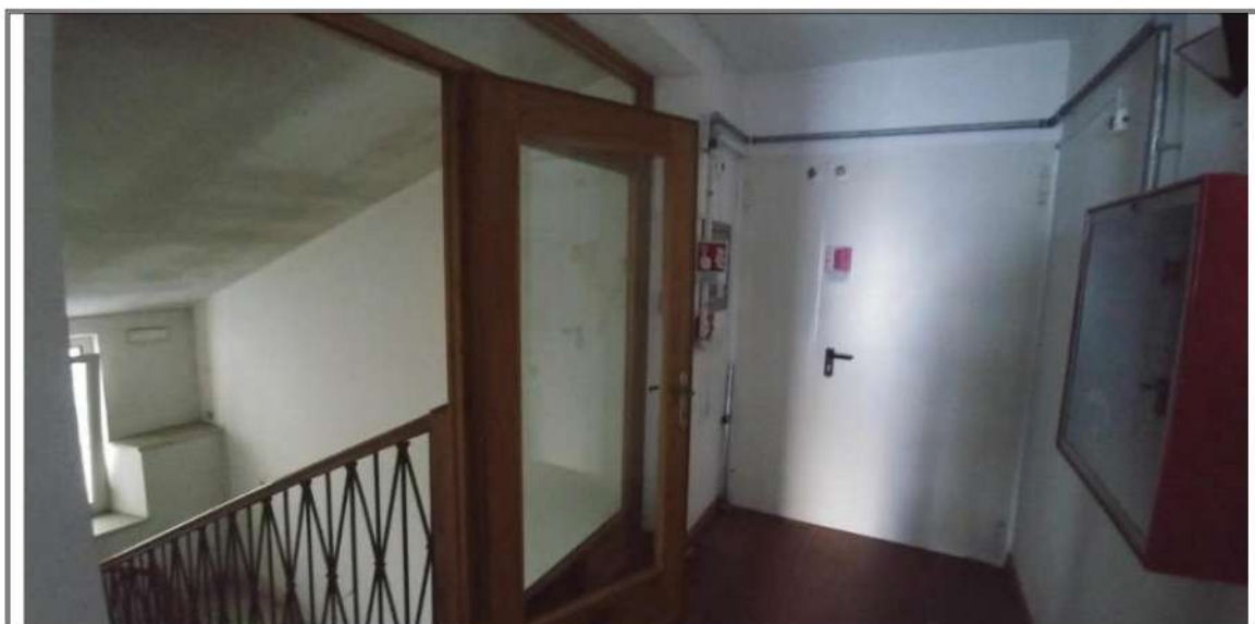
Foto n. 47 – Piano Sottotetto o terzo – Vano scala
