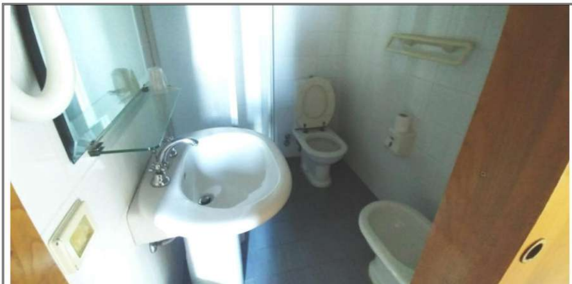
Foto n. 19 – Piano Primo – bagno (blocco preesistente)
