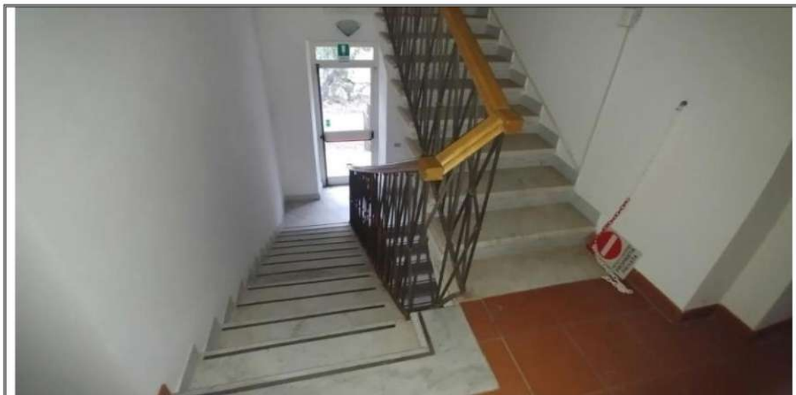
Foto n. 31 – Piano Primo – Scale
