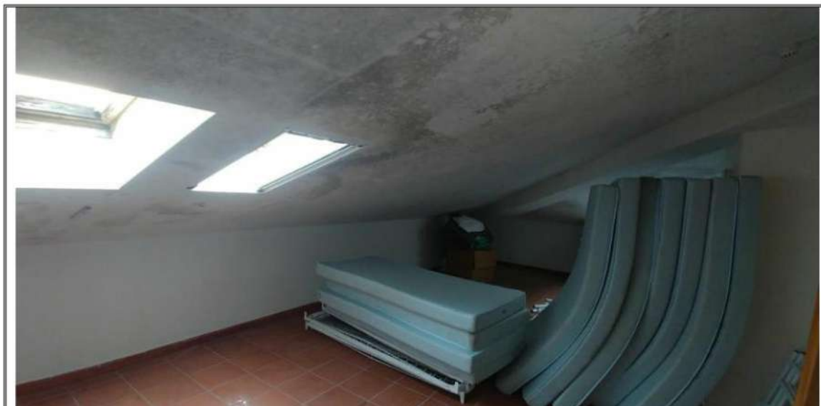
Foto n. 49 – Piano Sottotetto o terzo - Vano sottotetto
