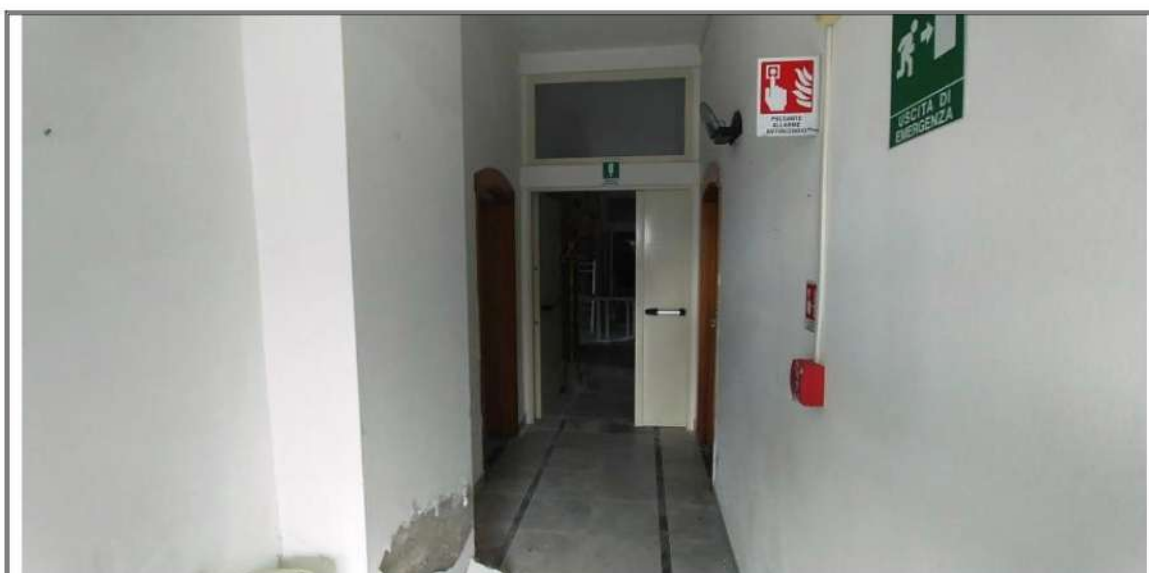
Foto n. 9 – Piano Terra – Corridoio di distribuzione
