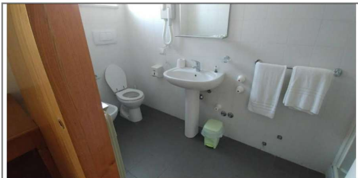
Foto n. 23 – Piano Primo – Bagno (nuovo blocco)
