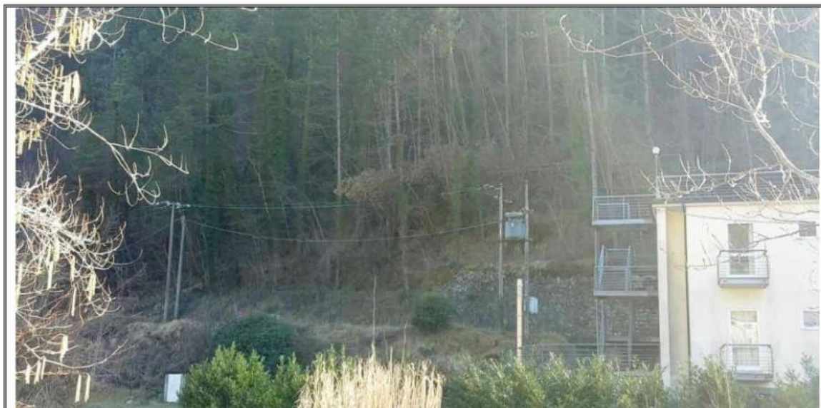
Foto n. 52 – Terreni foglio 153 mappali 3 – 33 - 35
