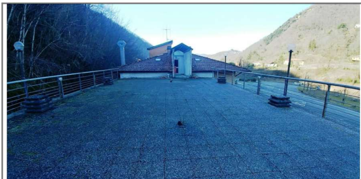
Foto n. 41 – Terzo livello – Lastrico solare sul nuovo blocco
