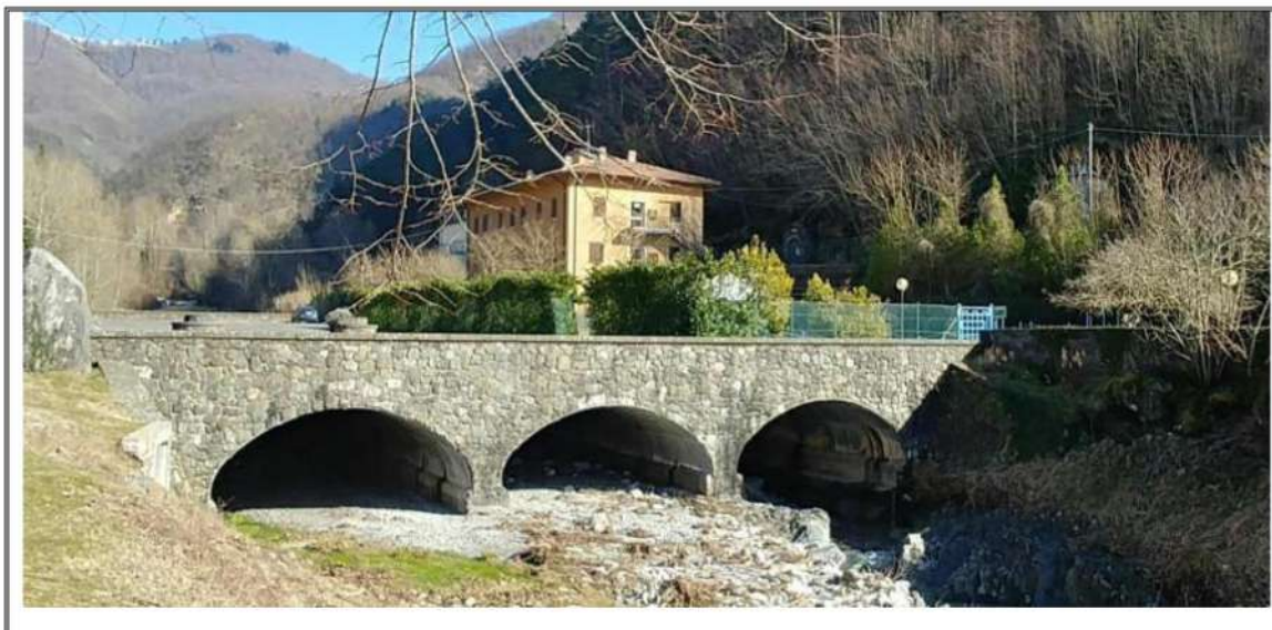
Foto n. 1 – Vista dell'immobile – Angolo NORD-OVEST
