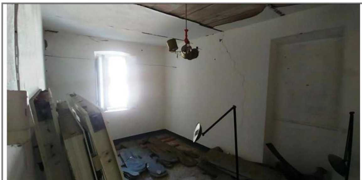
Foto n. 8 – Piano Primo - Camera
