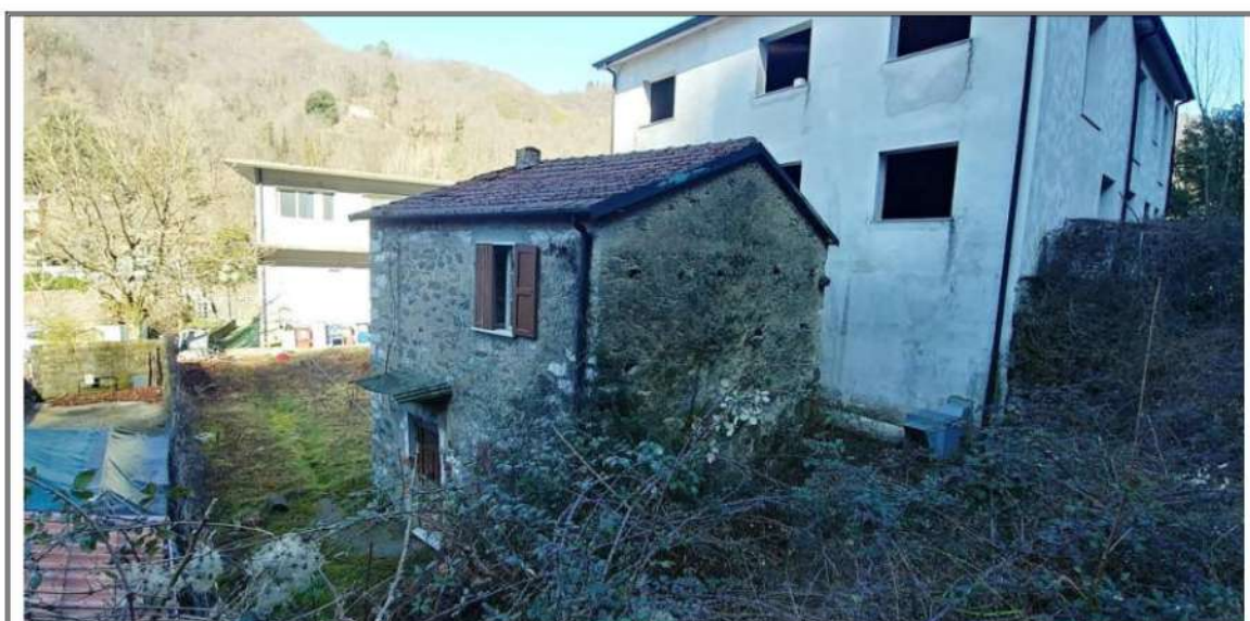
Foto n. 3 – Vista dell'immobile – Angolo SUD-OVEST
