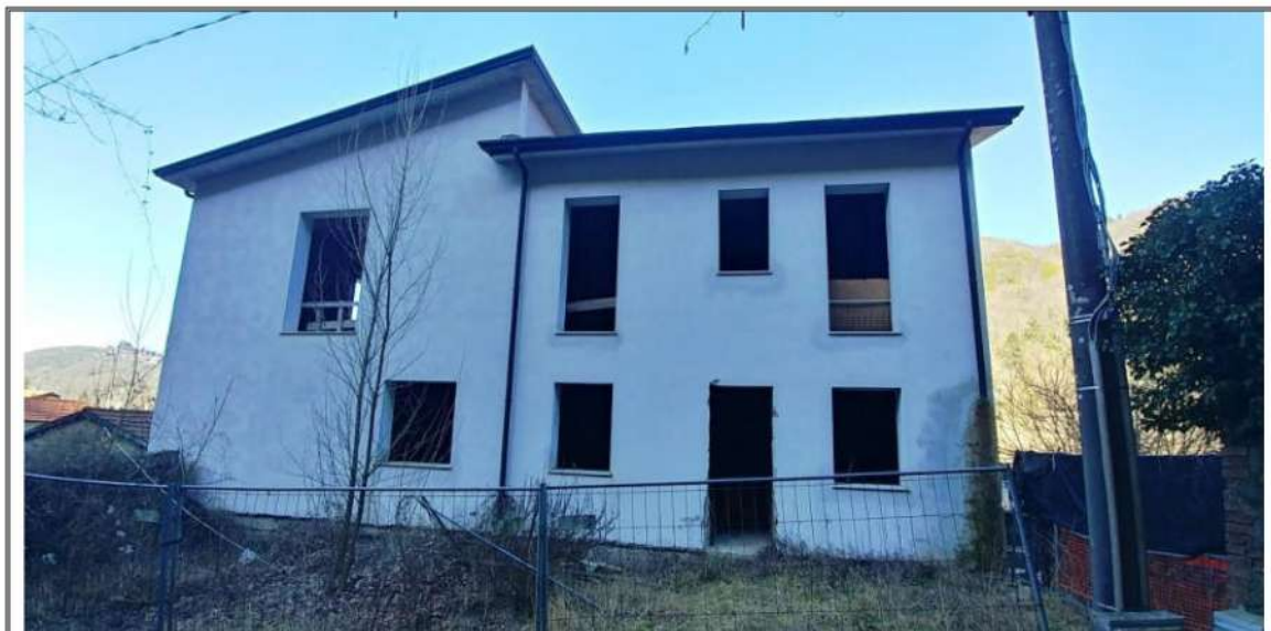
Foto n. 4 – Vista dell'immobile – Facciata lato SUD
