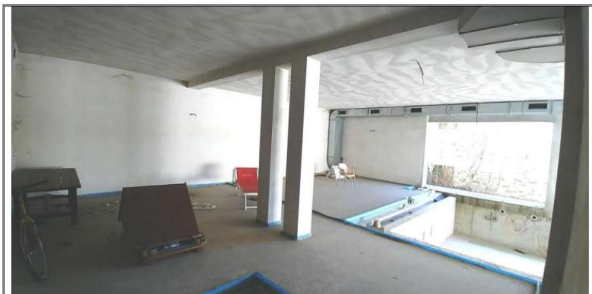
Foto n. 8 – Piano terra - Piscina
