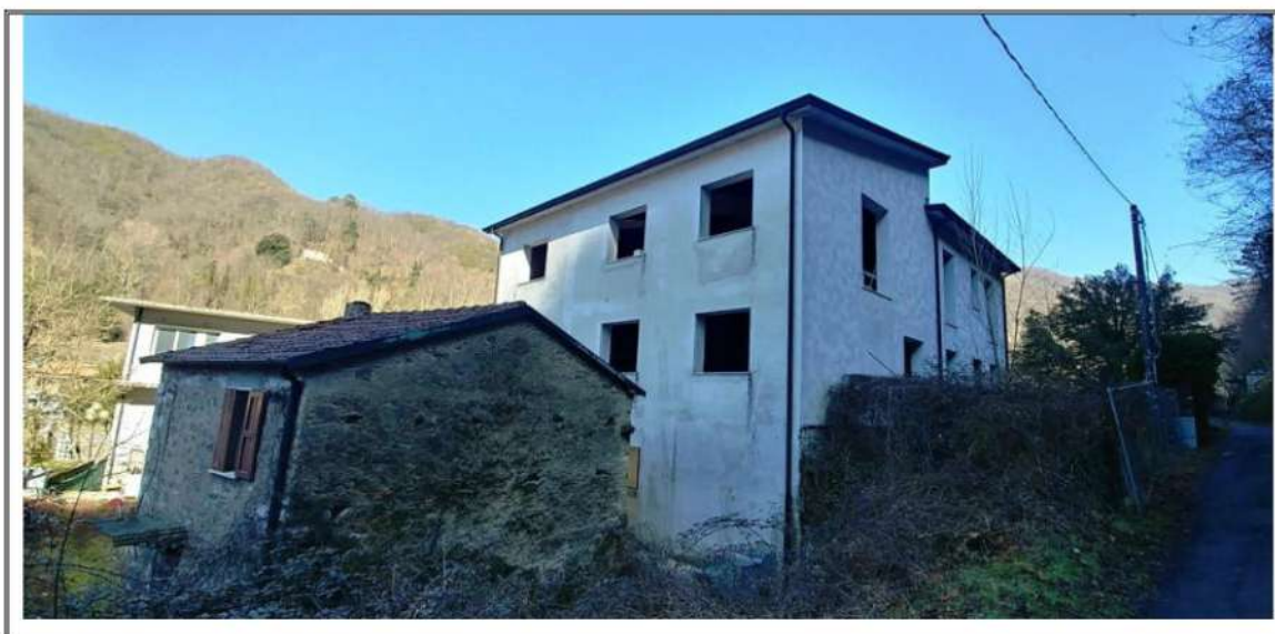
Foto n. 3 – Vista dell'immobile – Angolo SUD-OVEST
