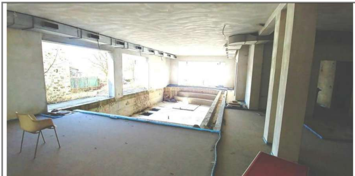
Foto n. 7 – Piano terra - Piscina
