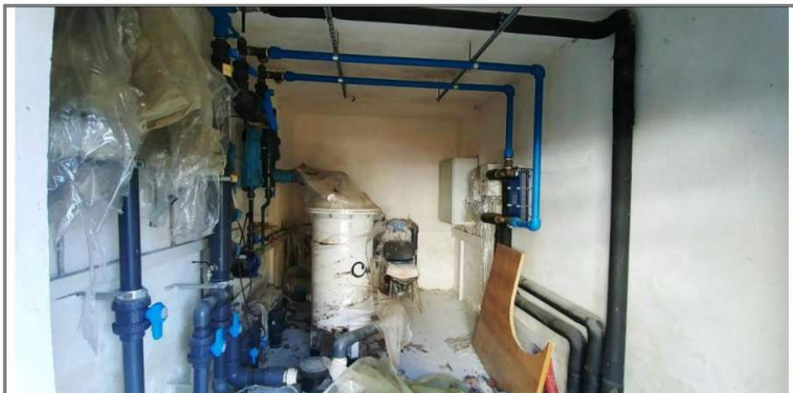
Foto n. 4 – Piano Terra - Cantina
