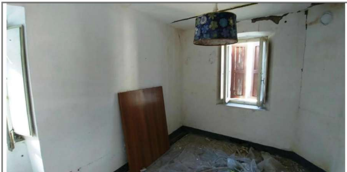
Foto n. 7 – Piano Primo - Camera
