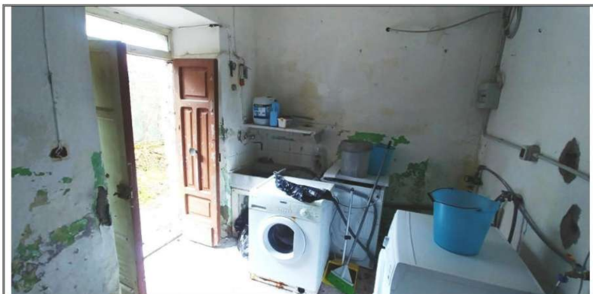
Foto n. 5 – Piano Terra - Cucina
