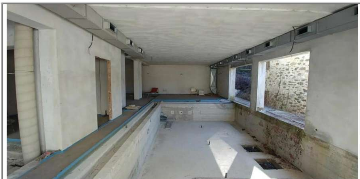
Foto n. 6 – Piano terra - Piscina
