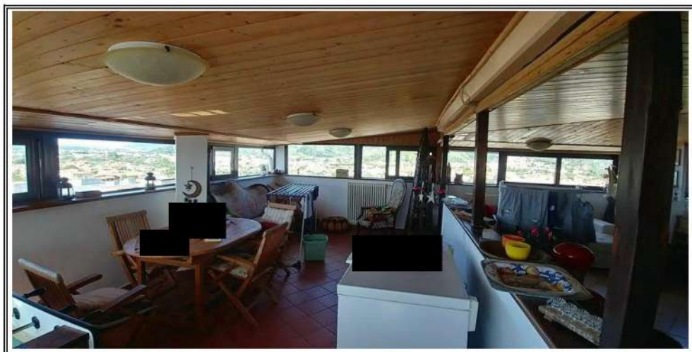
Foto n. 18 – Locali di sgombero sub 50 – Opera abusiva
