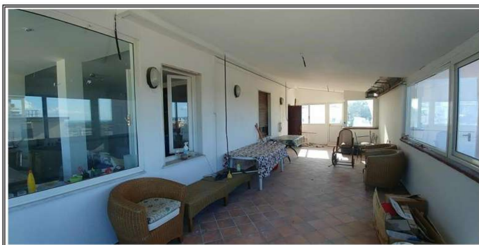
Foto n. 14 – Appartamento sub 49 – Terrazzo chiuso abusivamente
