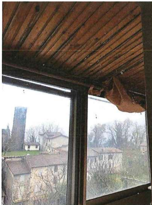
Terrazzino tamponato con infisso in alluminio e copertura in elementi di legno
