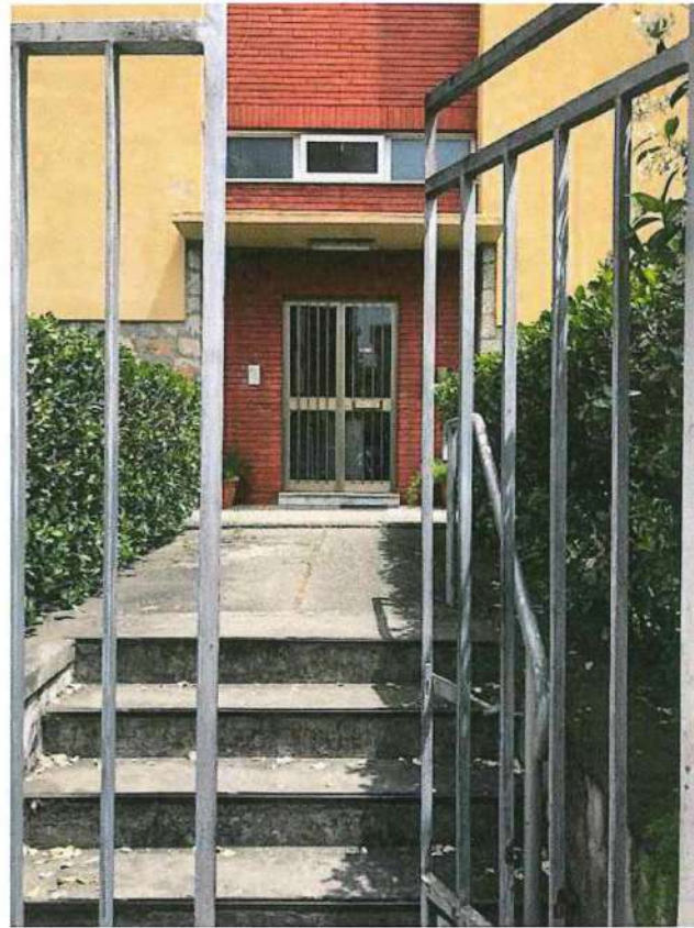
Cancello pedonale e accesso al fabbricato condominiale su Via Palestro
