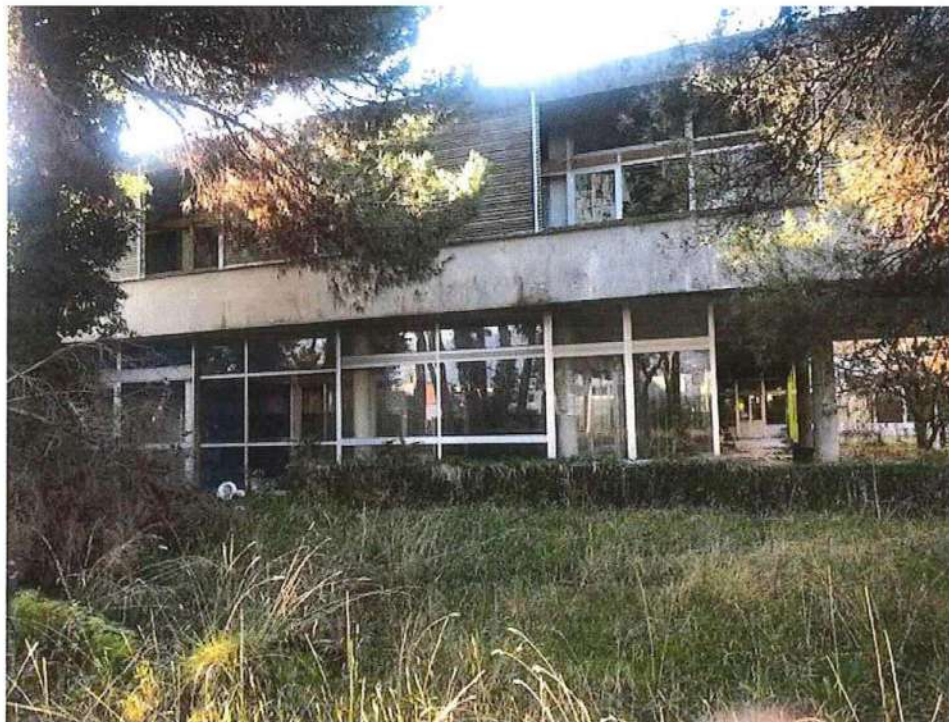
Vista prospetto retro (lato Viareggio)
