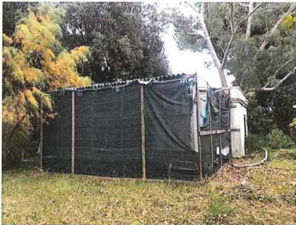
Vista lato Carrara
