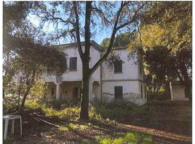
Vista prospetto lato monti
