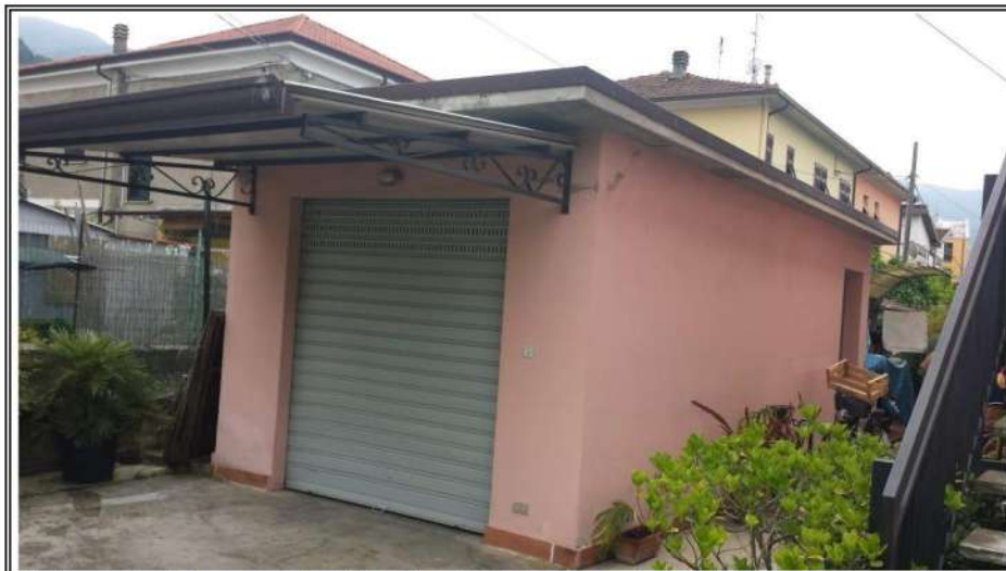
Foto n. 9 – Garage PT – fg 61 m 690/3 – Angolo OVEST
