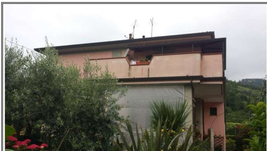
Foto n. 3 – Vista del fabbricato lato SUD-EST
