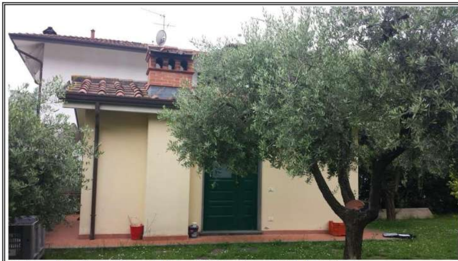
Foto n. 18 – Cantina – fg 61 m 1161 – lato NORD-EST
