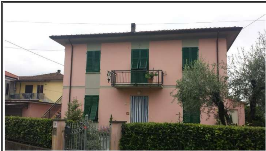
Foto n. 1 – Vista del fabbricato lato NORD-OVEST
