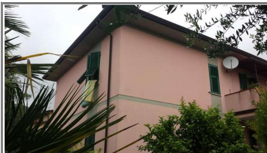
Foto n. 4 – Vista del fabbricato angolo SUD
