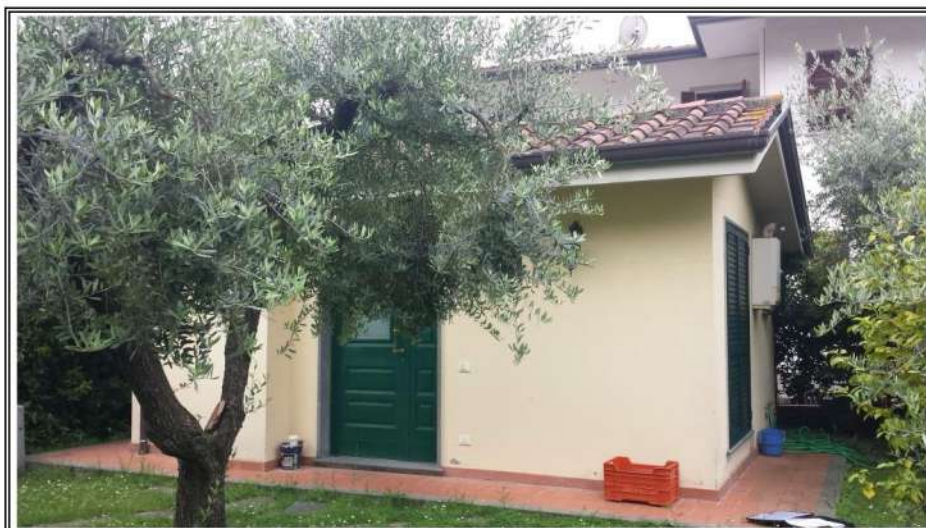
Foto n. 17 – Cantina – fg 61 m 1161 — Angolo NORD
