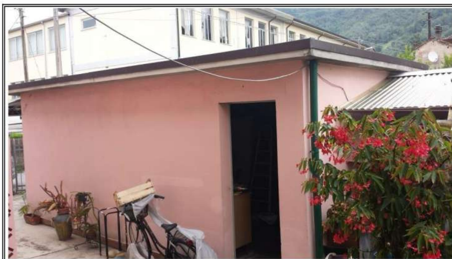
Foto n. 10 – Garage PT – fg 61 m 690/3 – Angolo SUD
