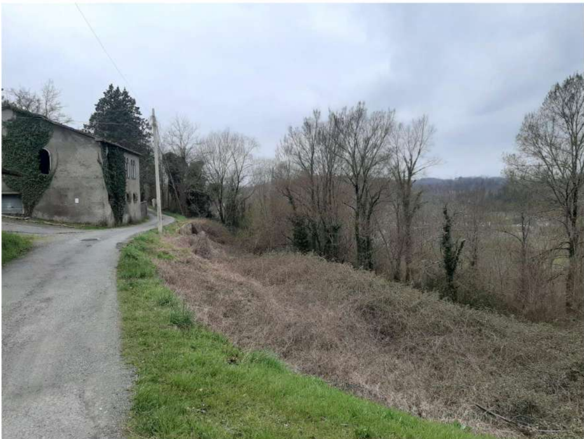
Foto 6. Lotto 3 dalla strada principale
