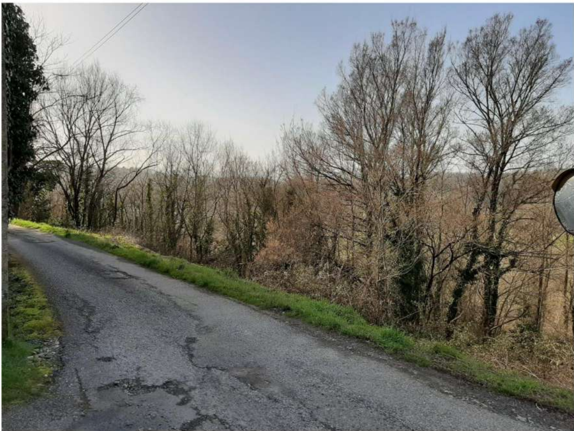
Foto 4. Lotto 3 dalla strada principale
