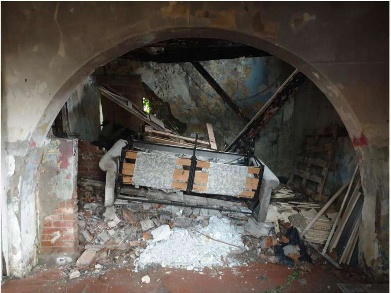
Foto 5. Interno: cucina, vano scala
