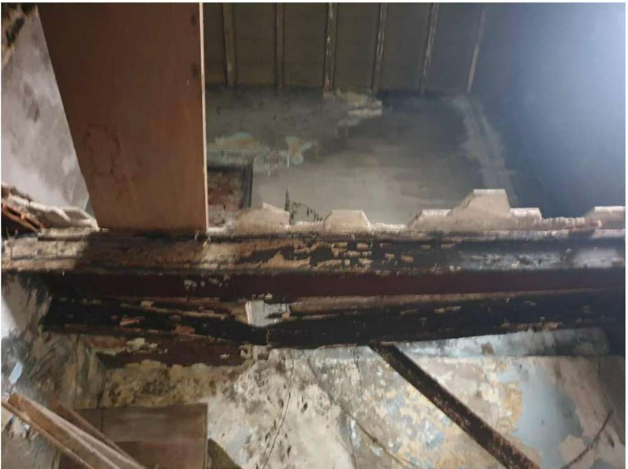
Foto 6. Interno: solaio in corrispondenza della vecchia cucina e del vano scala
