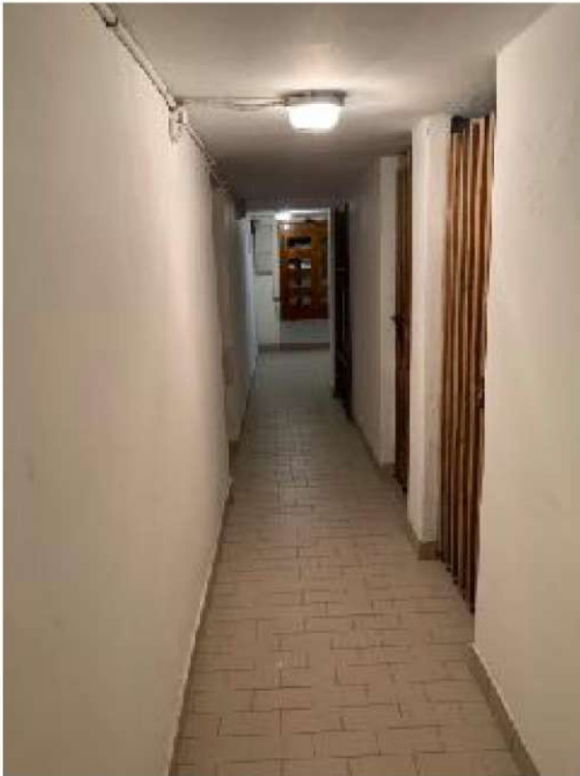
Foto 1. Zona cantine condominiali. Seminterrato
