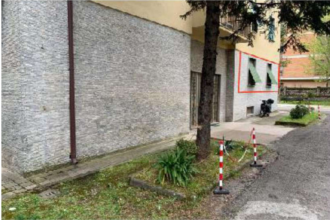
Foto E1. Fabbricato.
