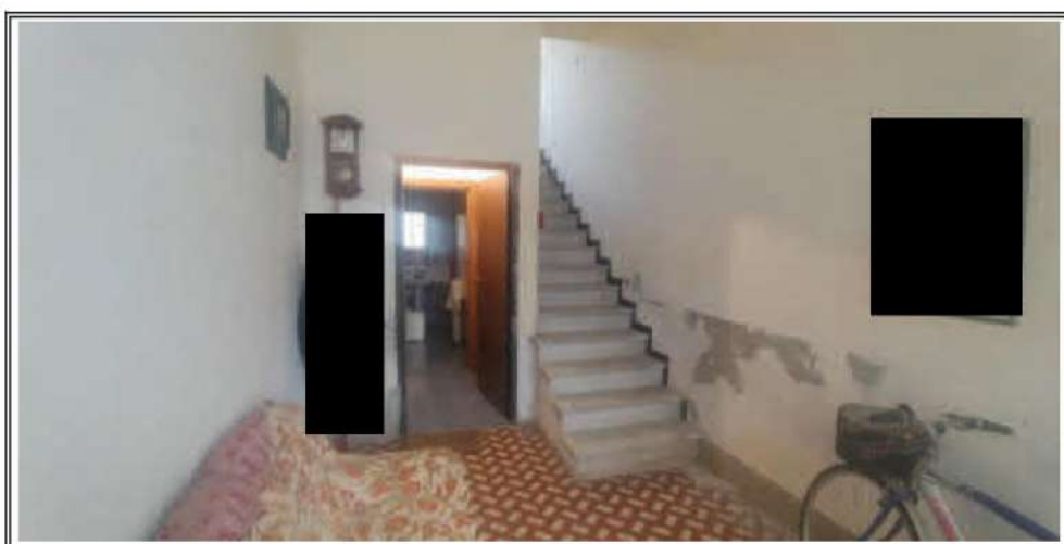
Foto n. 6 – Ingresso comune BCNC sub 24
