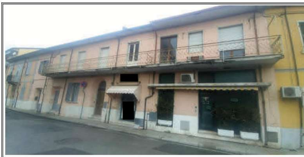
Foto n. 1 – Vista del fabbricato da Via A. Maggiani – Angolo SUD
