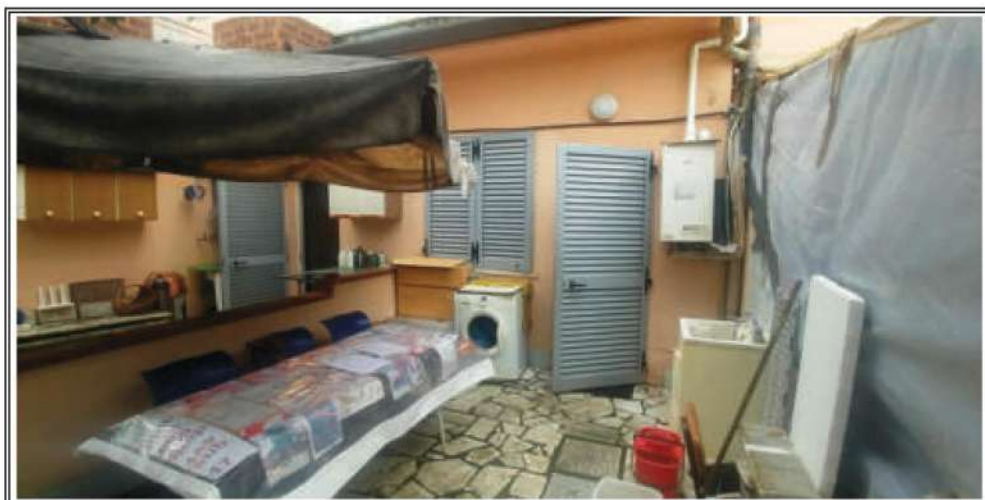
Foto n. 5 – Vista del fabbricato sul retro – Angolo NORD
