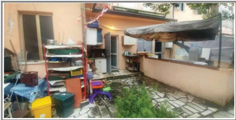
Foto n. 4 – Vista del fabbricato sul retro – Angolo EST
