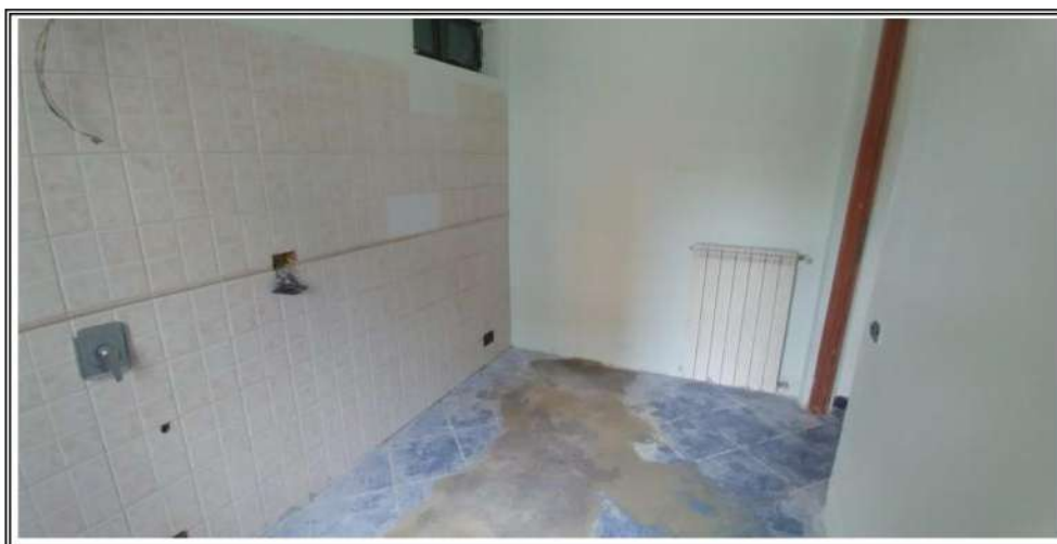
Foto n. 9 – Vano BCNC sub 24 dopo la esecuzione dei lavori edili
