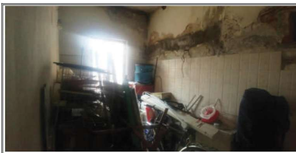
Foto n. 9 – Locale comune che fa parte del BCNC sub 24
