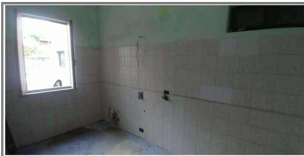
Foto n. 8 – Vano BCNC sub 24 dopo la esecuzione dei lavori edili
