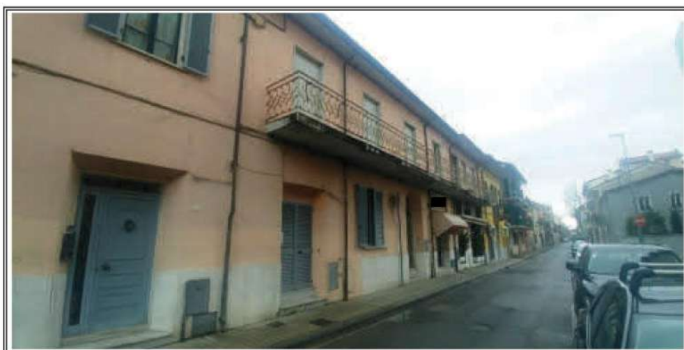
Foto n. 2 – Vista del fabbricato Via A. Maggiani – Angolo OVEST
