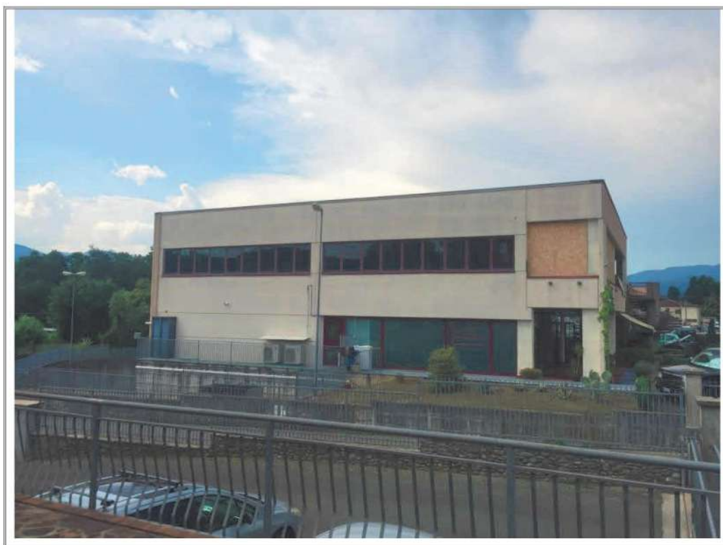
Foto n. 1 – Vista del fabbricato facciata lato SUD
