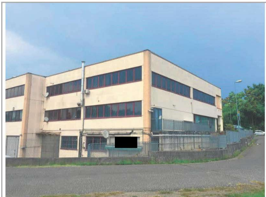
Foto n. 3 – Vista del fabbricato angolo SUD-OVEST
