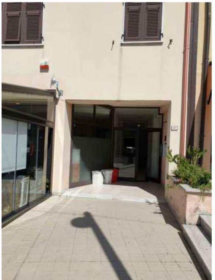
Foto 17. Ingresso al condominio da Corso Europa Unita
