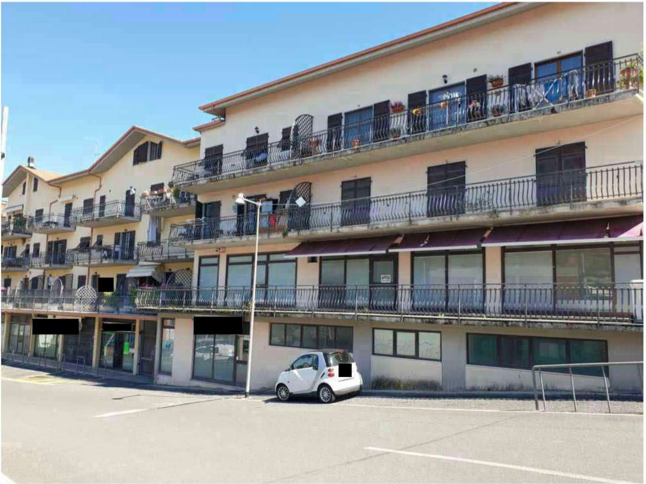
Foto 28. Esterno del condominio con evidenziato il bene stimato
