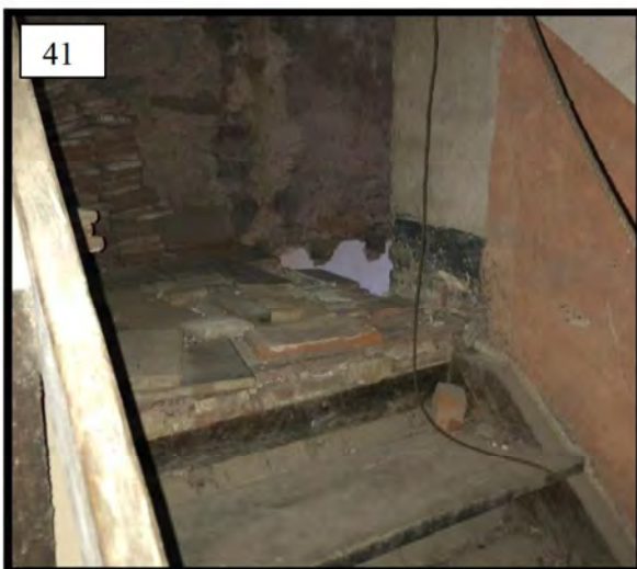
Vano sottotetto lato Ovest
