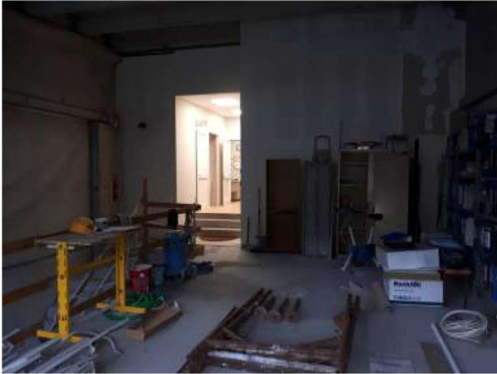
Foto n.7 – Interno, piano primo
