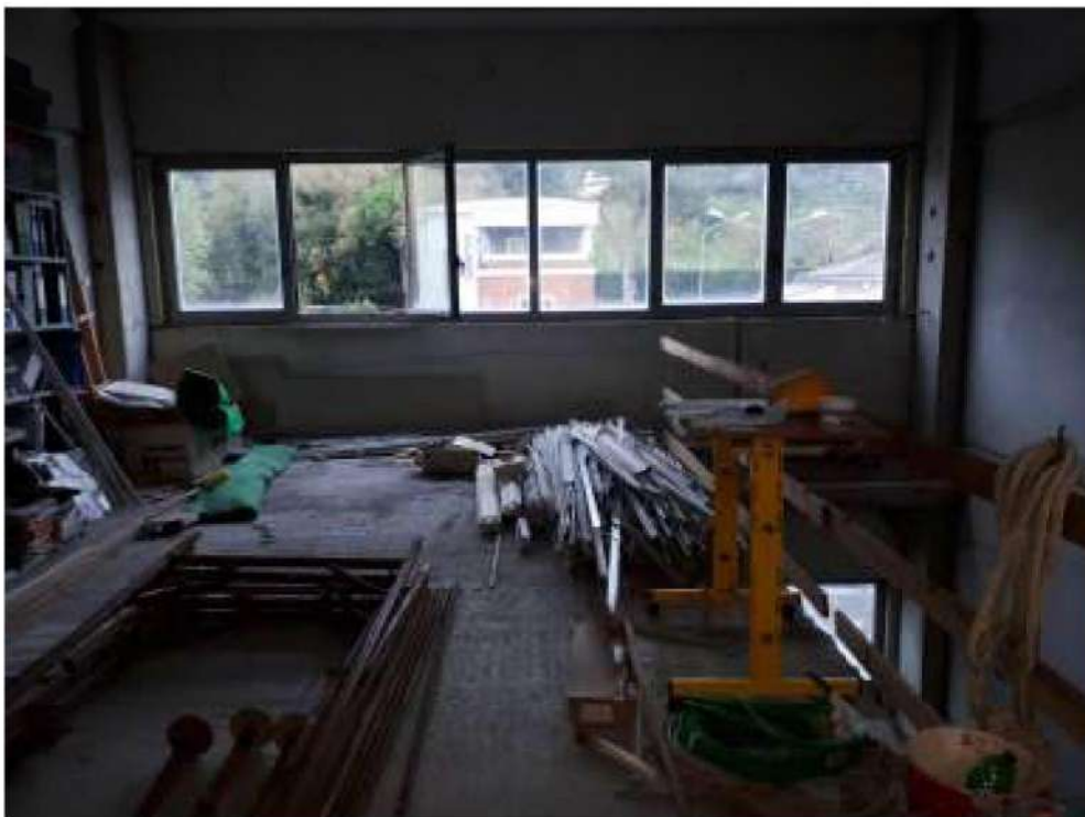
Foto n.6 – Magazzino a piano primo
