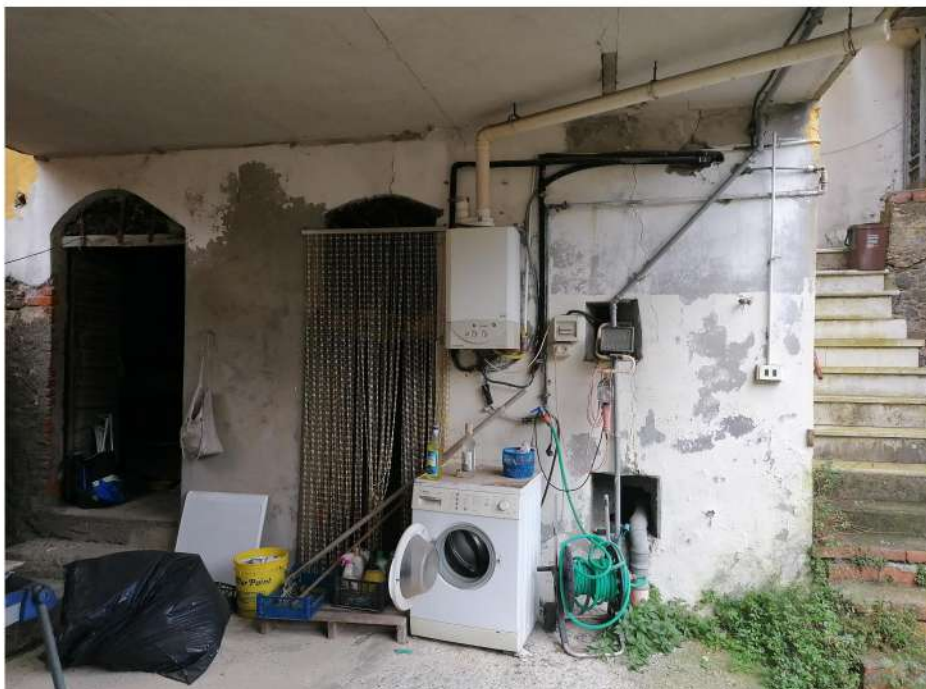
N° 8 –Vista esterna P.INT.: Ingresso cantine
