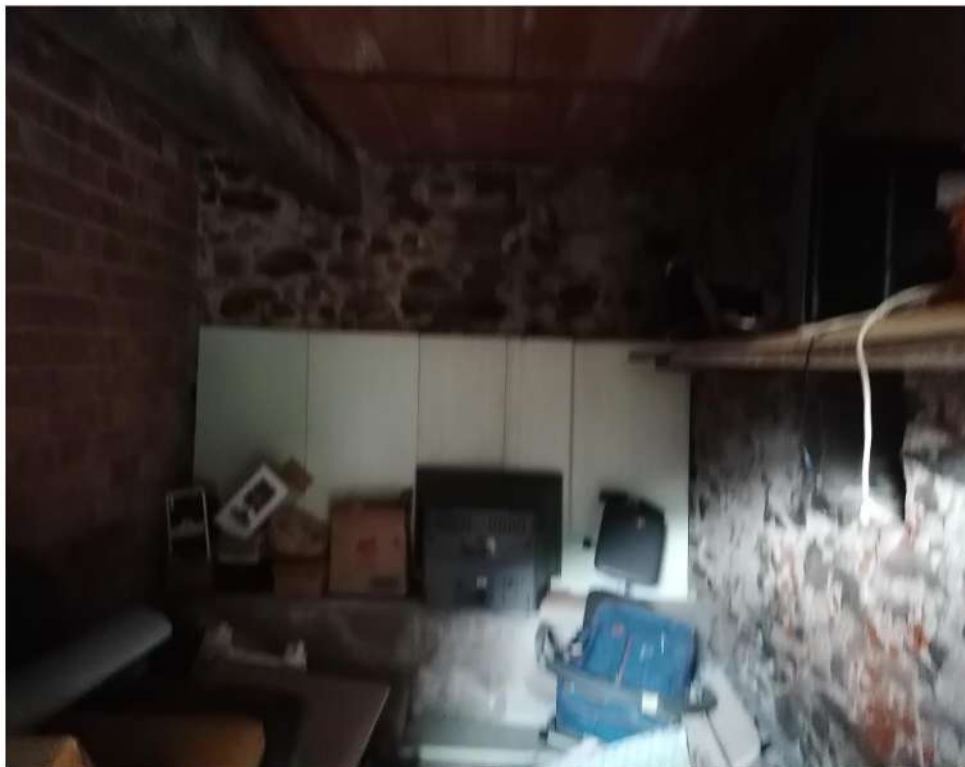
N° 10 –Vista esterna P.INT.: Cantina 2
