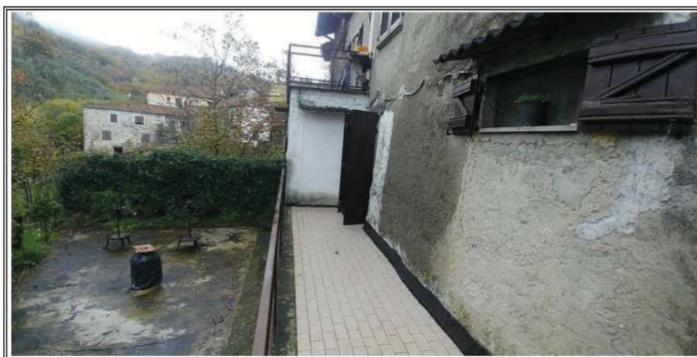
Foto n. 5 – Vista del fabbricato di cui fa parte il bene – Facciata NORD
