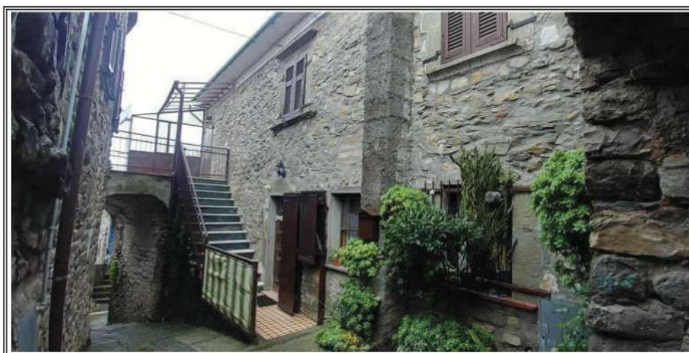
Foto n. 2 – Vista del fabbricato di cui fa parte il bene – Facciata SUD
