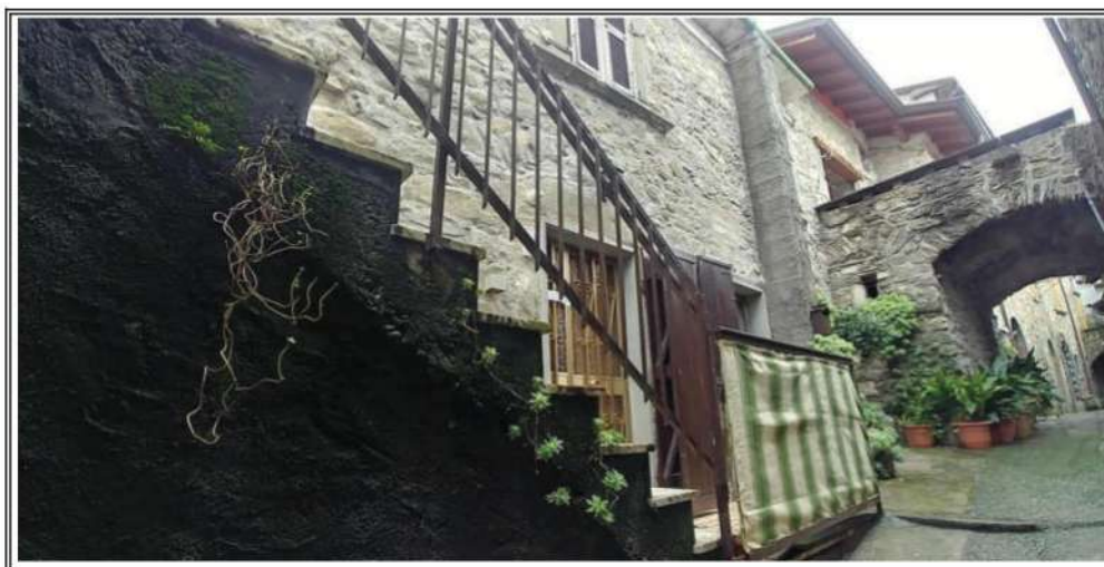
Foto n. 4 – Vista del fabbricato di cui fa parte il bene – Facciata SUD
