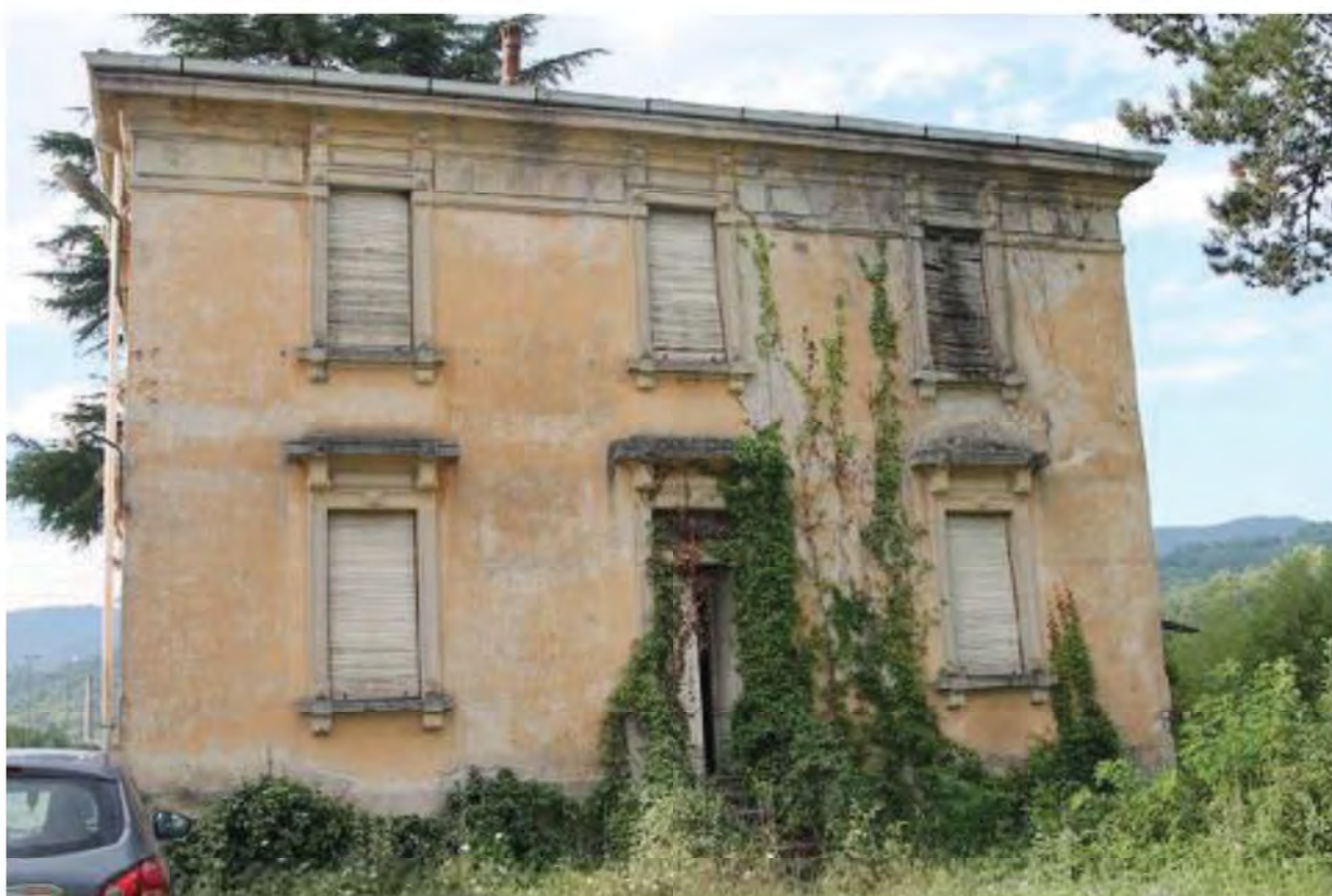
Foto 4. Fabbricato 2 prospetti nord-nord-ovest
