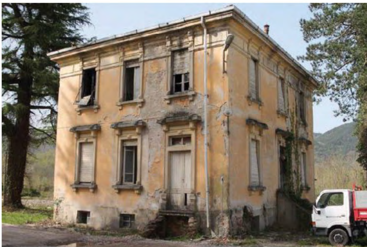
Foto 1. Fabbricato 2 prospetti nord-nord-ovest e est-nord-est
