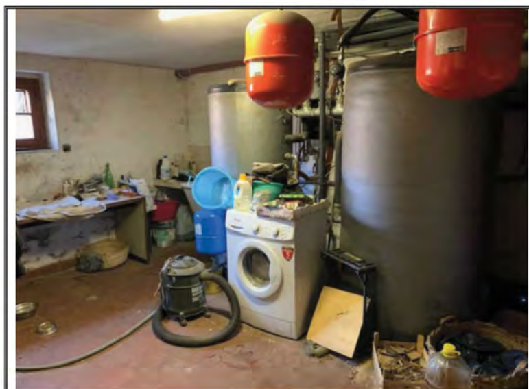
Foto n. 21 – Appartamento sub. 1 – Piano interrato (secondo sottostrada)
