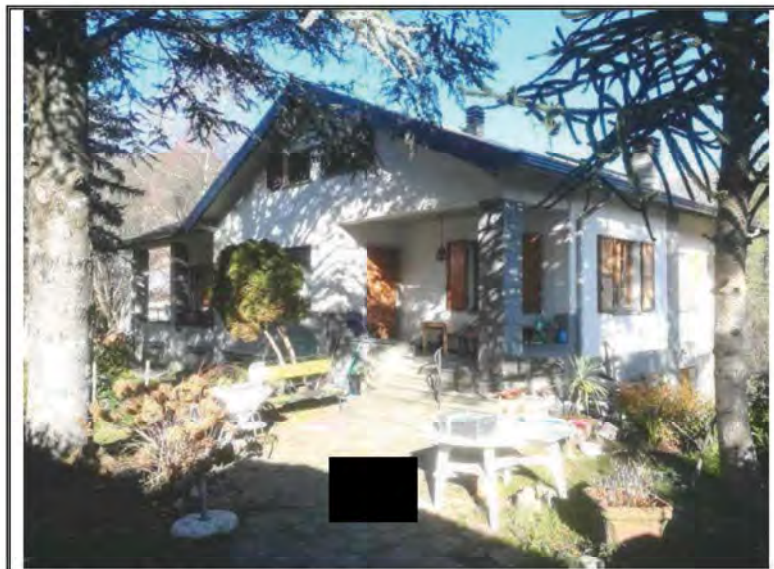
Foto n. 2 – Vista del fabbricato – Angolo SUD
