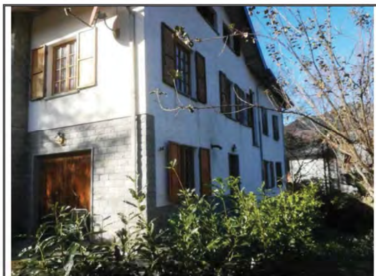
Foto n. 3 – Vista del fabbricato – Angolo EST
