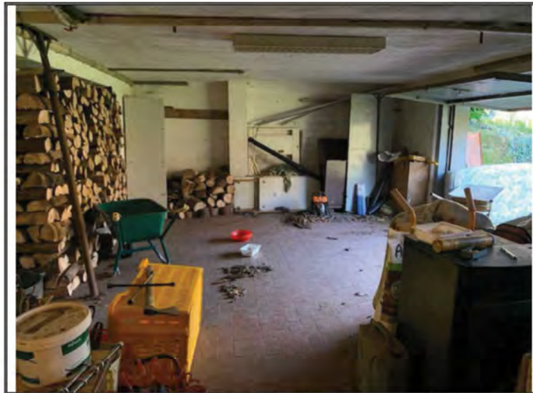
Foto n. 19 – Appartamento sub. 1 – Piano interrato (secondo sottostrada)
