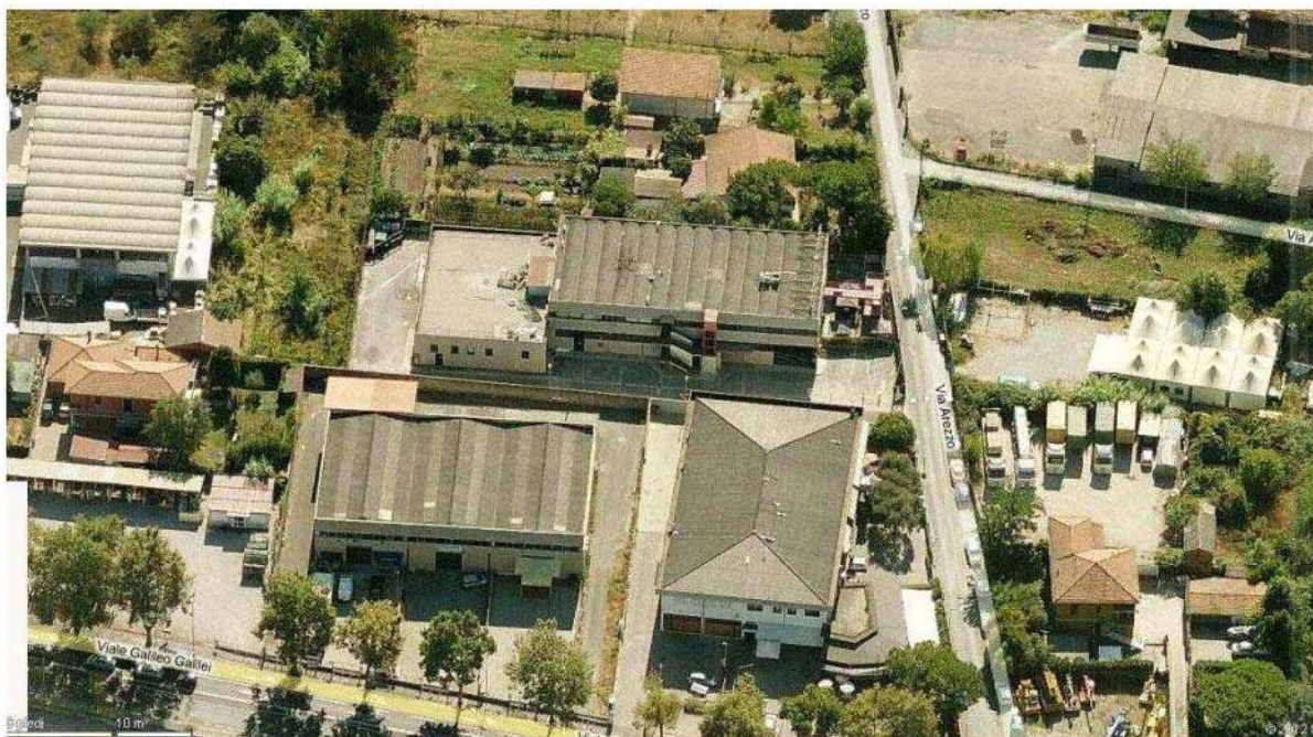
- Foto n° 3 – Ripresa Aerea - Prospetto lato Spezia.-
