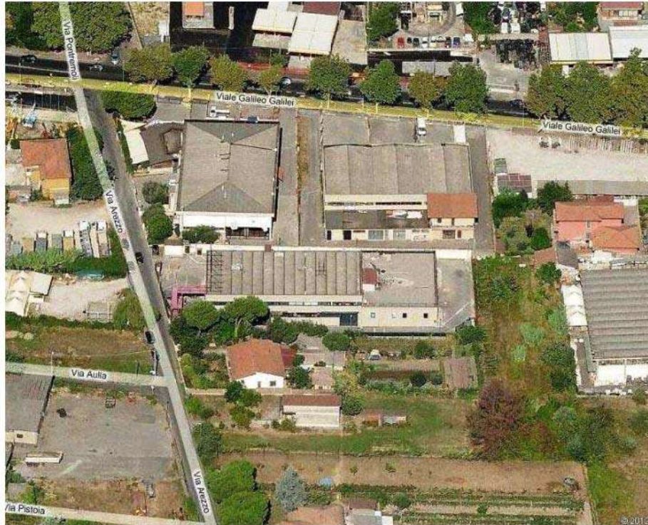
- Foto n° 5 – Ripresa Aerea - Prospetto lato Viareggio.-
