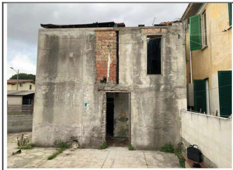
Foto n. 6 – Porzione mappale 128 subalterno 8
