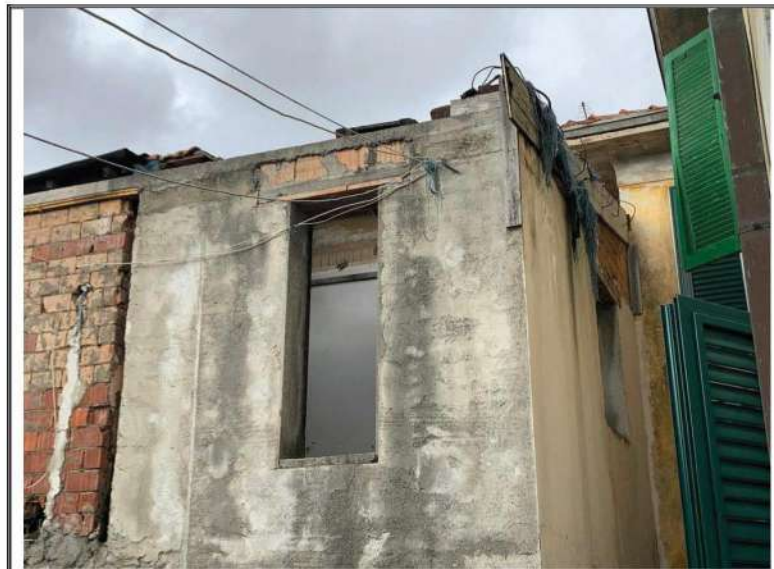
Foto n. 8– Porzione mappale 128 subalterno 9 - particolare
