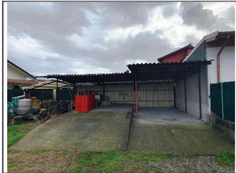
Foto n. 19 – Tettoia mappale 497 sub 3
