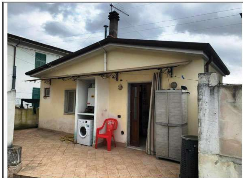
Foto n. 2 – Porzione mappale 128 subalterno 4
