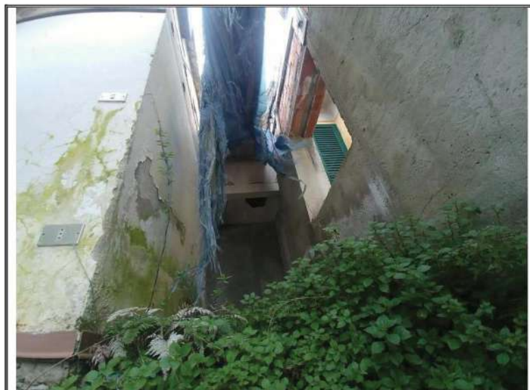
Foto n. 12 – Porzione mappale 128 subalterno 9 – Disimpegno
