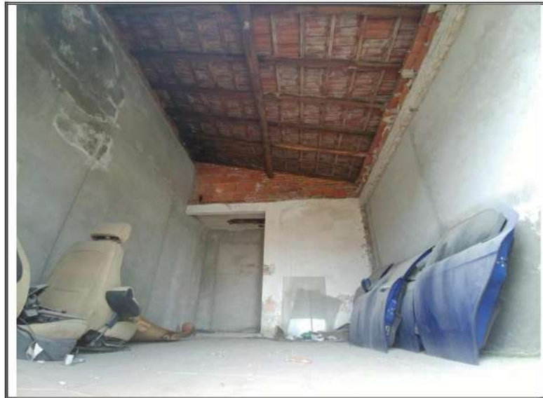
Foto n. 13 – Porzione mappale 128 subalterno 9–Vano al P1
