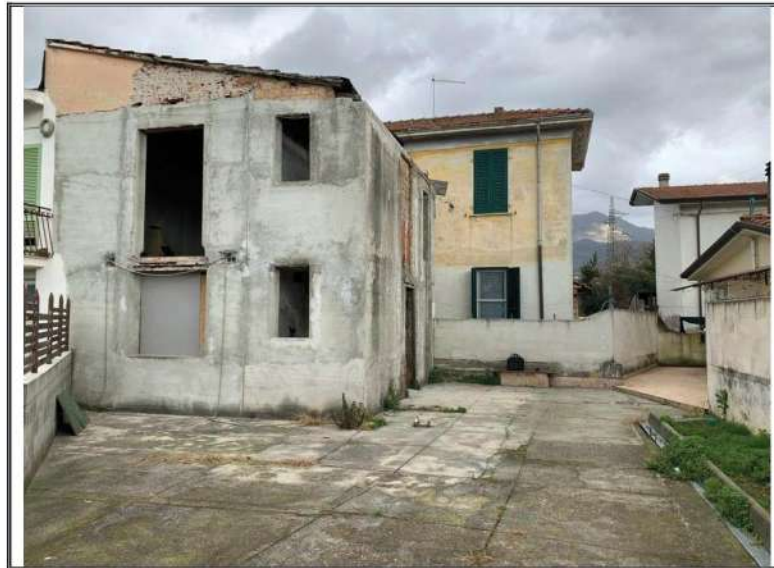
Foto n. 7 – Porzione mappale 128 subalterno 9– angolo SUD
