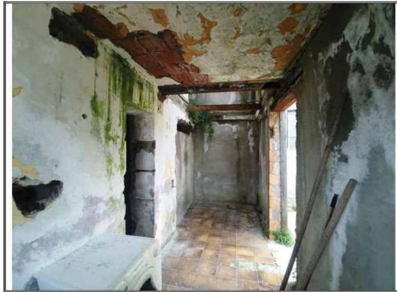
Foto n. 10 – Porzione mappale 128 subalterno 9–Ingresso al PT
