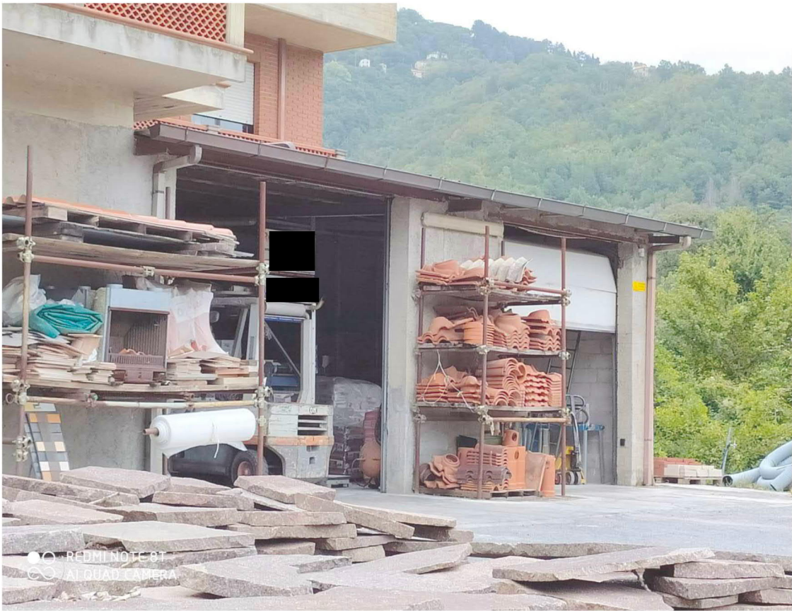
FOTO 3, 4 - Corpi in ampliamento lato SUD-EST e OVEST
