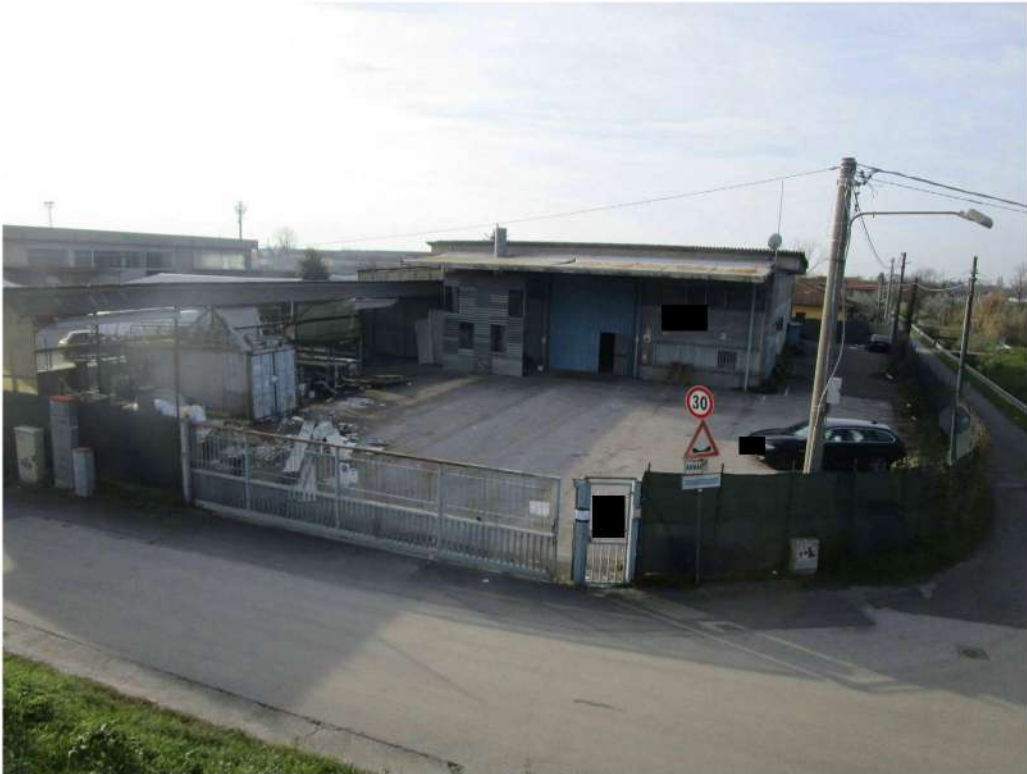
N° 3 – Vista esterna frontale: da Via del Parmignola
