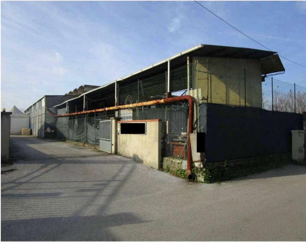
N° 5 – Vista esterna laterale: da Via del Parmignola
