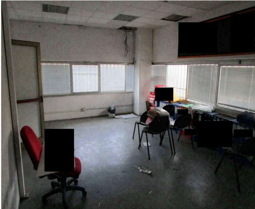
N° 13 – Vista interna P.T.: Sala di attesa
