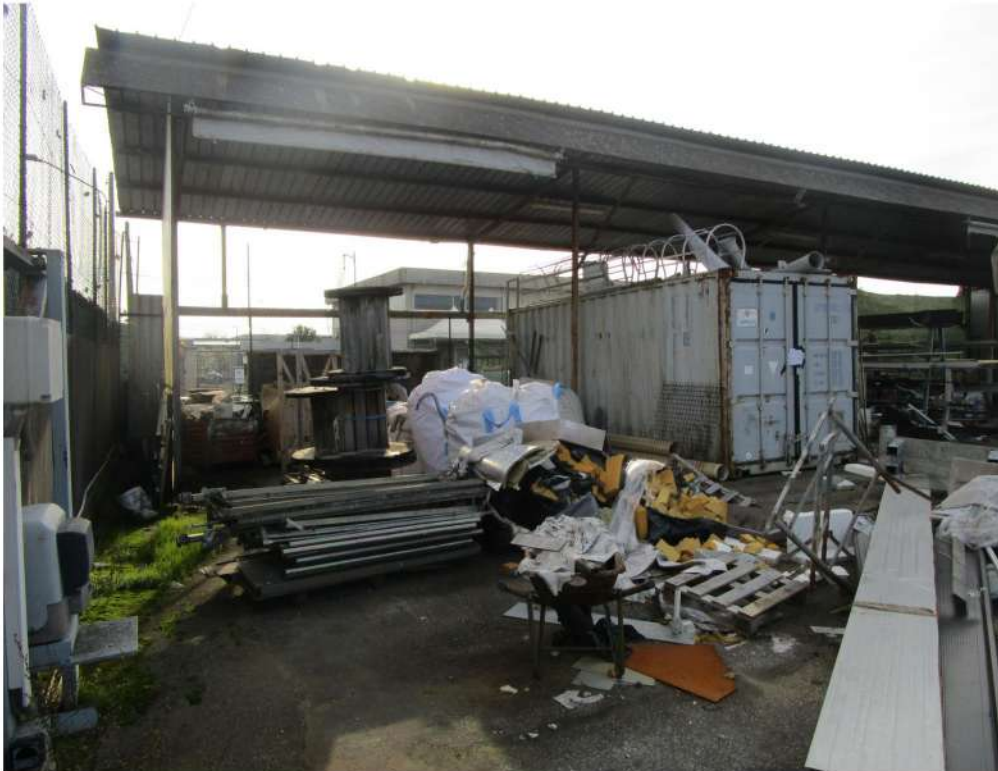
N° 21 – Vista esterna: Tettoia
