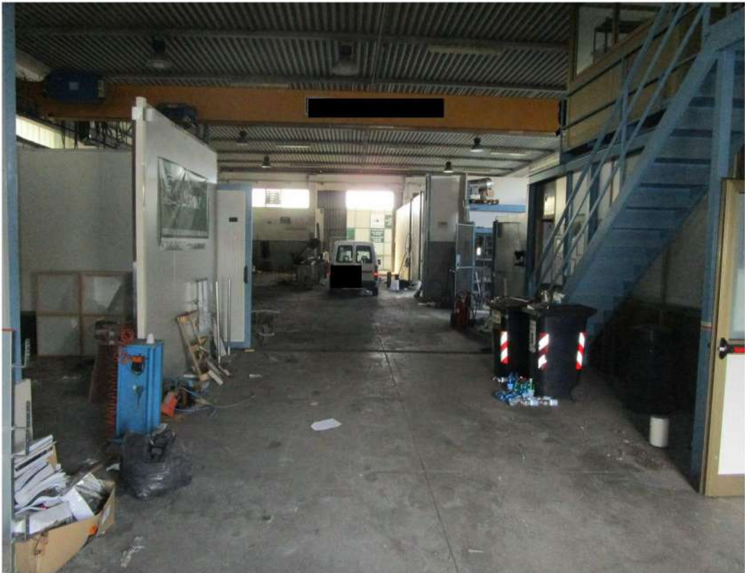
N°7 – Vista Interna P.T.: dall'ingresso
