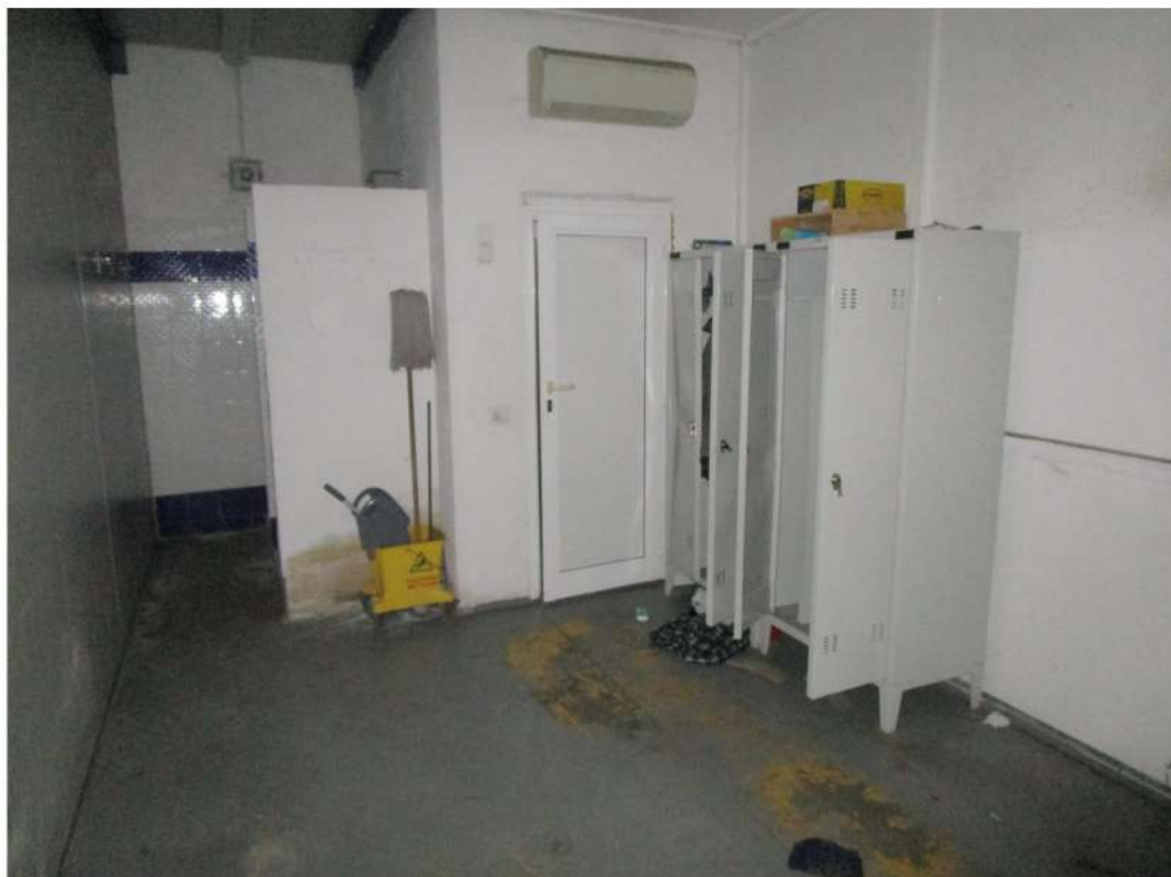
N° 14 – Vista interna P.T.: Spogliatoio
