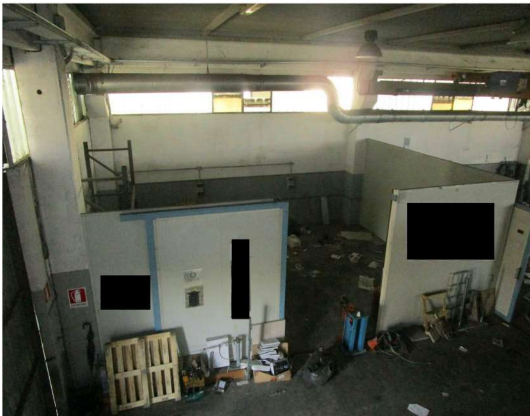
N° 9 – Vista interna P.T.: Reparto Stoccaggio
