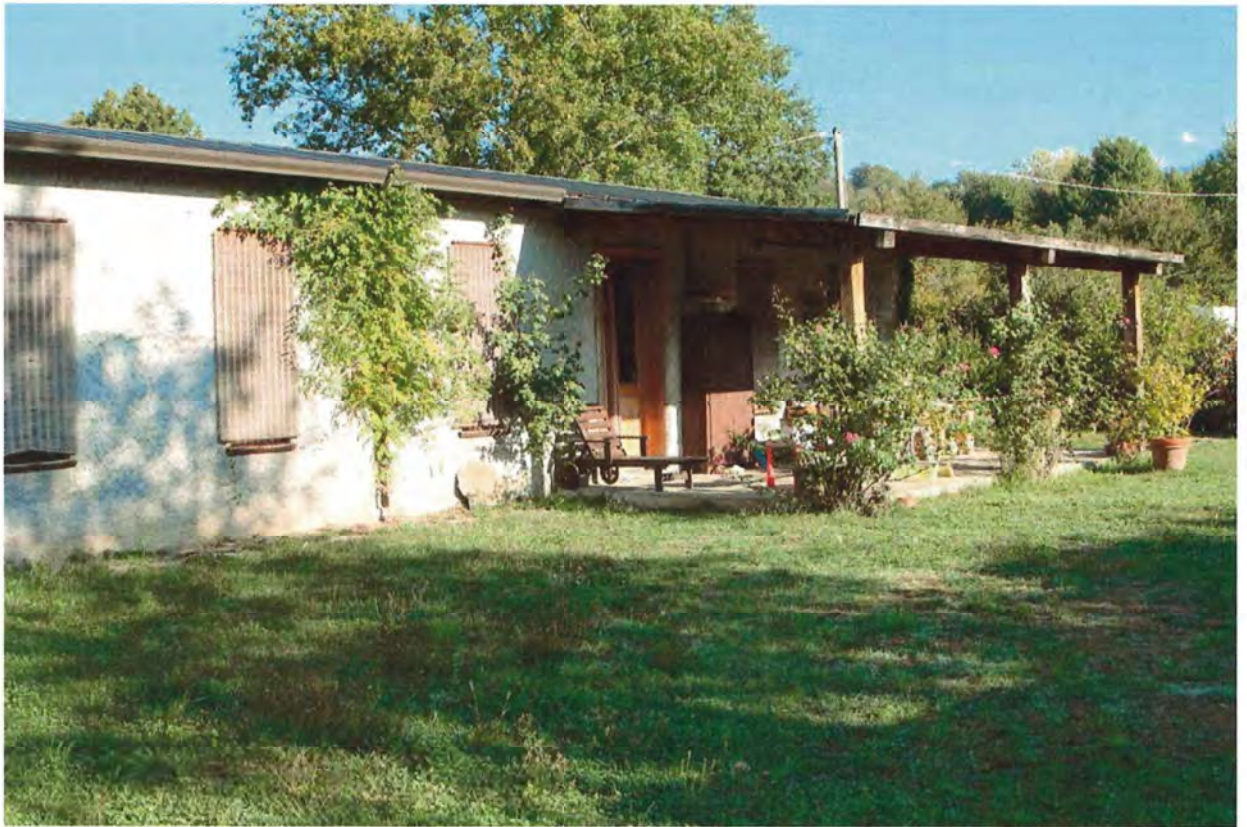
Foto 45. Esterno fabbricato sud-est
