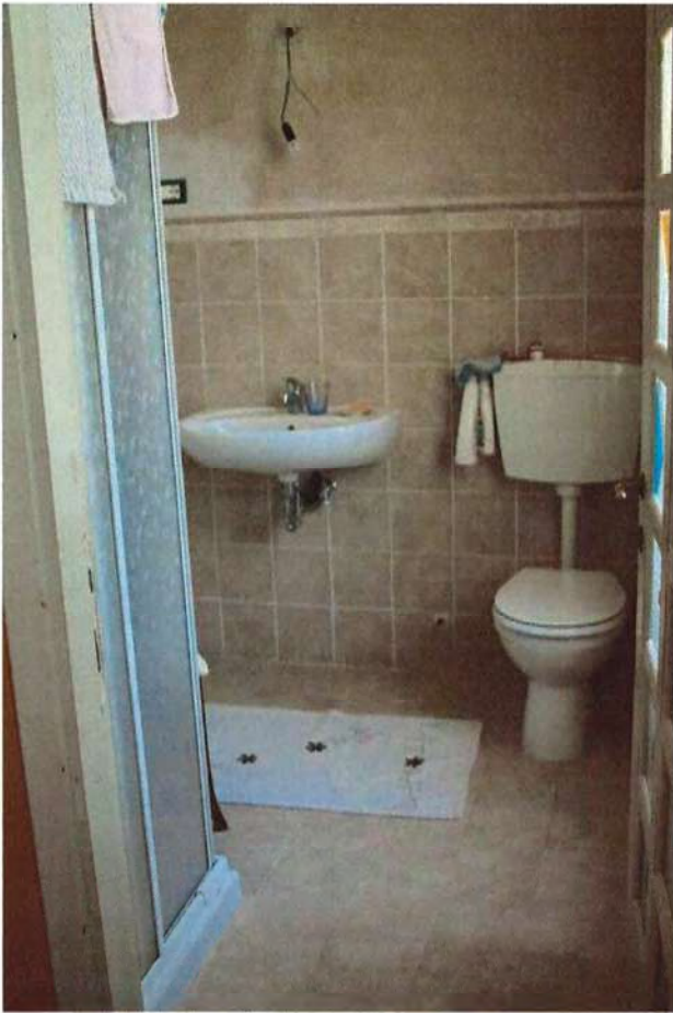
Foto 22. Bagno corpo 2, sub.7
