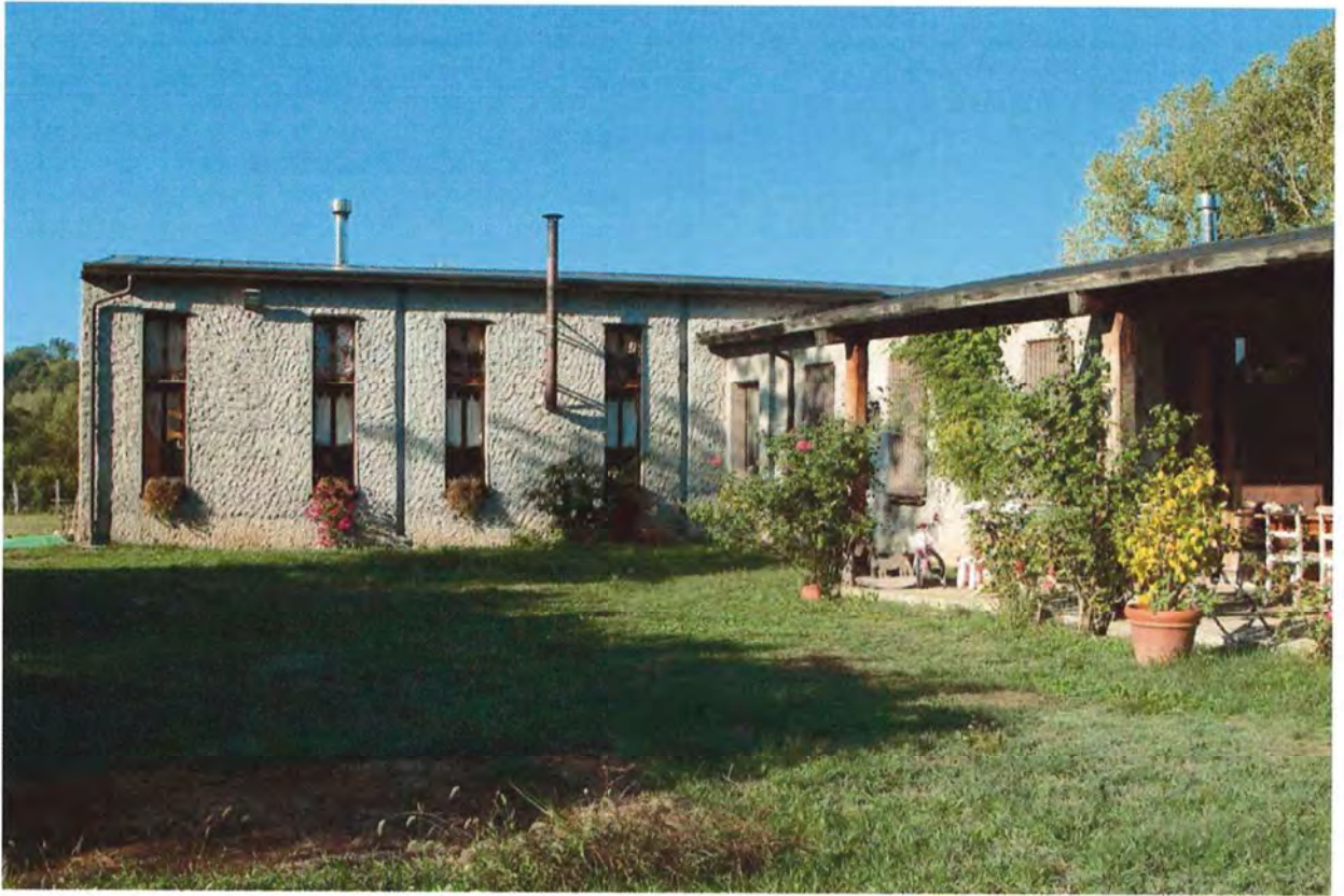
Foto 41. Esterno fabbricato sud-est
