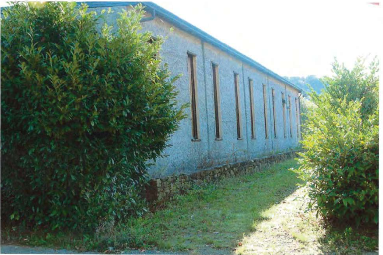
Foto 42. Esterno fabbricato sud-ovest
