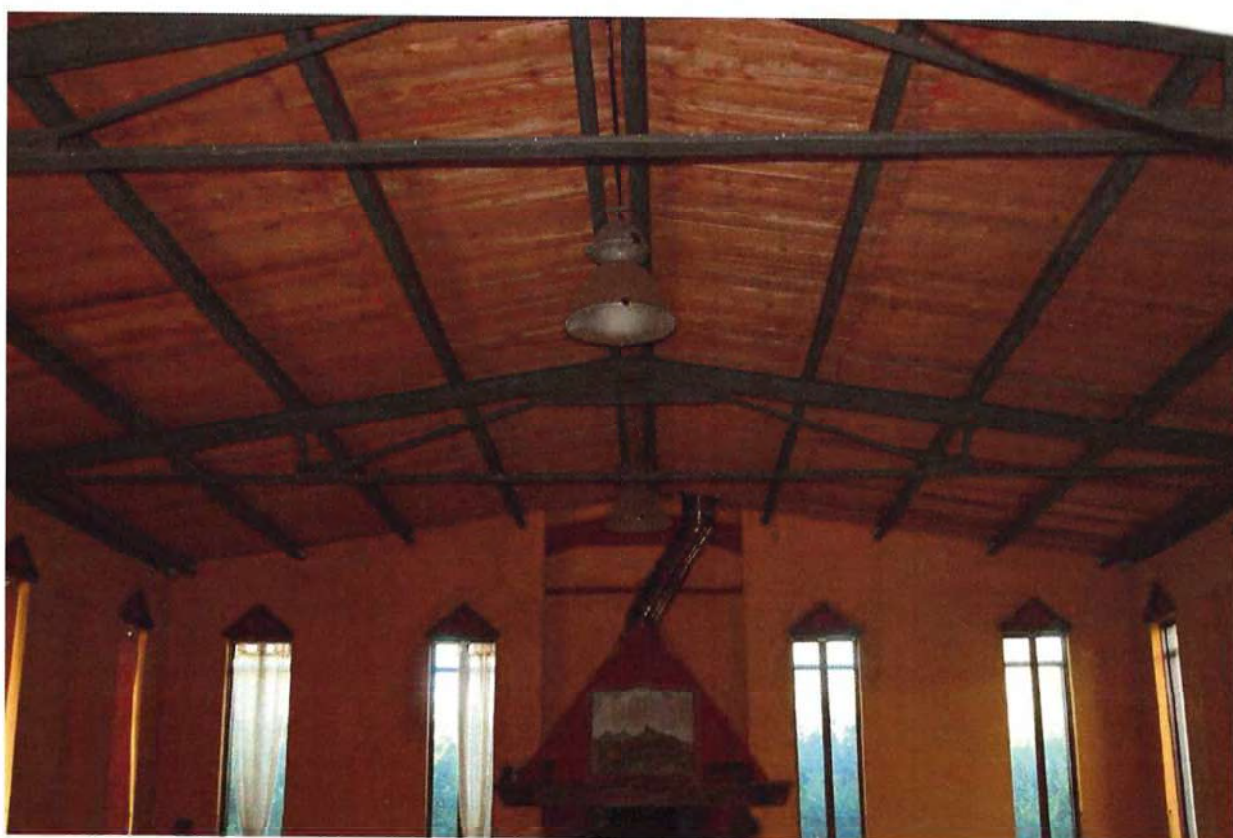
Foto 27 e 28. Magazzino corpo 3, sub.8
