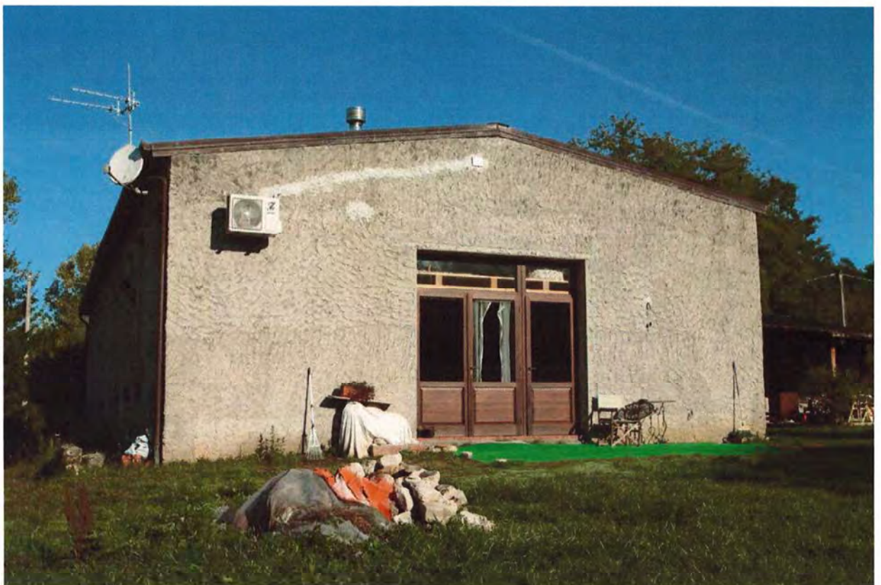
Foto 46. Esterno fabbricato sud-est
