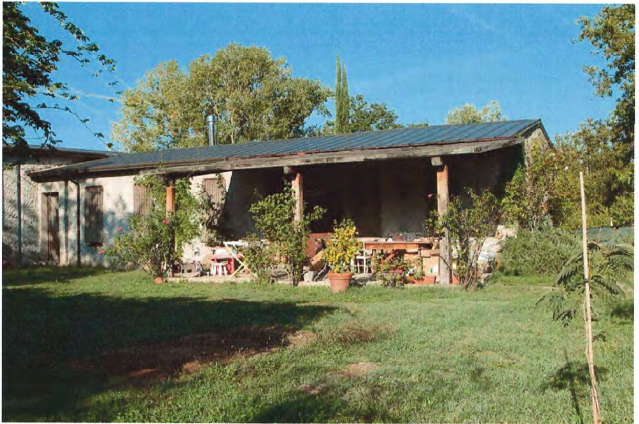
Foto 47. Esterno fabbricato sud-est
