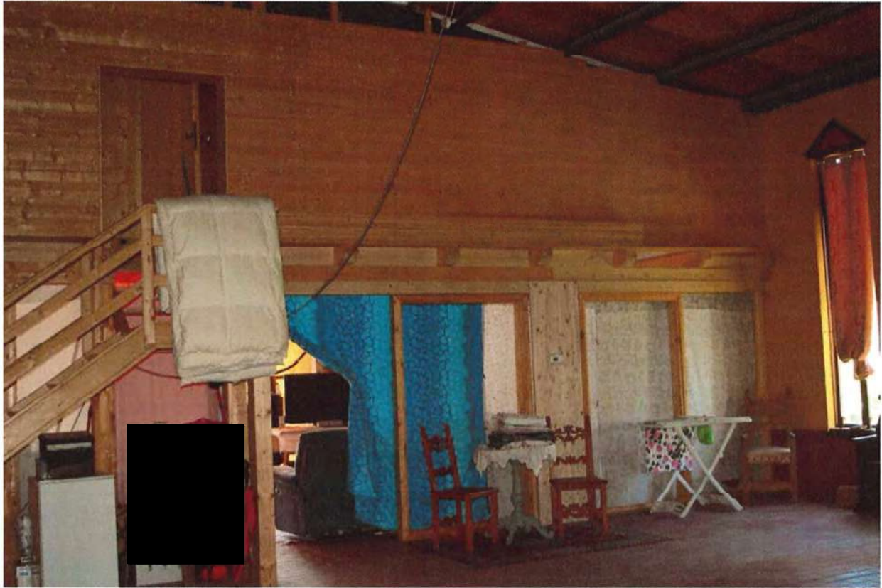
Foto 31. Magazzino corpo 3, sub.8
