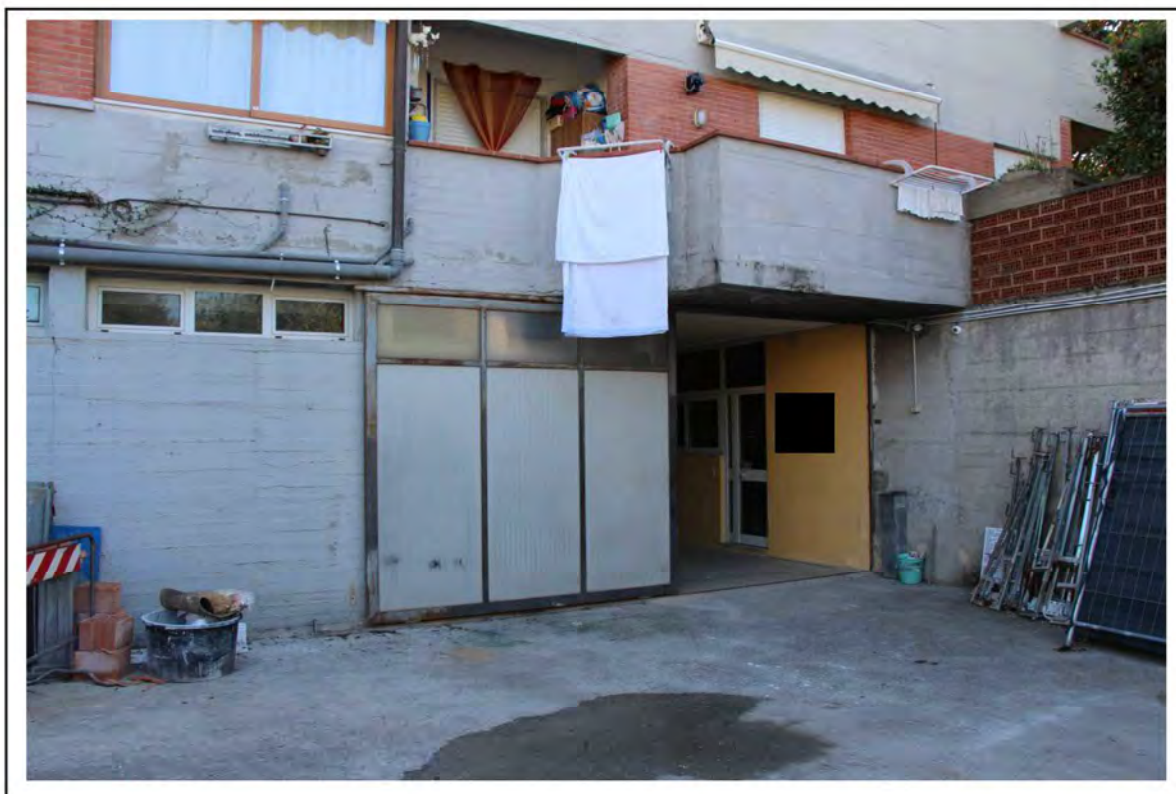
Veduta esterna del compendio (ingresso foglio 89 mappale 398 sub. 1 e 188 sub.14)
