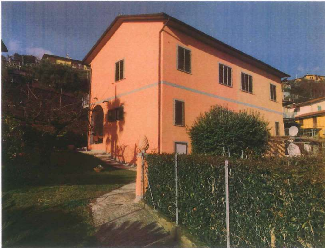
Foto n° 1 : Vista Lato Mare Carrara
