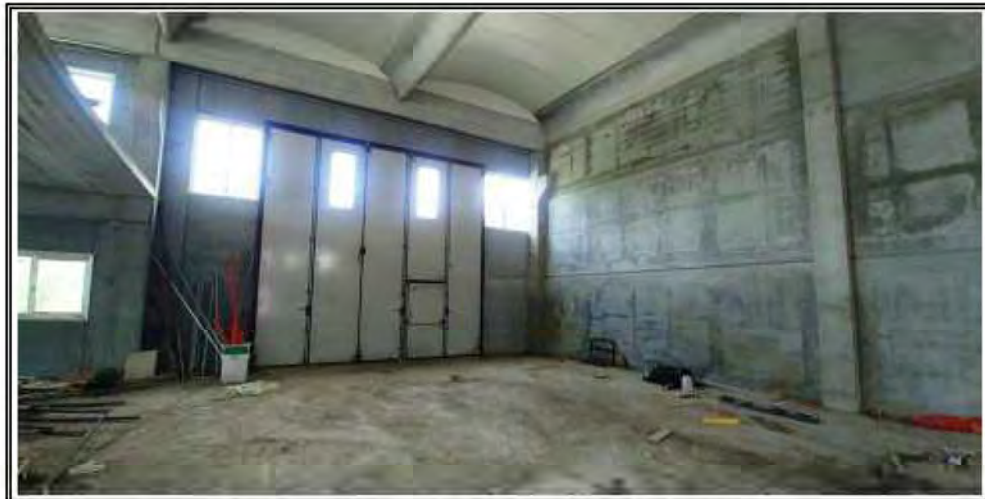
Foto n. 8 – Capannone fg 24 mapp 1813 sub.1 – Immobile 1
