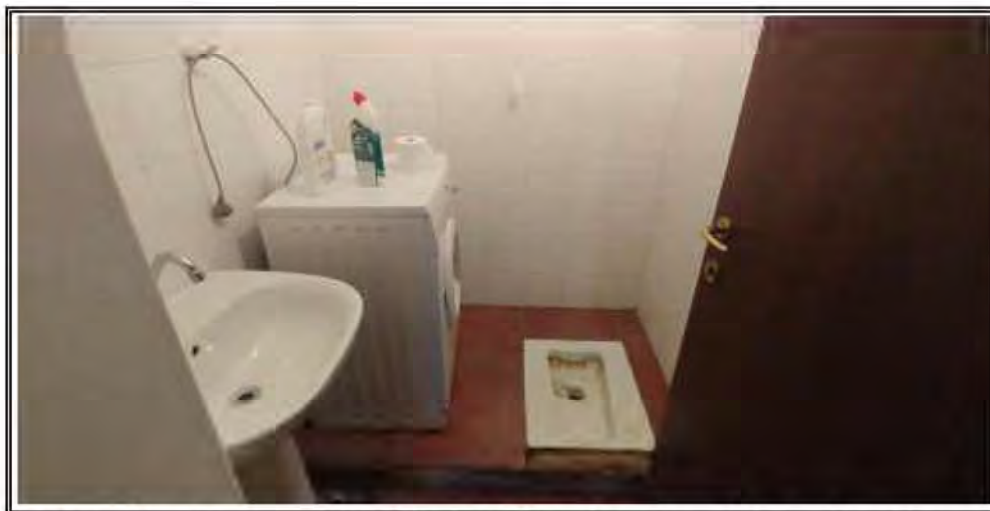
Foto n. 19 – Capannone fg 24 mapp 1813 sub.4 – Immobile 3 – Piano terra
