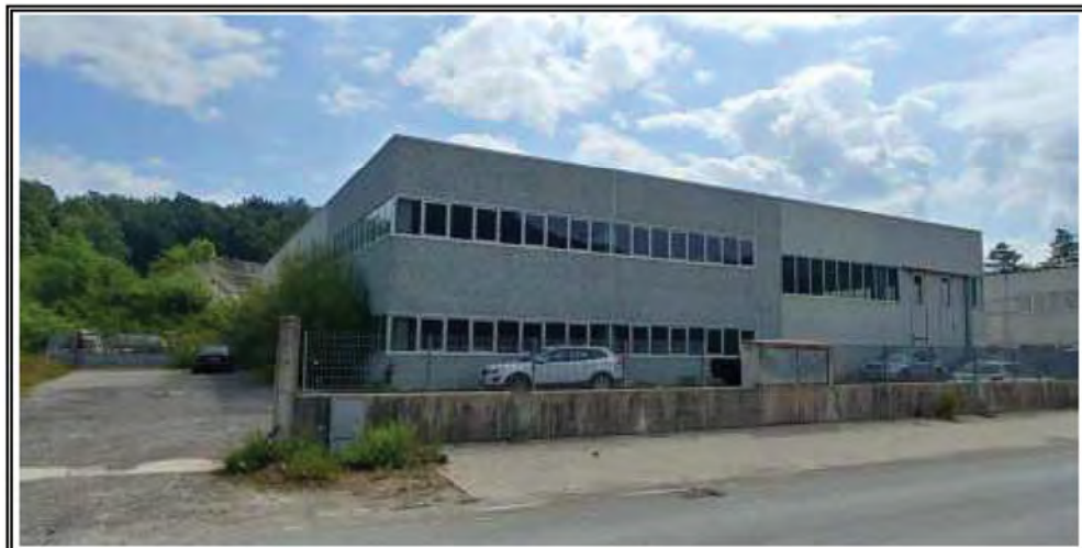
Foto n. 2 – Capannone fg 24 mapp 1813 – Vista angolo nord-ovest
