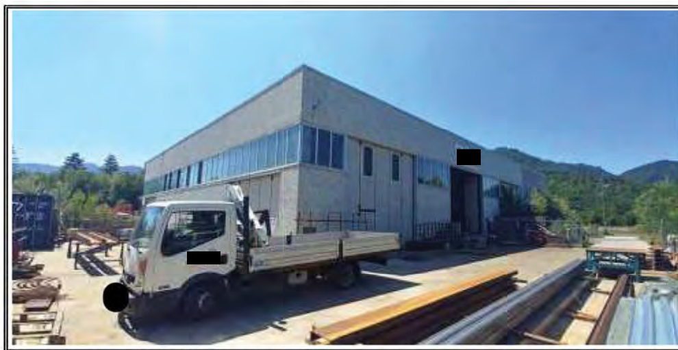
Foto n. 4 – Capannone fg 24 mapp 1813 – Vista angolo nord-est
