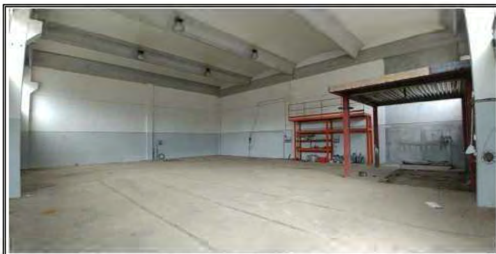
Foto n. 11 – Capannone fg 24 mapp 1813 sub.3 – Immobile 2
