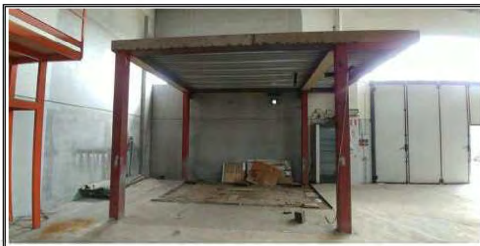
Foto n. 12 – Capannone fg 24 mapp 1813 sub.3 – Immobile 2
