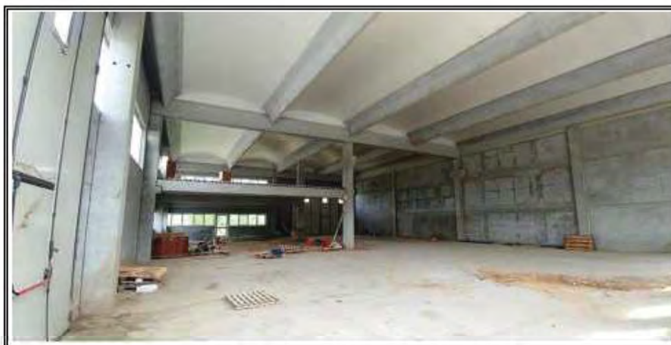
Foto n. 6 – Capannone fg 24 mapp 1813 sub.1 – Immobile 1
