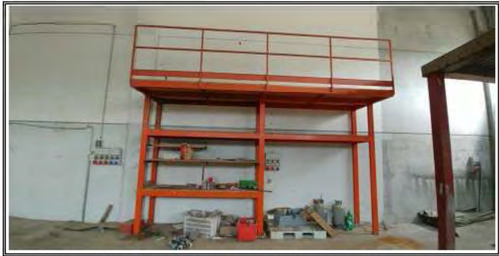
Foto n. 13 – Capannone fg 24 mapp 1813 sub.3 – Immobile 2
