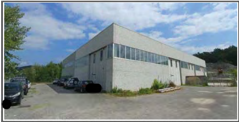
Foto n. 1 – Capannone fg 24 mapp 1813 – Vista angolo sud-ovest
