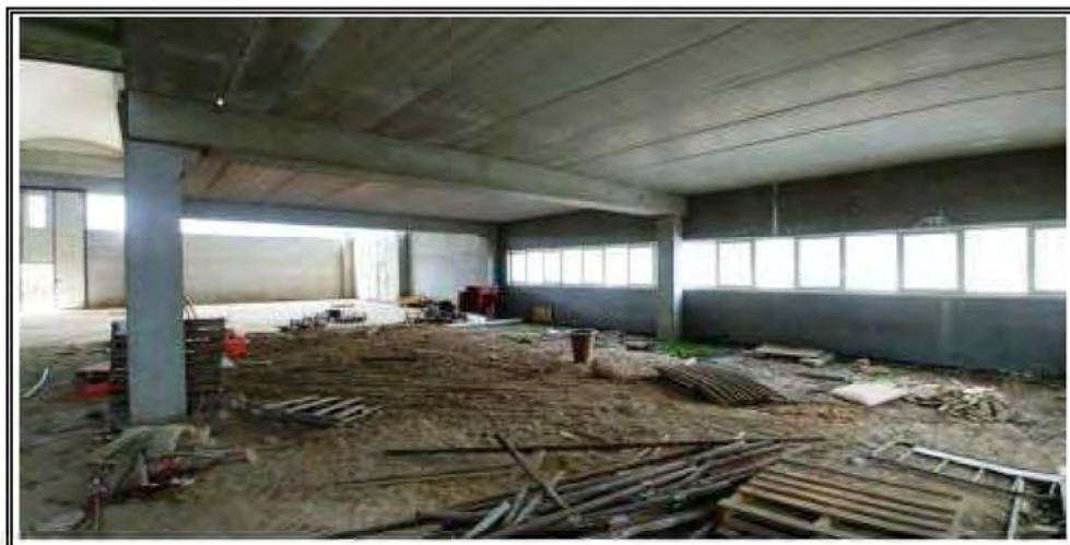
Foto n. 9 – Capannone fg 24 mapp 1813 sub.1 – Immobile 1
