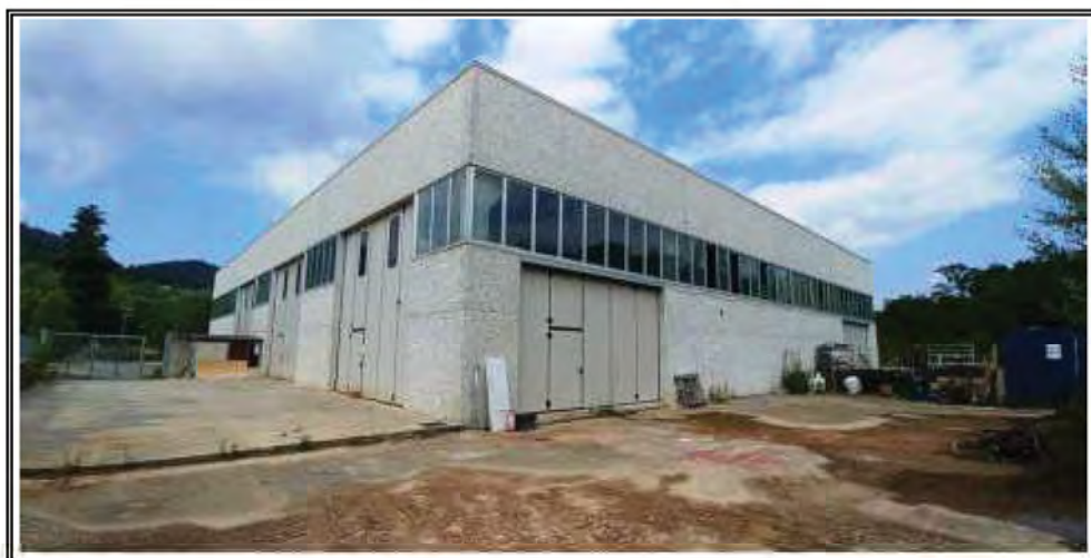
Foto n. 3 – Capannone fg 24 mapp 1813 – Vista angolo sud-est
