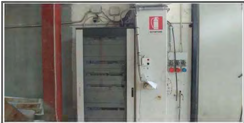
Foto n. 14 – Capannone fg 24 mapp 1813 sub.3 – Immobile 2
