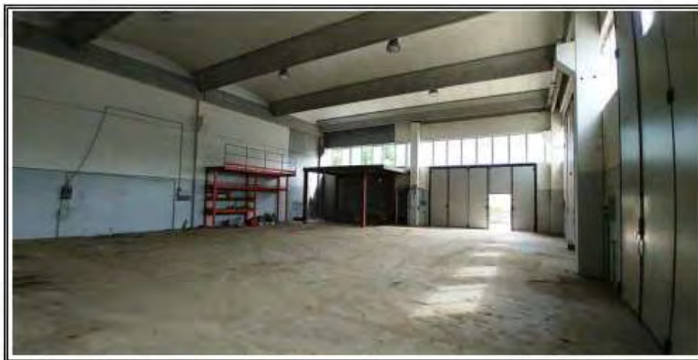
Foto n. 10 – Capannone fg 24 mapp 1813 sub.3 – Immobile 2
