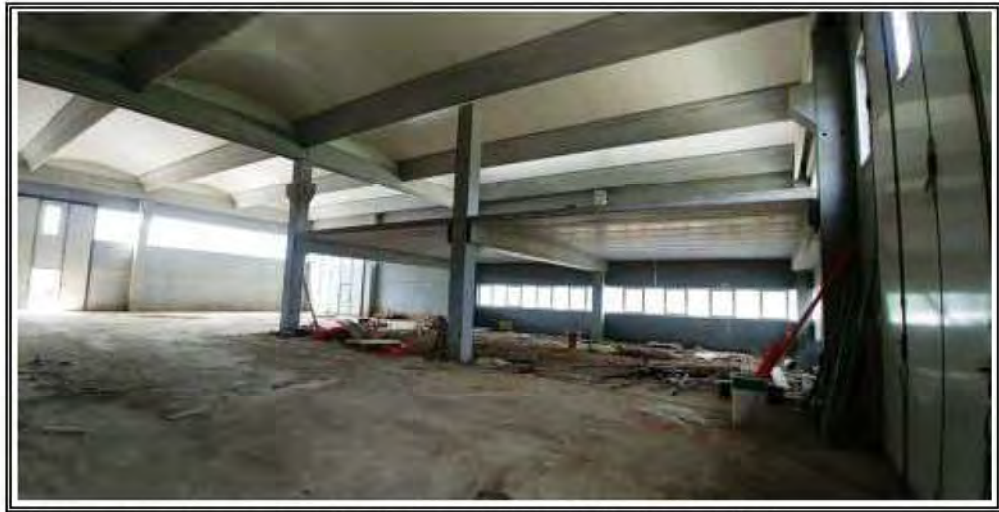
Foto n. 7 – Capannone fg 24 mapp 1813 sub.1 – Immobile 1
