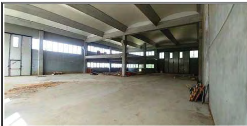
Foto n. 5 – Capannone fg 24 mapp 1813 sub.1 – Immobile 1
