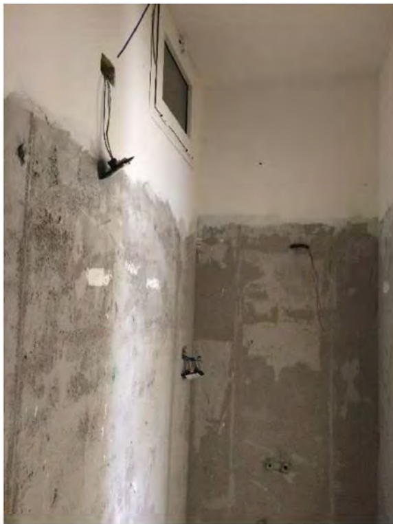
FOTO 65: VISTA INTERNA – PIANO PRIMO SOTTOSTRADA - BAGNO
