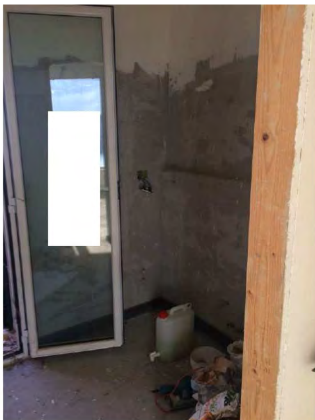
FOTO 74: PIANO TERRA - BAGNO
