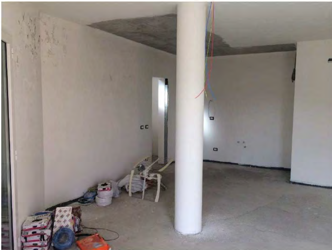
FOTO 64: VISTA INTERNA – PIANO PRIMO SOTTOSTRADA
