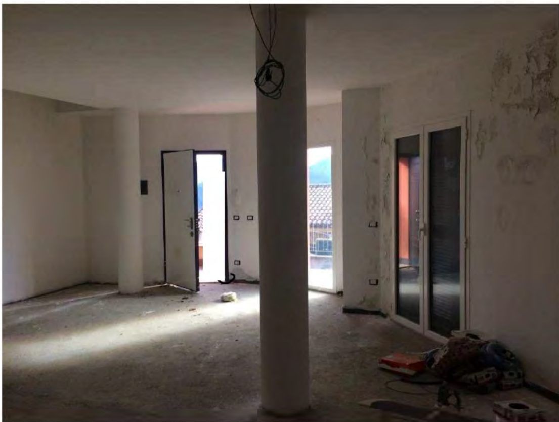
FOTO 62: VISTA INTERNA – PIANO PRIMO SOTTOSTRADA
