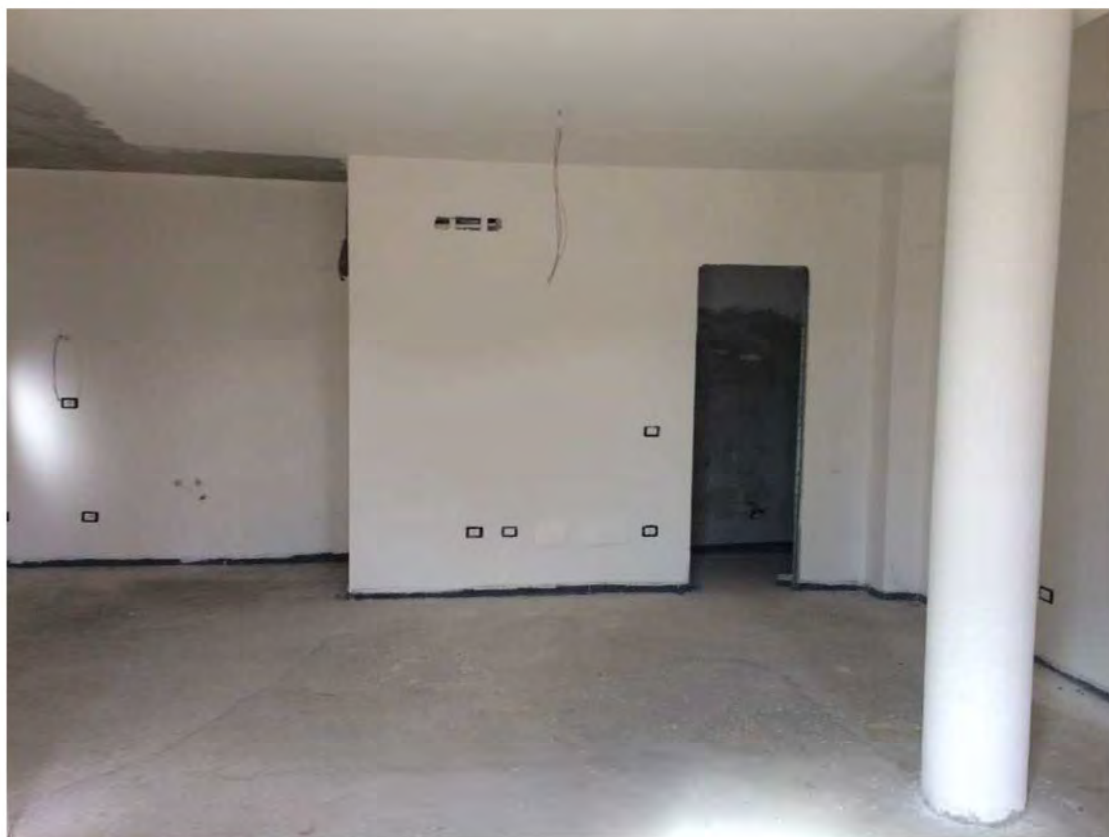
FOTO 63: VISTA INTERNA – PIANO PRIMO SOTTOSTRADA
