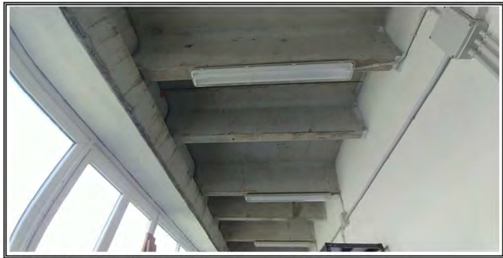
Foto n. 19 – Subalterno 4 – Piano Terra – Particolare struttura
