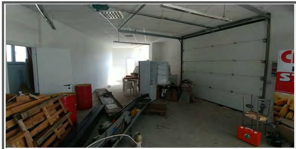
Foto n. 17 – Subalterno 4 – Piano Terra – Ambiente principale
