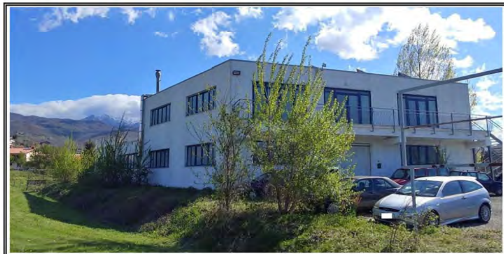
Foto n. 2 – Vista del fabbricato – Angolo OVEST
