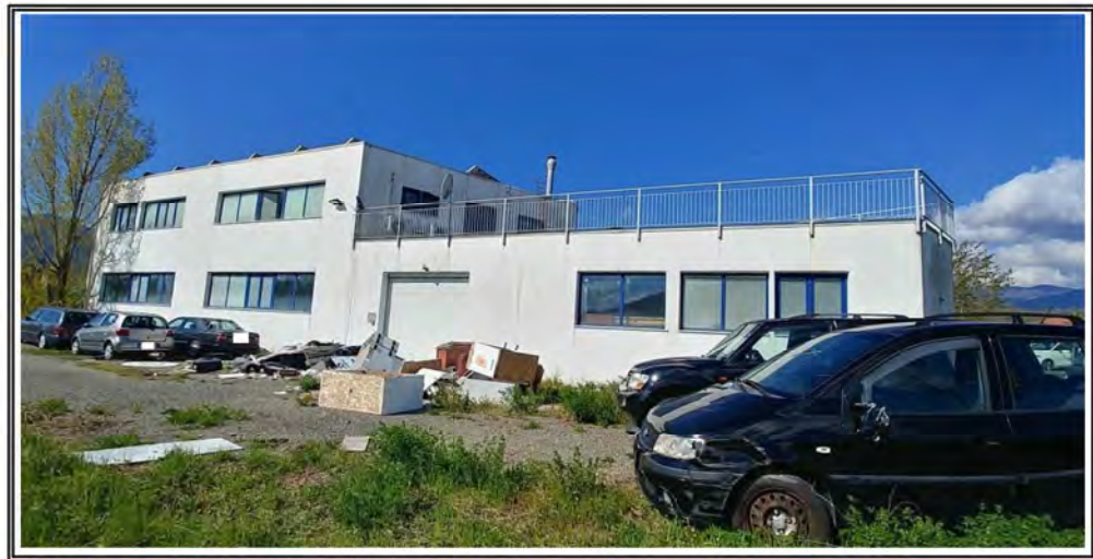
Foto n. 4 – Vista del fabbricato – Facciata lato EST
