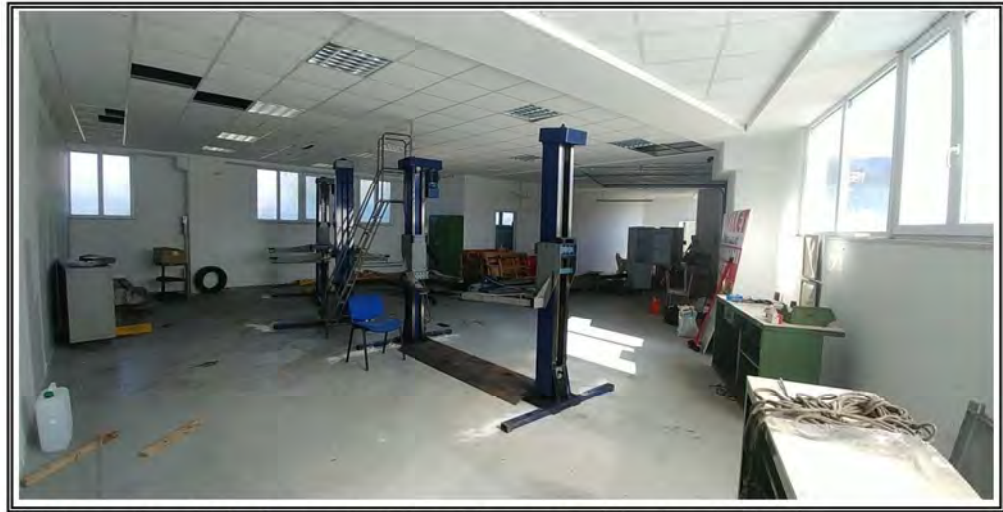
Foto n. 16 – Subalterno 4 – Piano Terra – Ambiente principale
