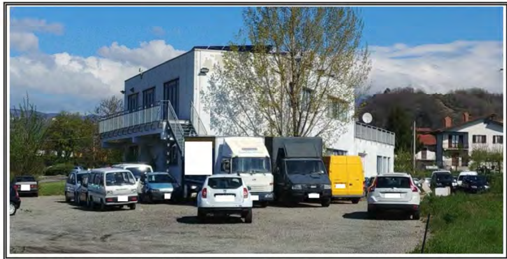
Foto n. 1 – Vista del fabbricato – Angolo SUD
