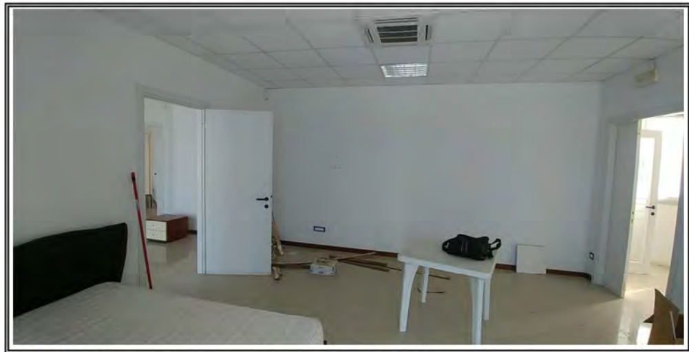
Foto n. 7 – Subalterno 3 – Piano Primo - Ufficio
