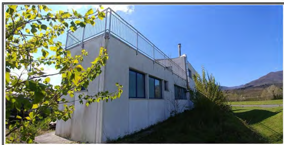
Foto n. 3 – Vista del fabbricato – Angolo NORD
