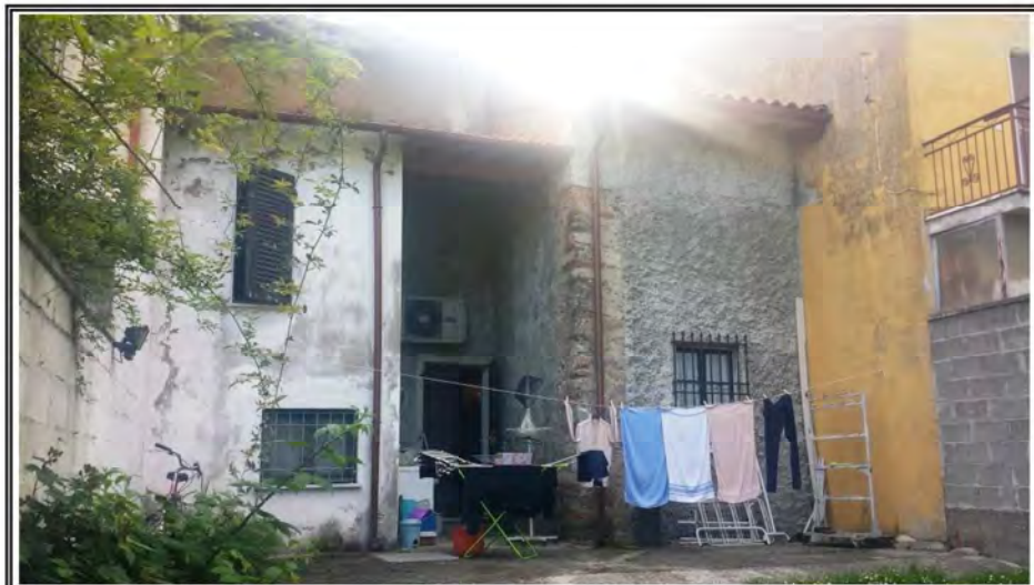
Foto n. 4 – Facciata posta sul retro lato monti
