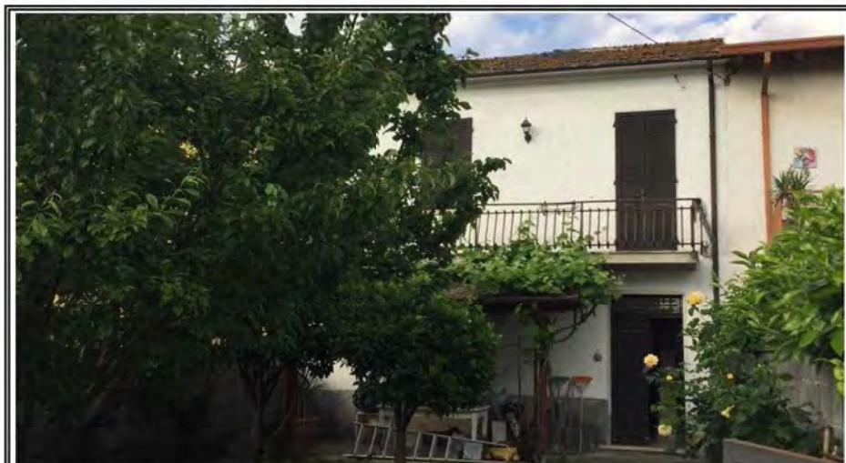
Foto n. 2 – Facciata lato Via Renella
