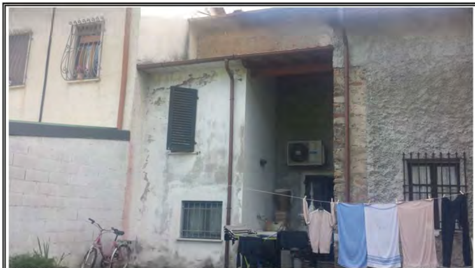
Foto n. 5 – Facciata posta sul retro lato monti
