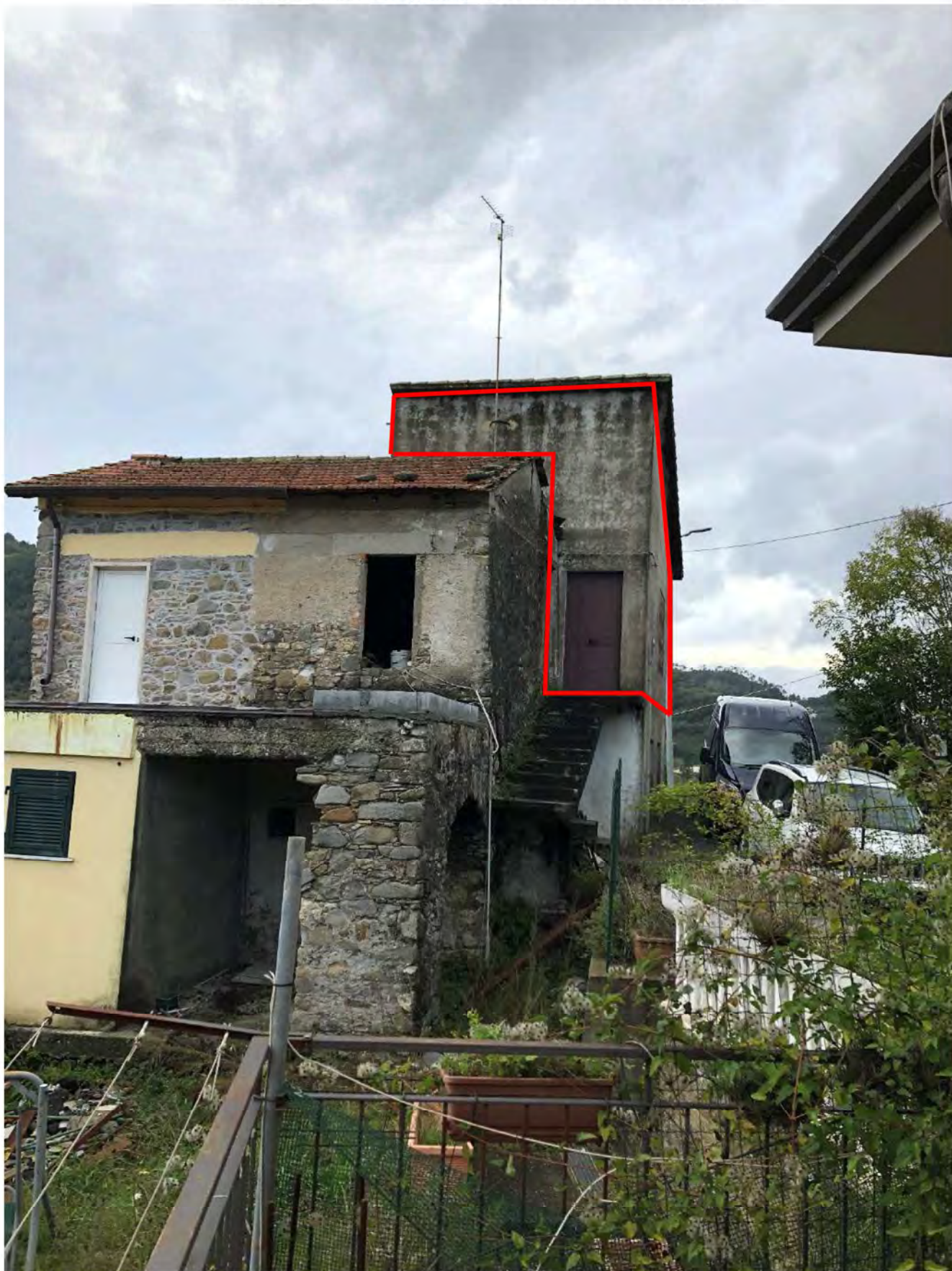
Foto 25 – Copro “B” – Deposito attrezzi al piano primo
