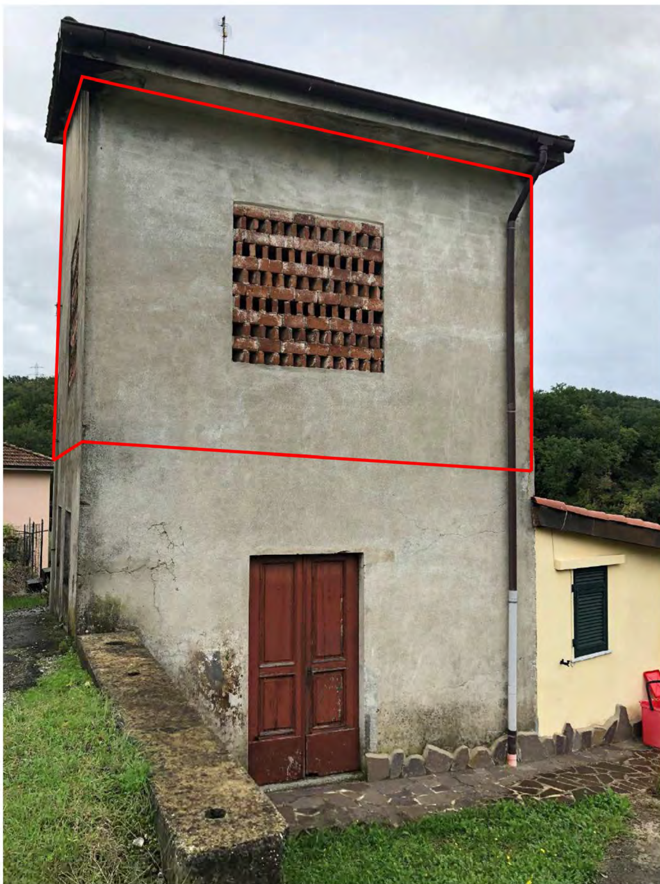
Foto 24 – Copro “B” – Deposito attrezzi al piano primo
