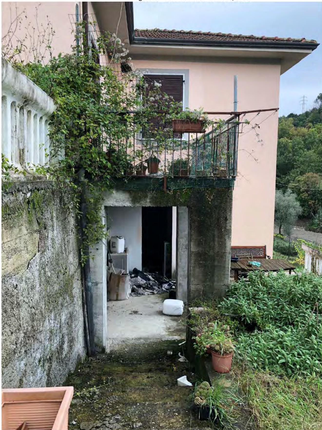
Foto 16 – Corpo A – Piano Primo Sottostrada
