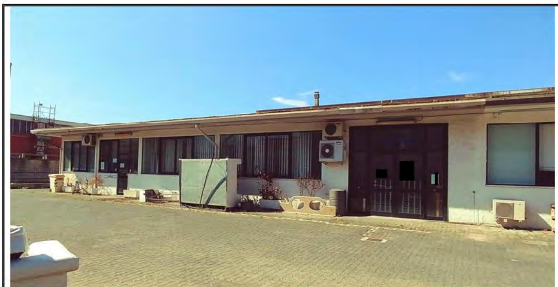
Foto n. 1 – Vista del fabbricato facciata lato NORD-EST
