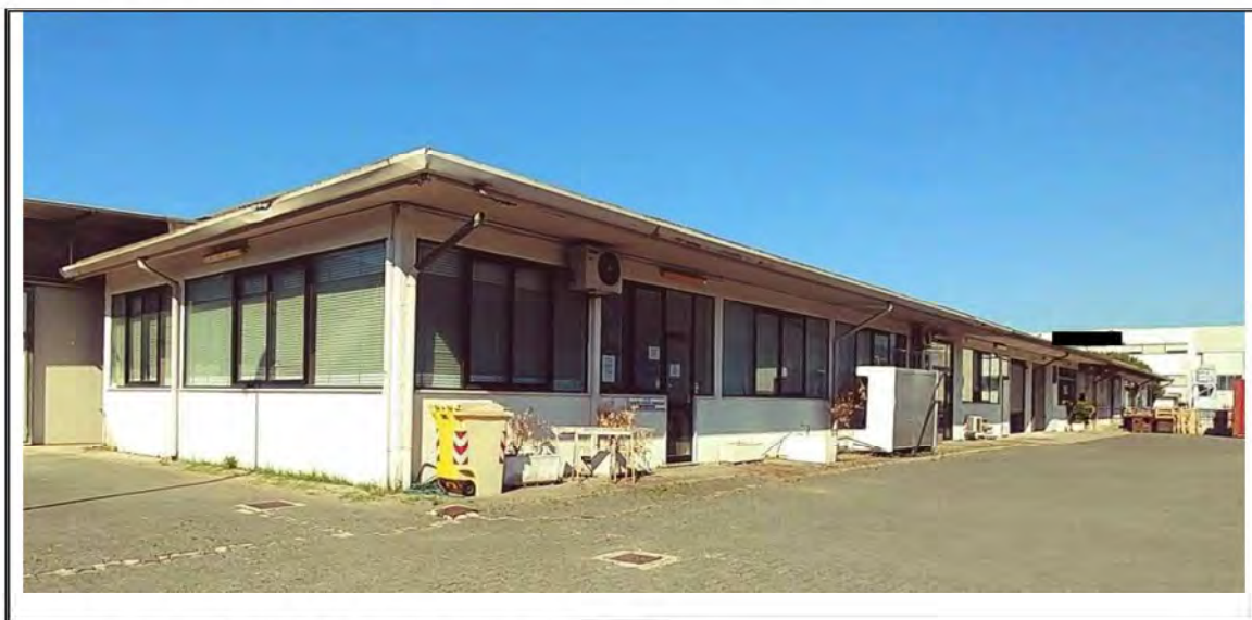
Foto n. 1 – Vista del fabbricato angolo OVEST
