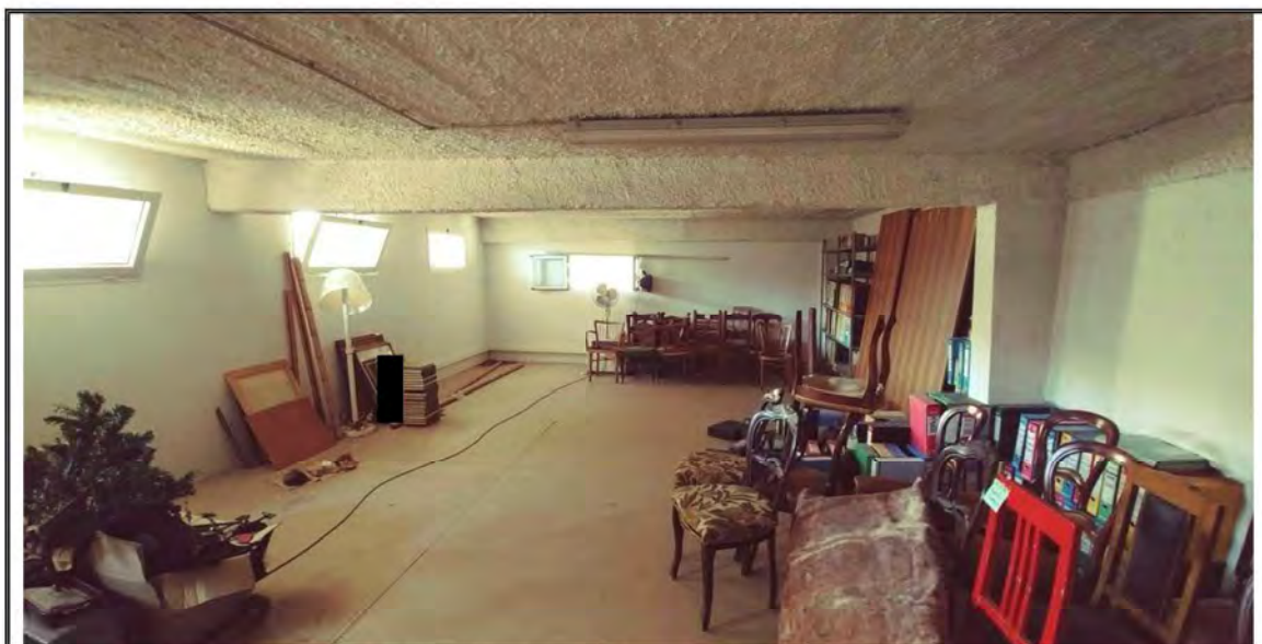
Foto n. 20 – Piano Primo o Soppalco - Magazzino
