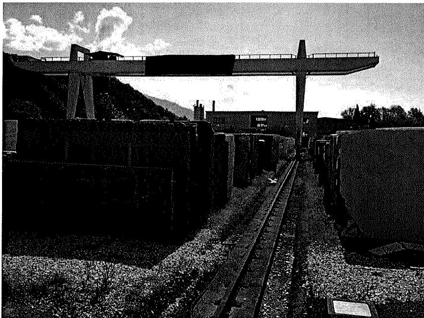
Area pertinenziale stoccaggio lastre e via di corsa delle gru a cavalletto
