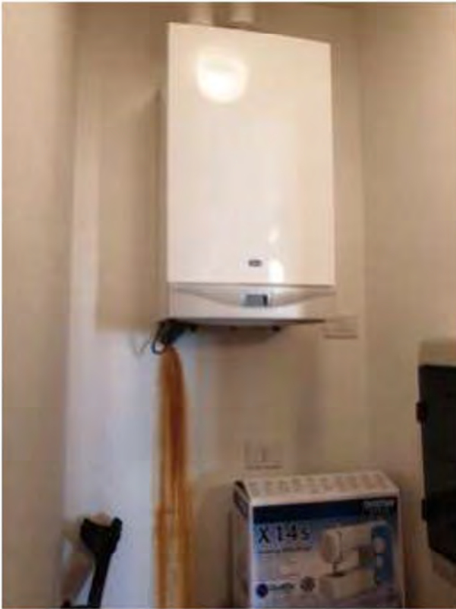
FOTO 160. Antibagno bagno B
