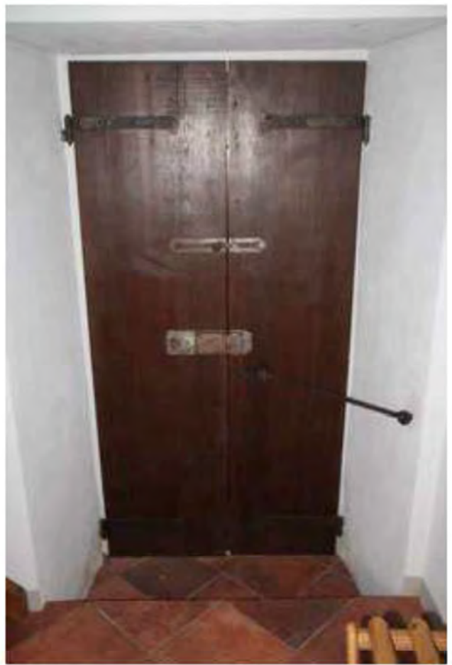
FOTO 47. Accesso esterno a camera 2
