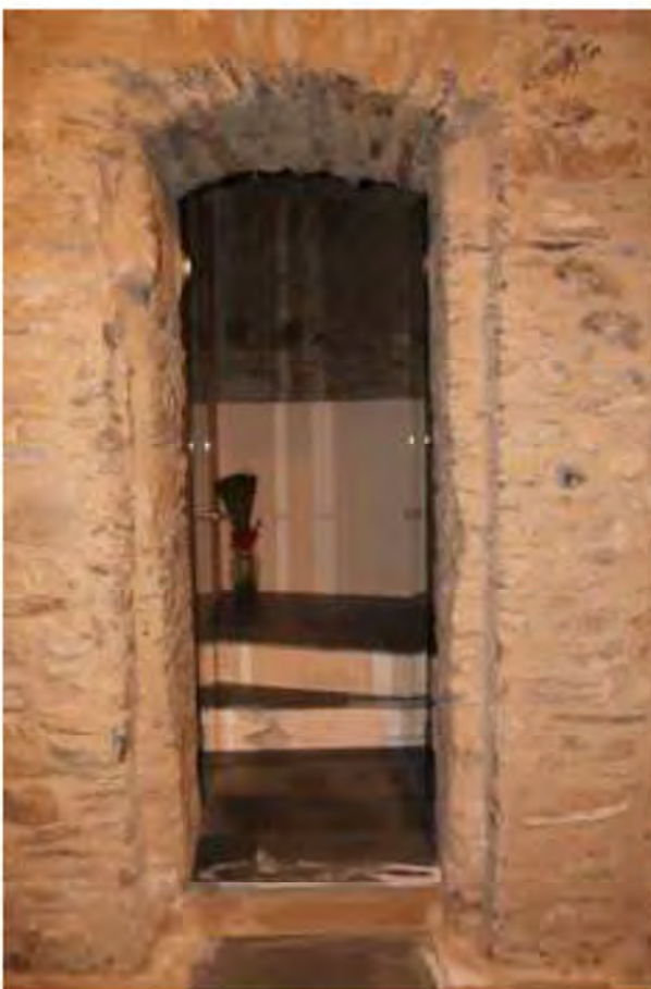
FOTO 124. Accesso a W.C. piano terra
