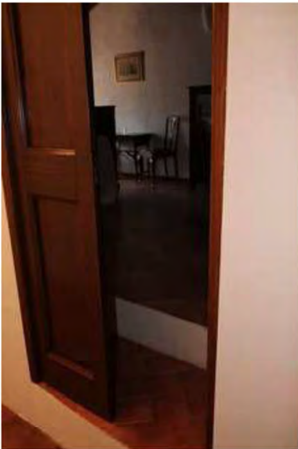
FOTO 32. Accesso a camera 10
