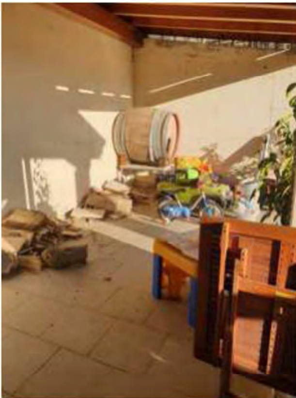
FOTO 152. Portico ex frantoio
