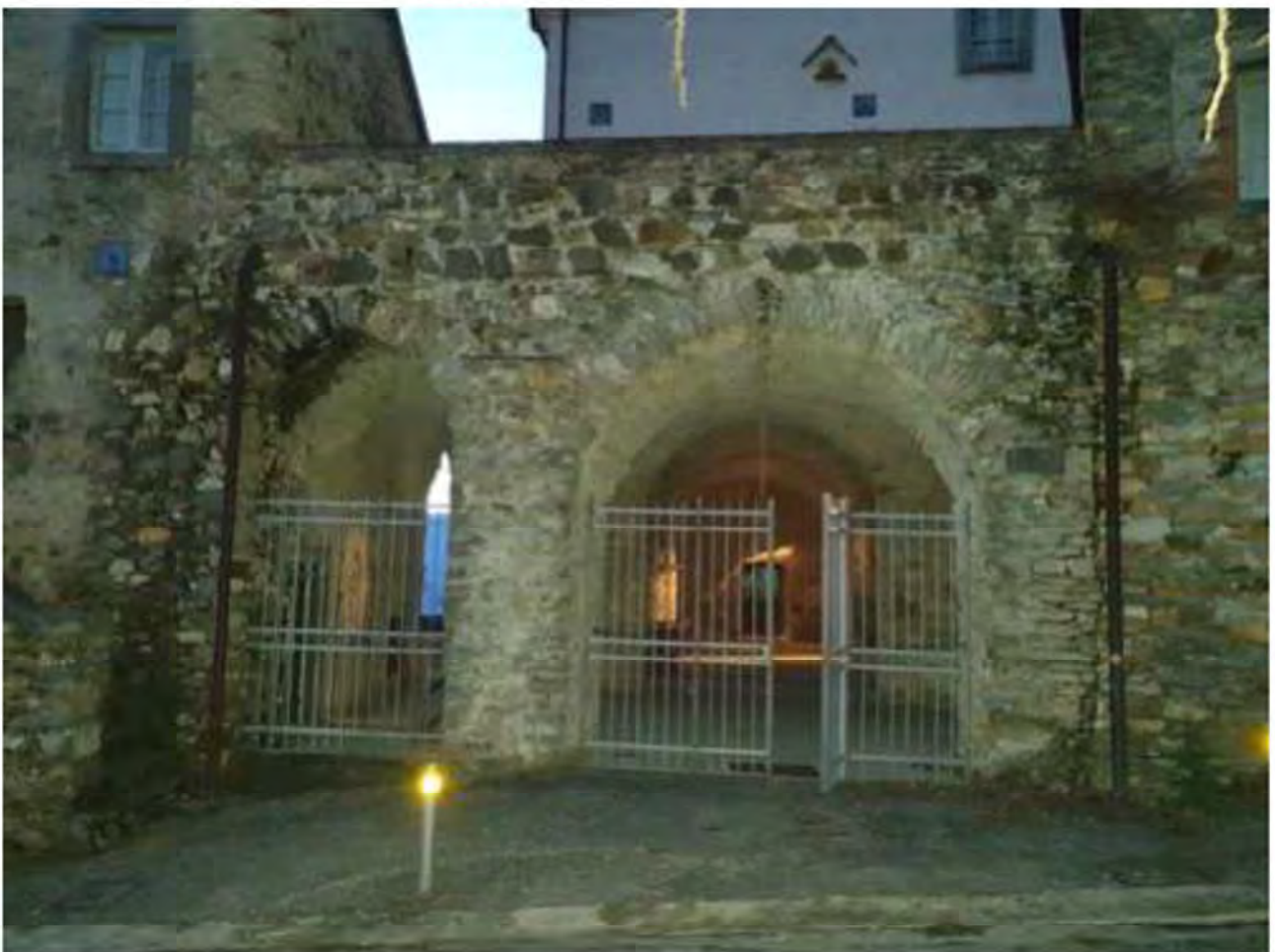
FOTO 136. Ingresso alla residenza
