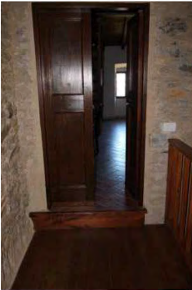
FOTO 25. Accesso a camera 4
