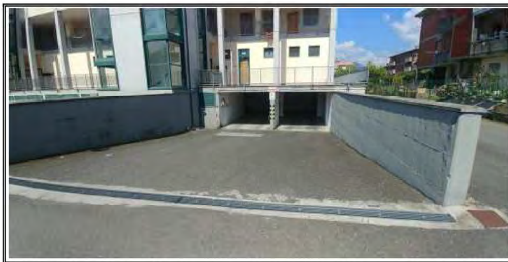
Foto n. 13 – Rampa di ingresso comune al piano interrato
