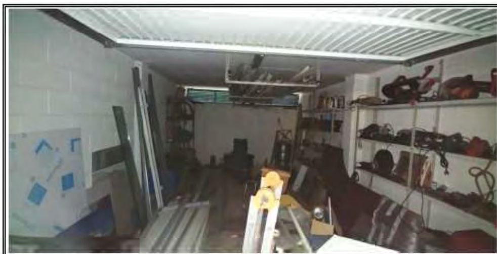
Foto n. 17– Corridoio di distribuzione comune al piano interrato
