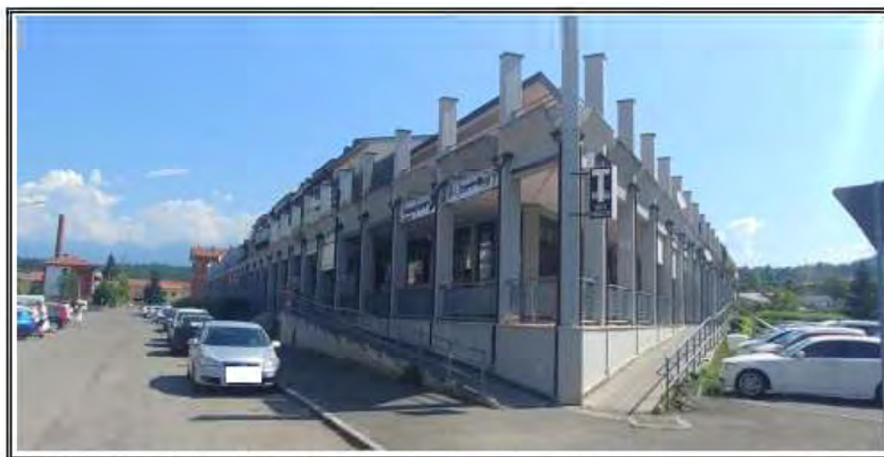
Foto n. 1 – Vista del condominio angolo SUD-OVEST
