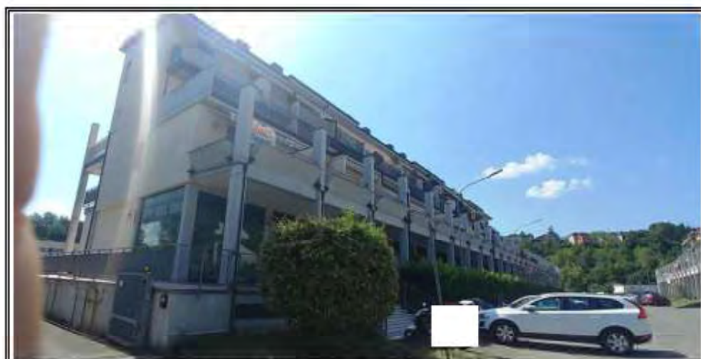
Foto n. 2 – Vista del condominio angolo NORD-OVEST
