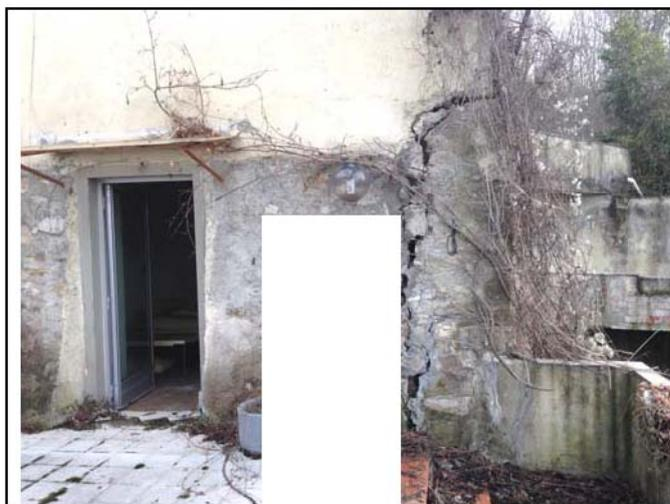
**Foto n.10** – Lesioni presenti al piano primo dell'edificio in corrispondenza del lato valle dello spigolo sud-ovest.
