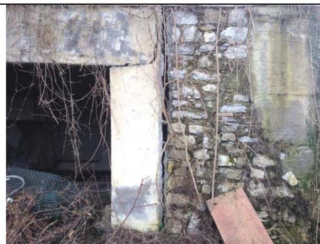
**Foto n.11** – Lesioni presenti al piano terra dell'edificio in corrispondenza del lato valle dello spigolo sud-ovest.
