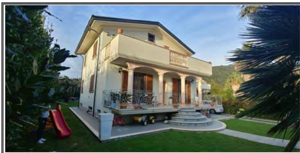
Foto n. 2 – Vista del Fabbricato – Angolo SUD
