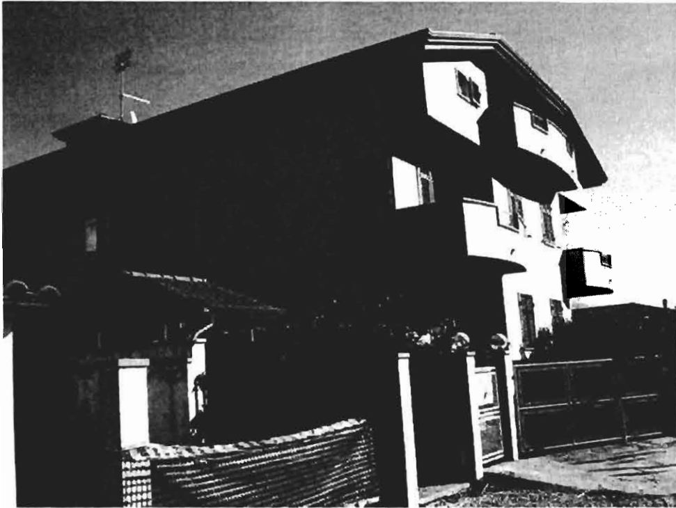
Vista esterna Fabbricato B
