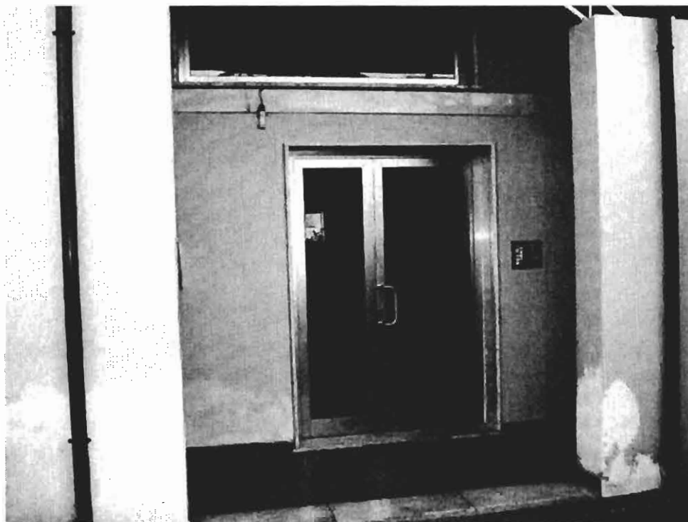
Fabbricato B – Ingresso
