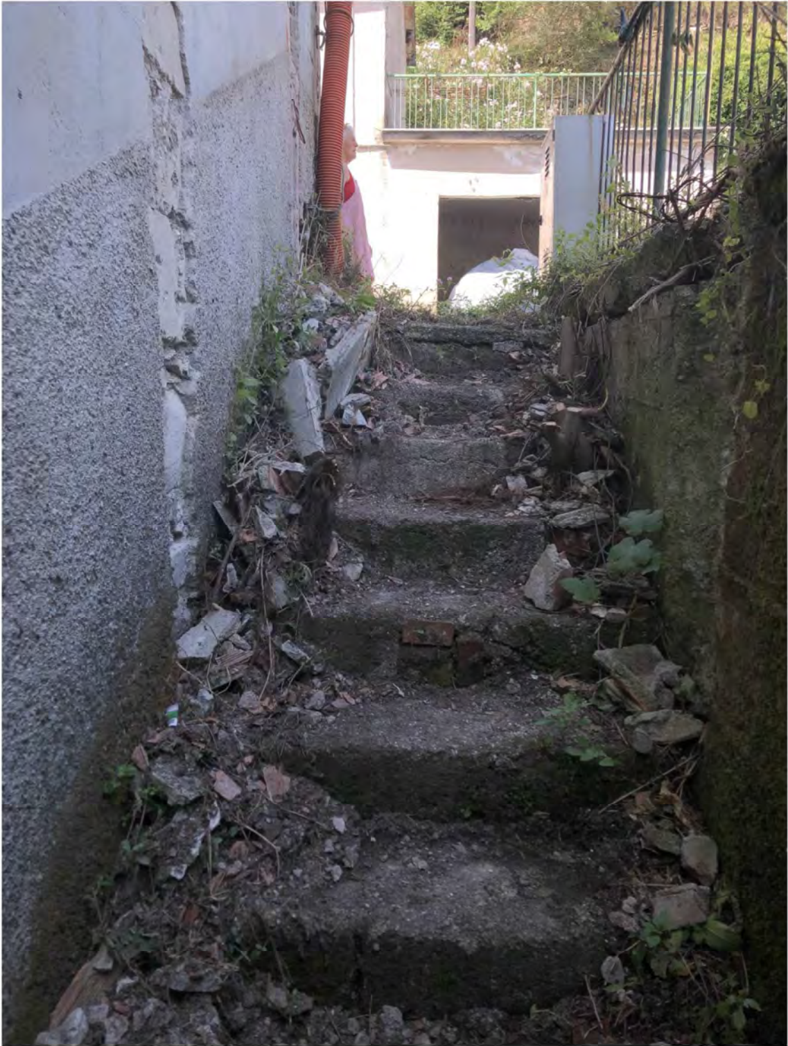
Foto 21 – Scala di accesso esterna al piano seminterrato
