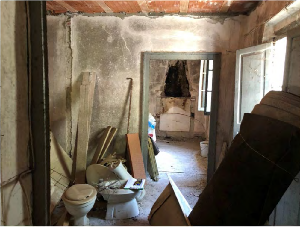
Foto 10 – Vista interna piano primo
