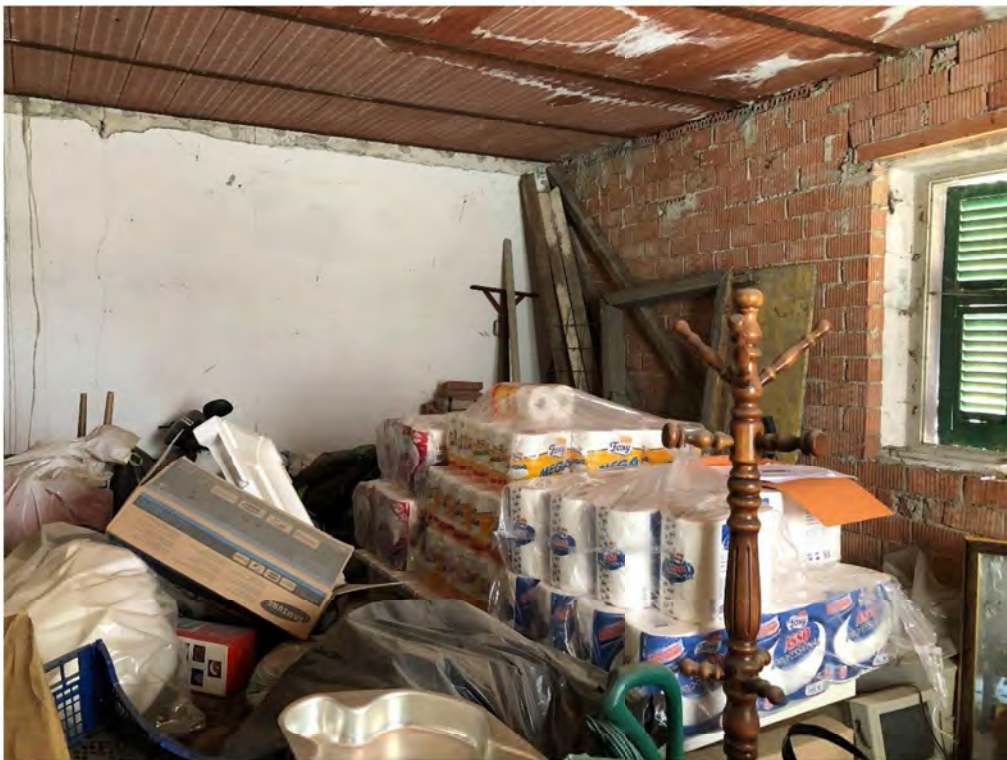
Foto 6 - Vista interna piano terra
