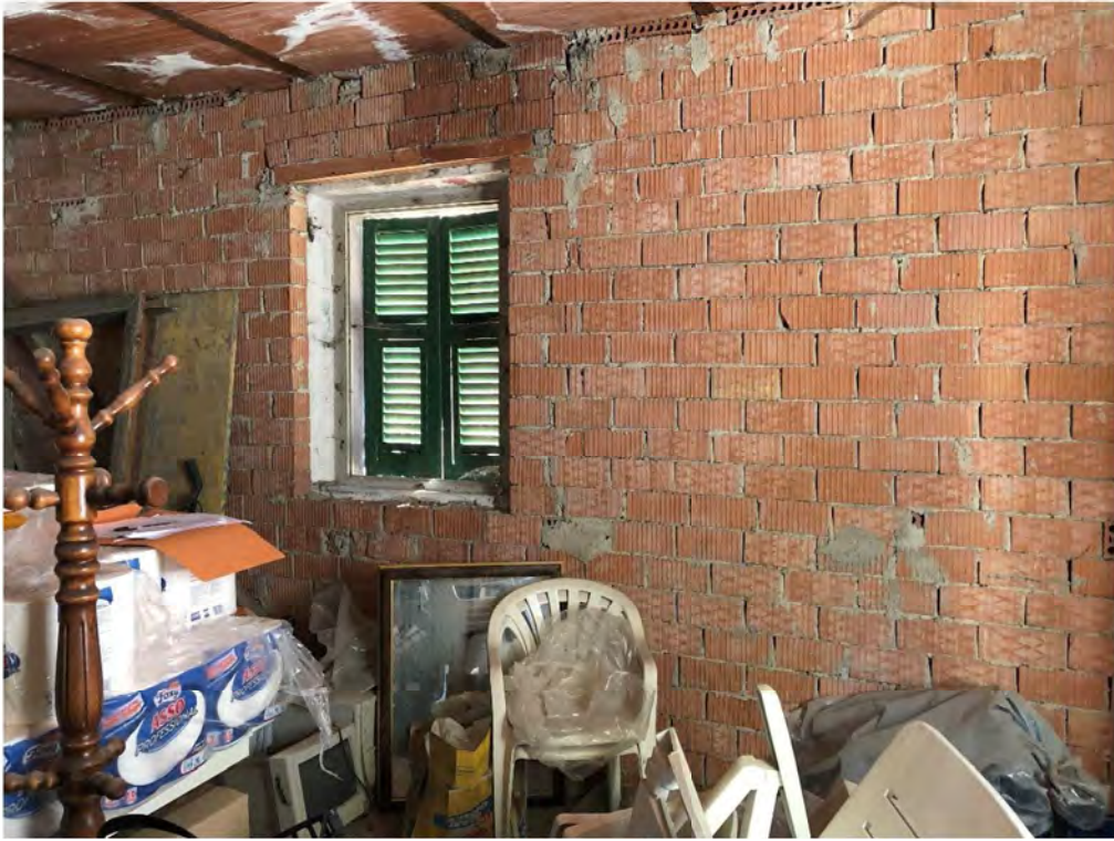
Foto 5 - Vista interna piano terra
