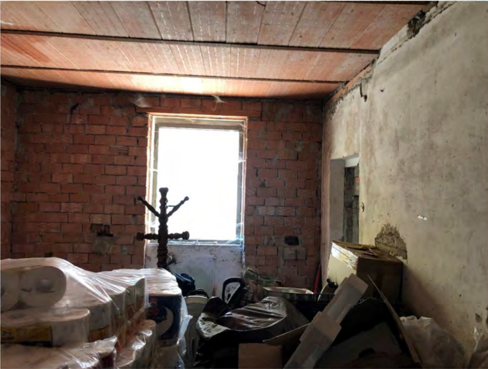
Foto 8 – Vista interna piano terra
