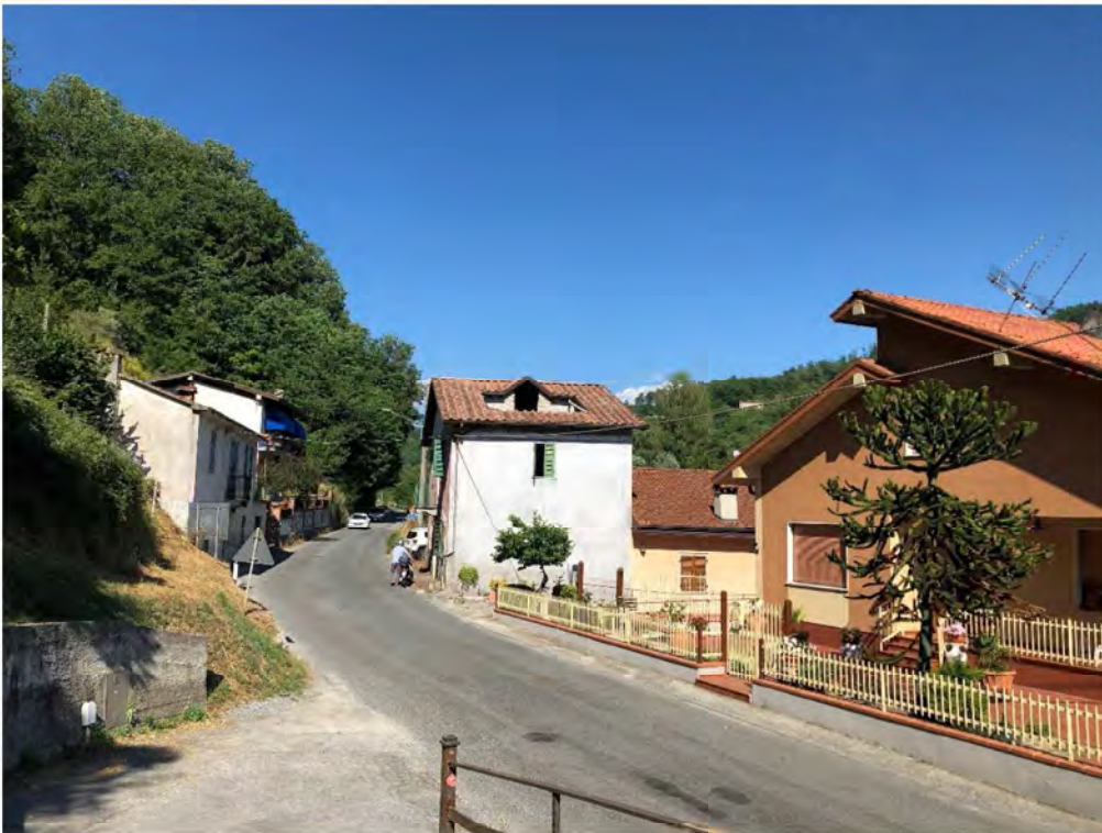
Foto 2 Via Casala – Facciata ovest
