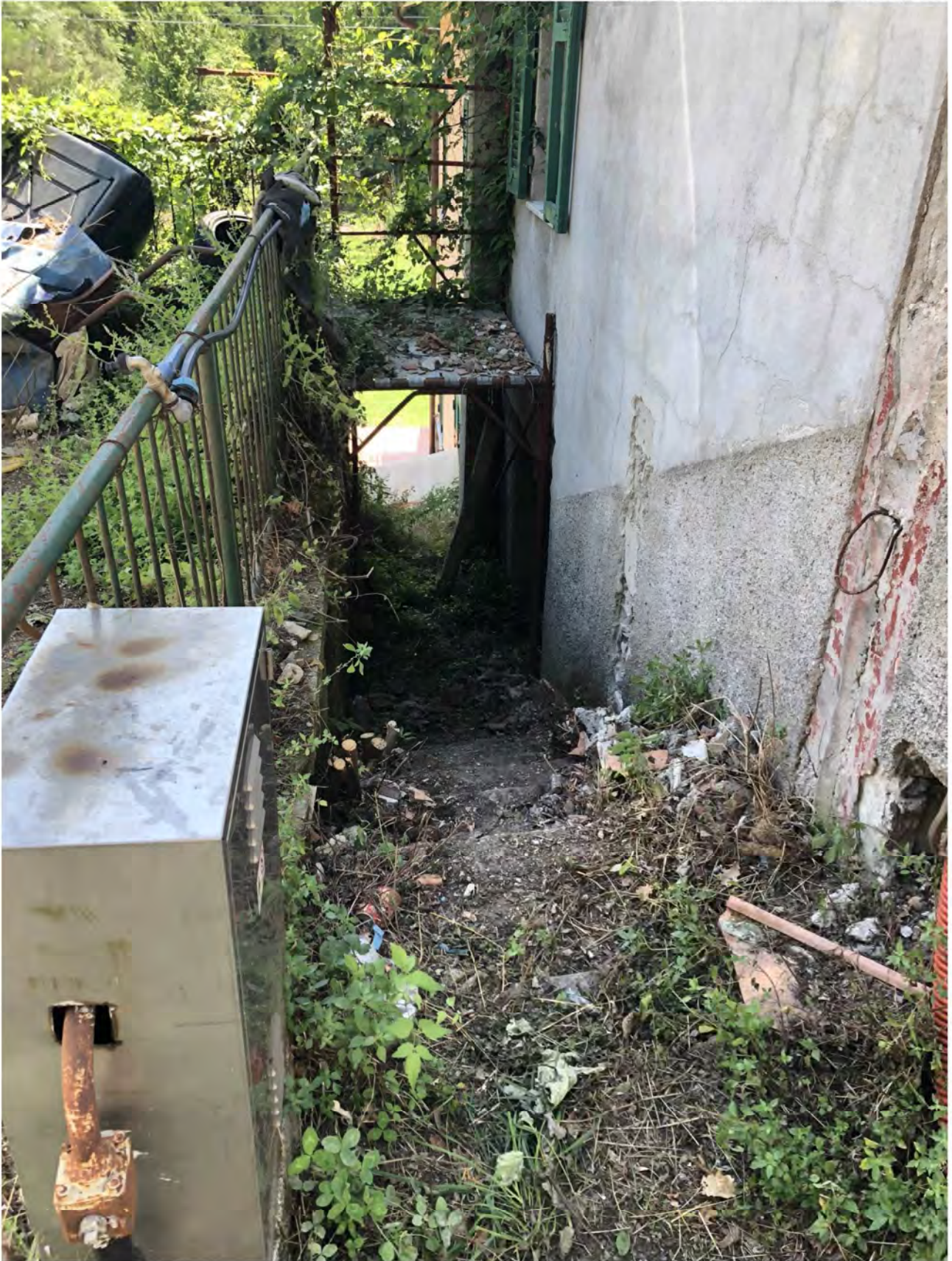
Foto 19 – Scala esterna di accesso al piano seminterrato
