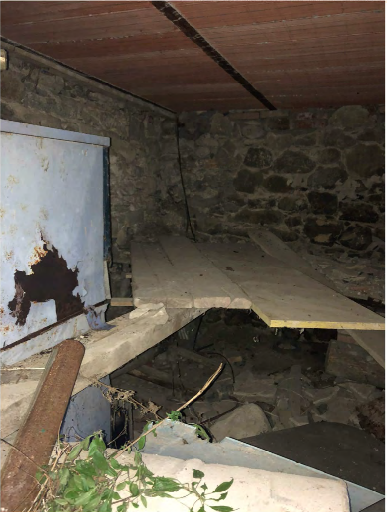
Foto 20 – Vano cantina al Piano seminterrato
