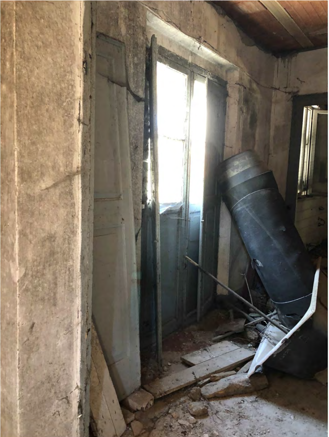
Foto 14 – Vista interna piano primo
