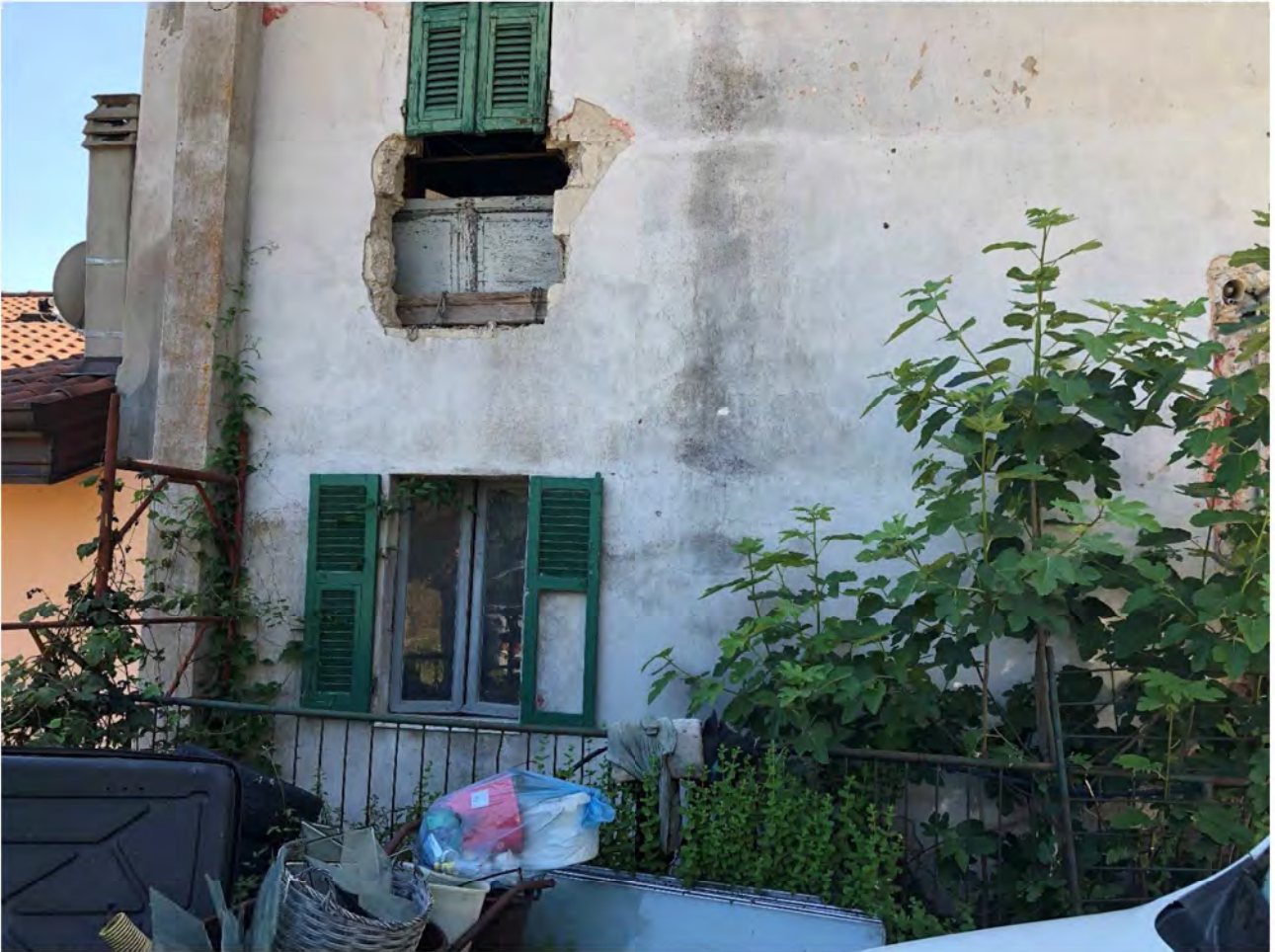
Foto 15 – facciata lato est
