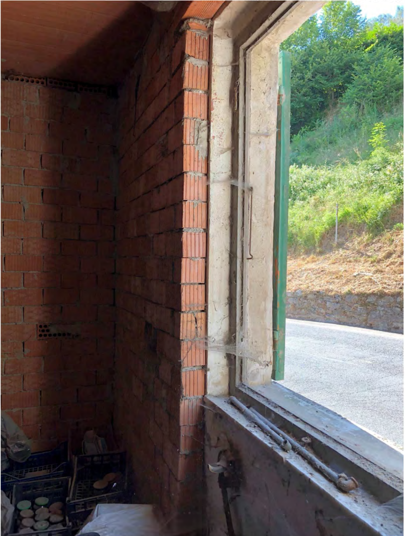
Foto 7 – Particolare del muro perimetrale piano terra
