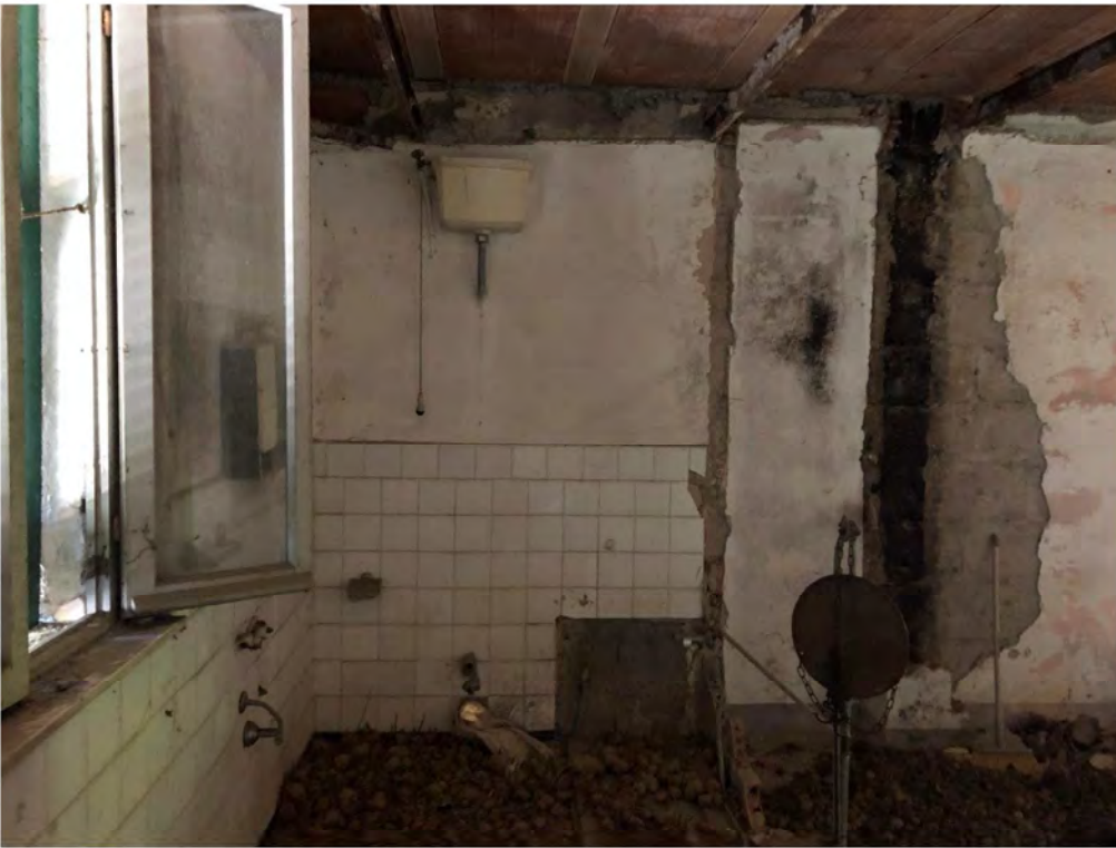
Foto 12 – Vista interna piano primo
