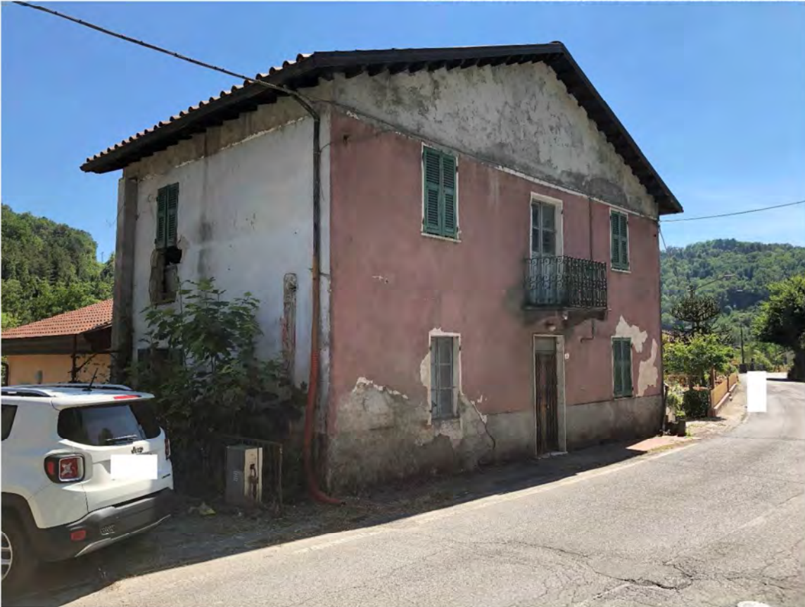
Foto 1 – Prospetto su Via Casala
