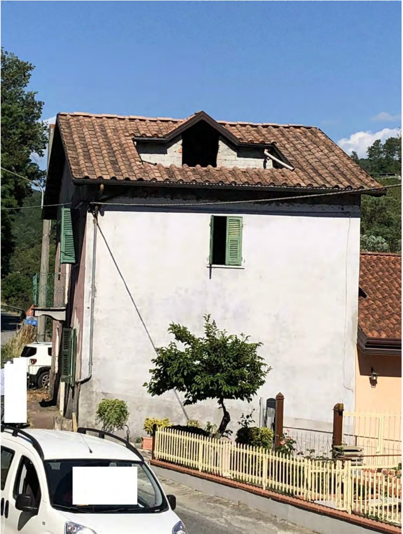
Foto 3 – via Casala – facciata Ovest
