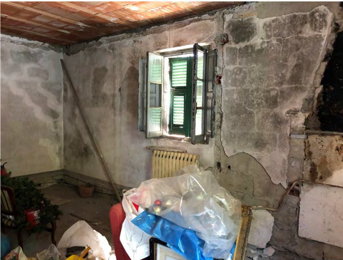
Foto 11 – Vista interna piano primo
