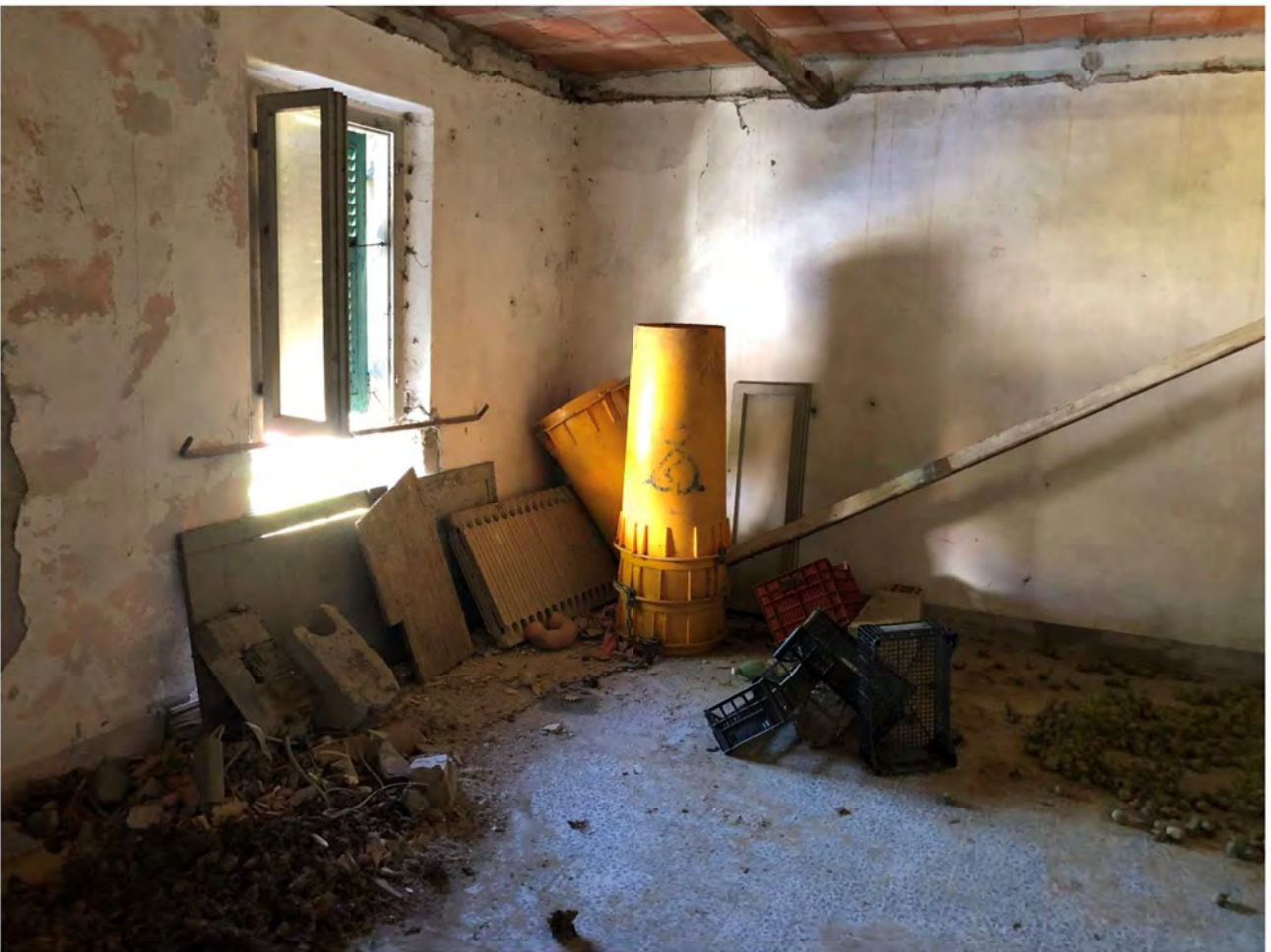
Foto 9 – Vista interna piano primo
