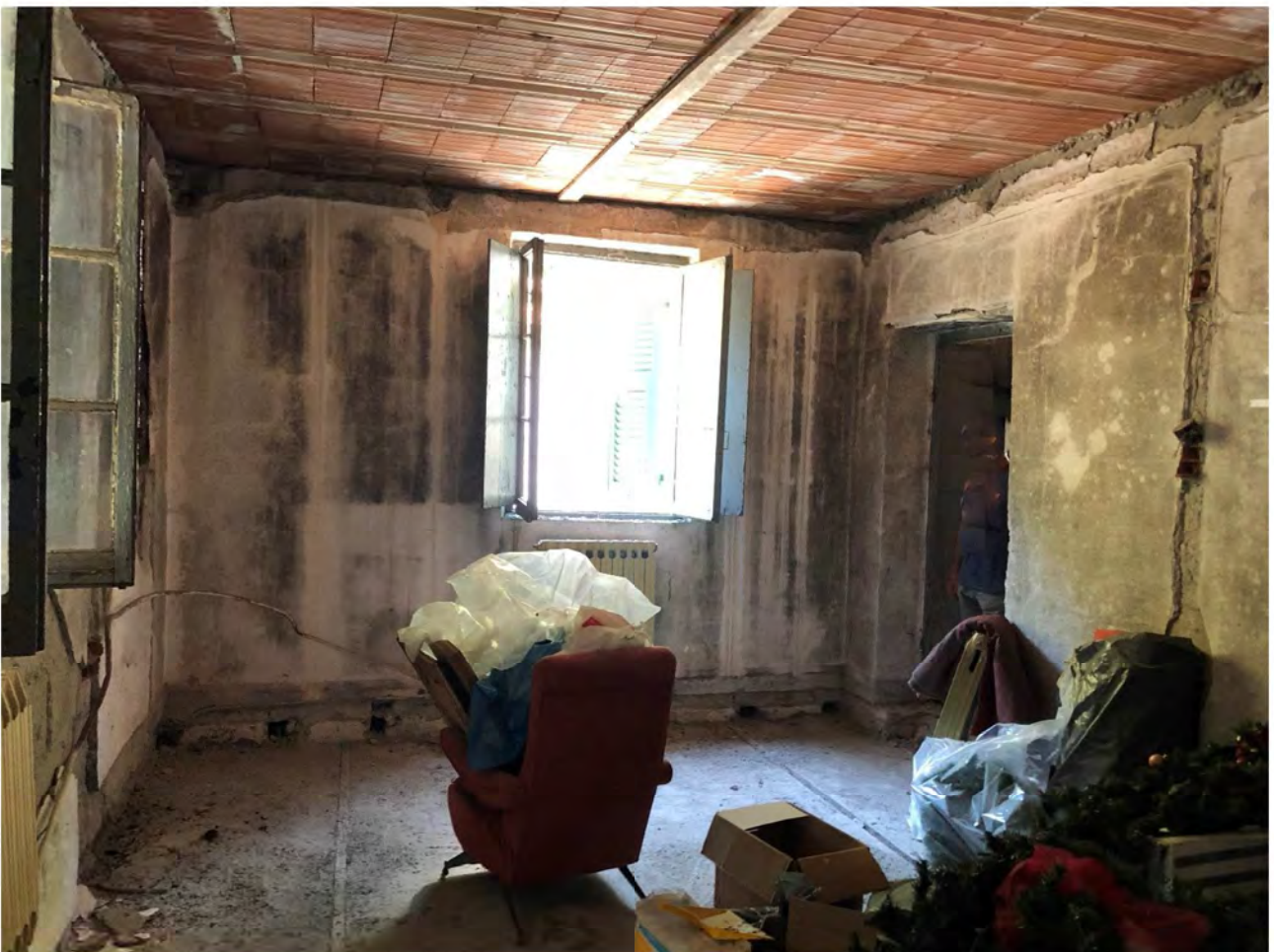
Foto 13 – Vista interna piano primo
