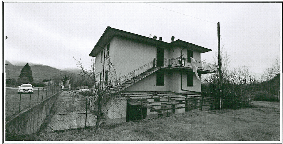
Foto n. 4 – Vista del fabbricato – Angolo SUD-OVEST
