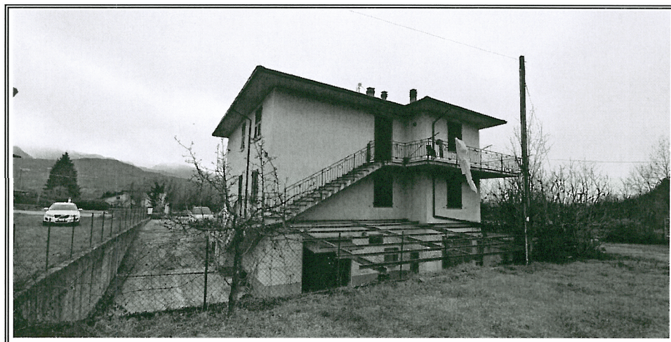
Foto n. 4 – Vista del fabbricato – Angolo SUD-OVEST
