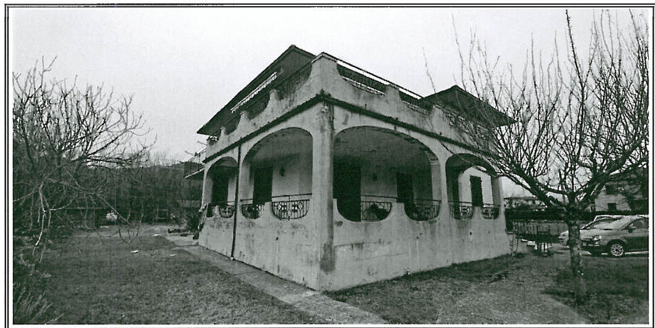
Foto n. 2 – Vista del fabbricato – Angolo NORD-EST
