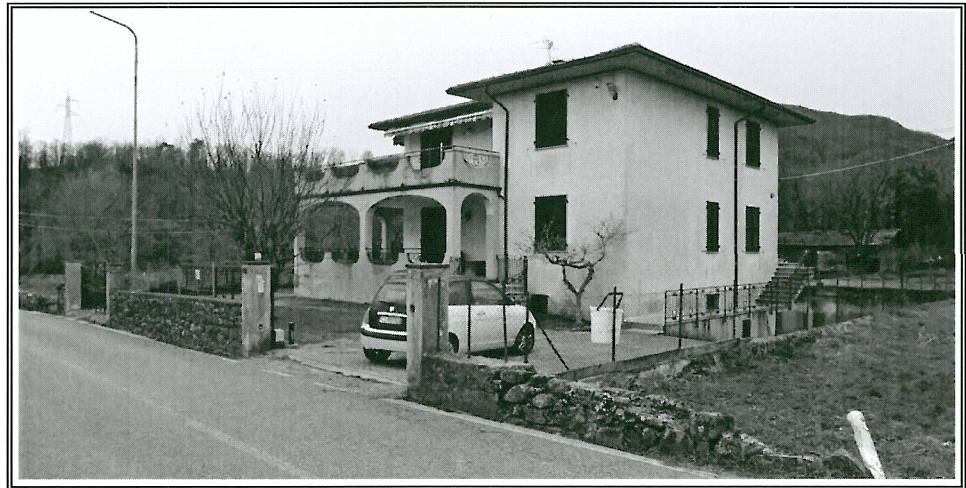
Foto n. 1 – Vista del fabbricato – Angolo NORD-OVEST
