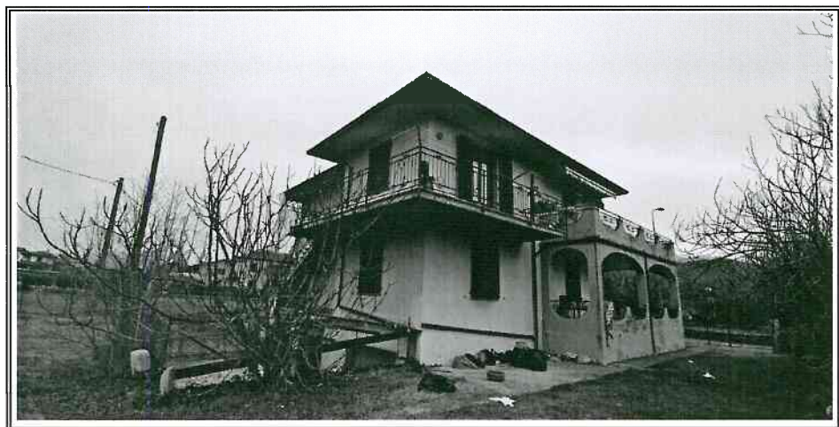
Foto n. 3 – Vista del fabbricato – Angolo SUD-EST
