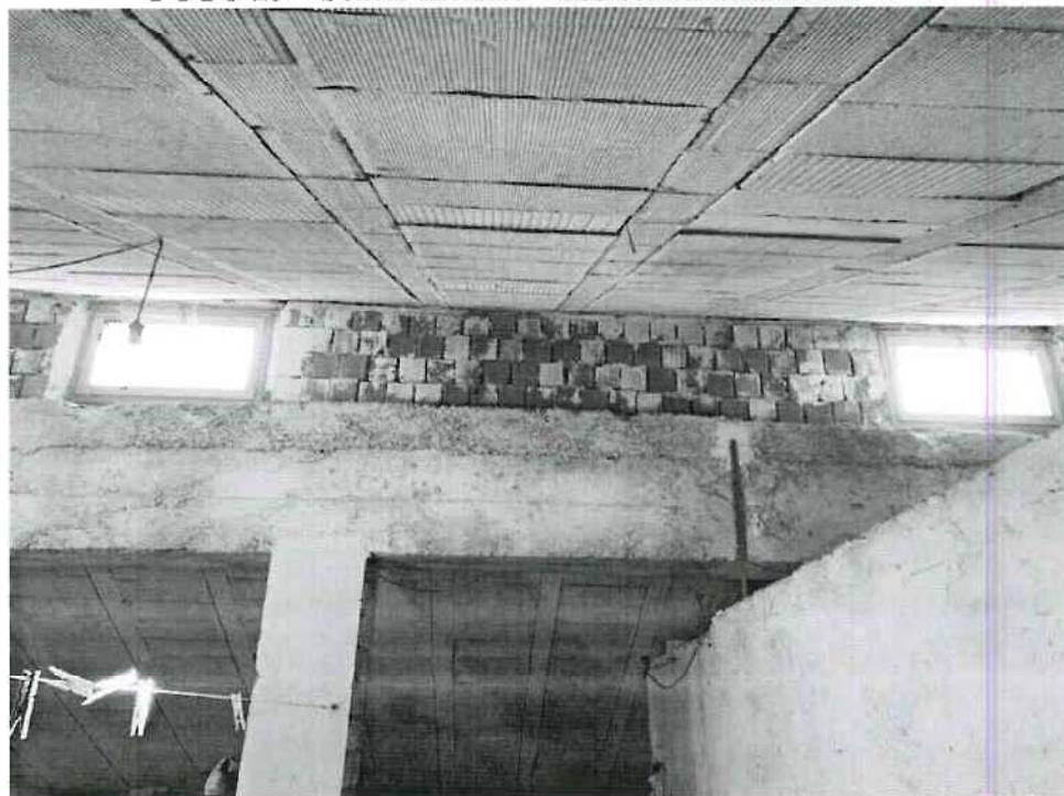
FOTO 23 – Scatto interno – Sottotetto/Stenditoio – P 2
