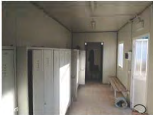
- Panoramica esterna ed interna del box spogliatoio
