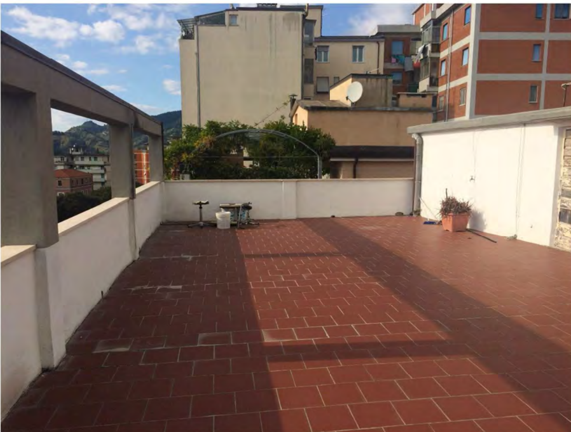
Foto 18 – Terrazza esclusiva con ripostiglio al piano quinto
