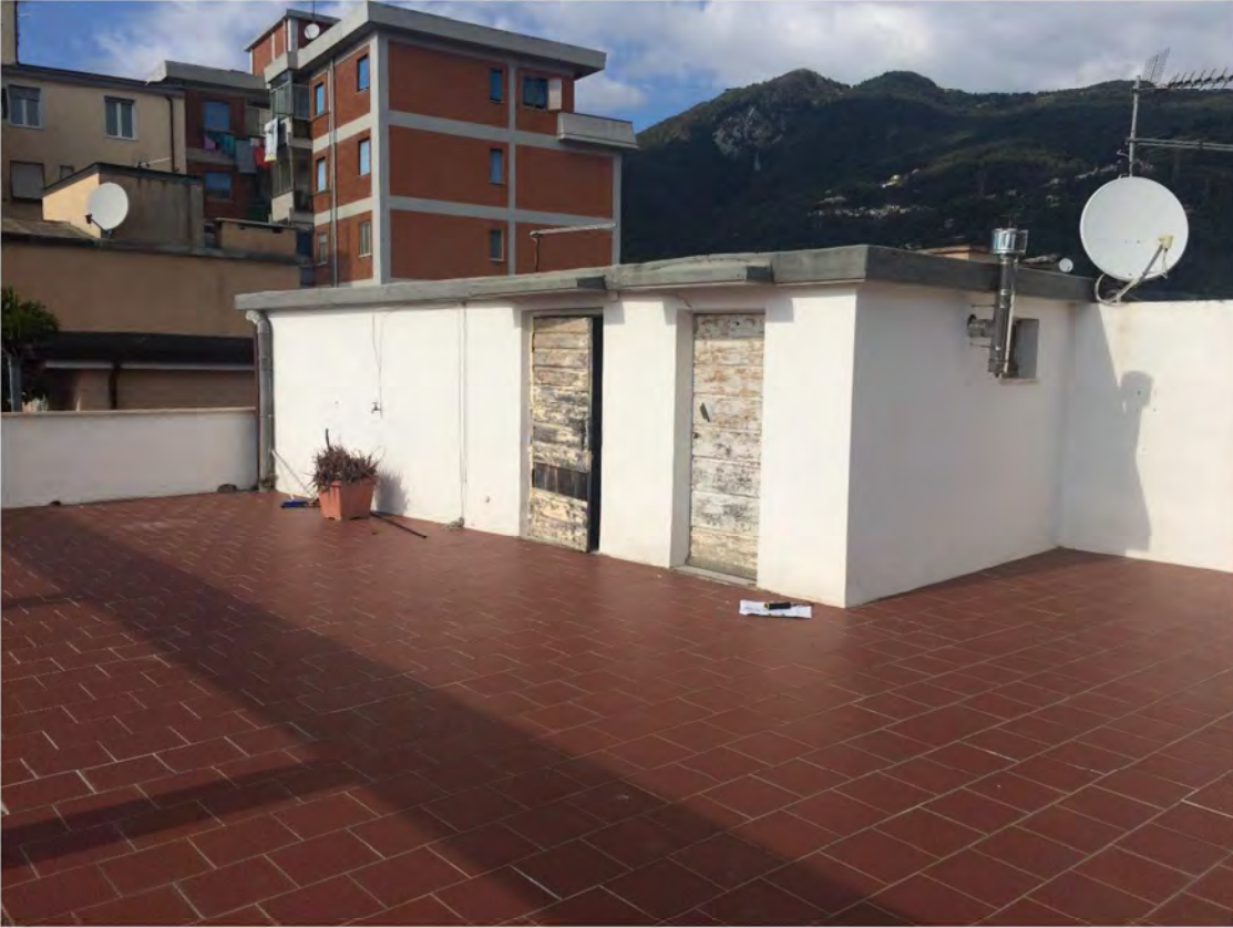
Foto 17 – Terrazza esclusiva con ripostiglio al piano quinto
