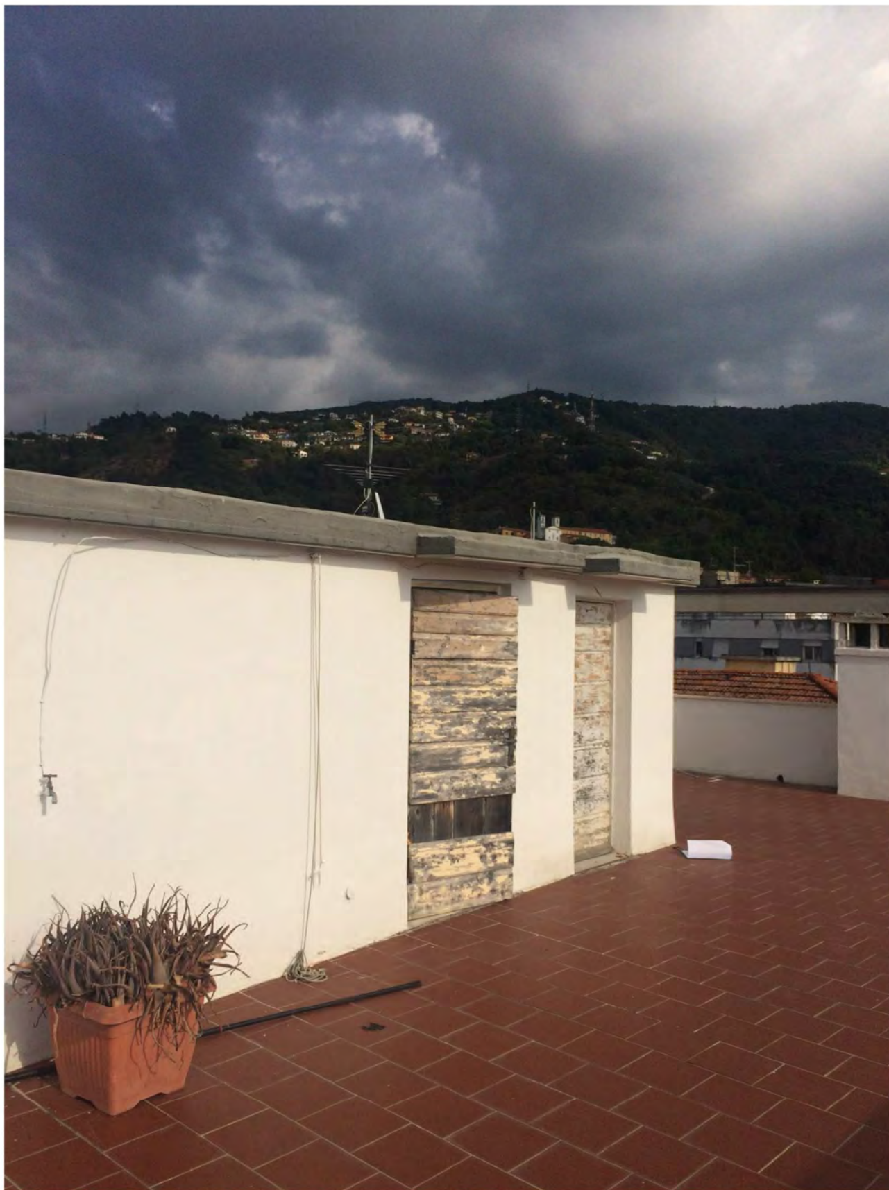
Foto 20 – Terrazza esclusiva con ripostiglio al piano quinto
