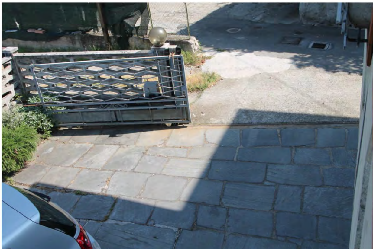
Foto 33. Area di pertinenza esterna lotto 1
