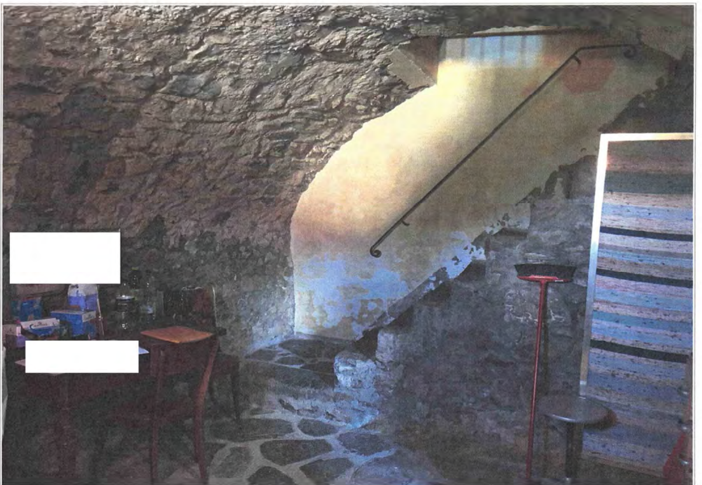
Scale di collegamento tra il piano terra e il piano primo
