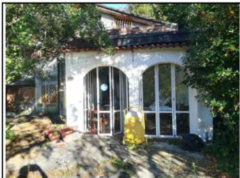
Foto n. 1 – Vista facciata OVEST
