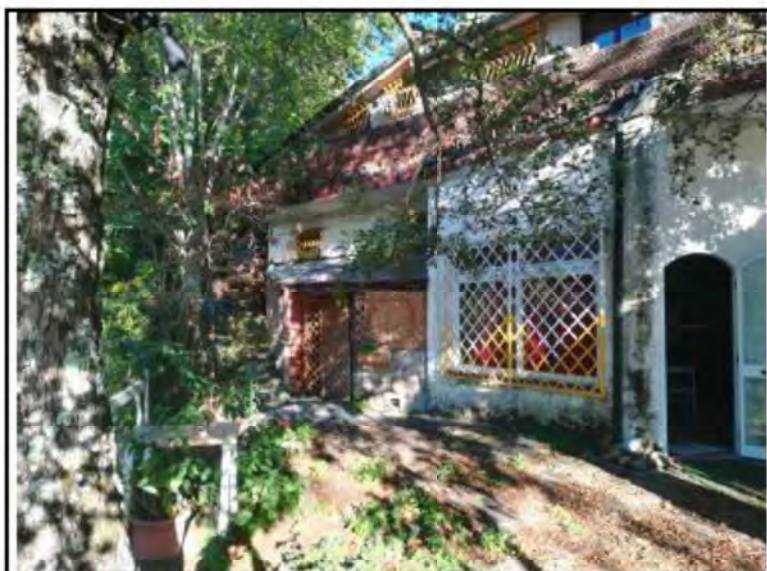
Foto n. 3 – Vista facciata OVEST
