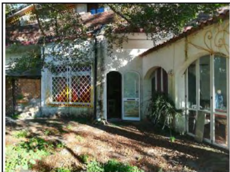
Foto n. 3 – Vista facciata OVEST
