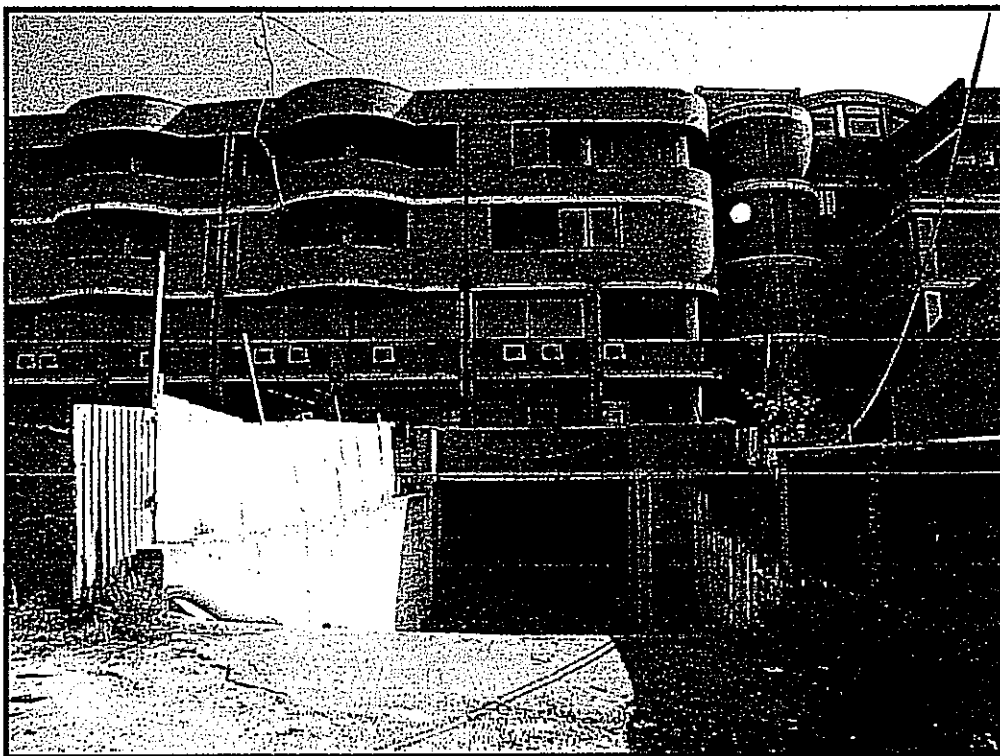
Foto n. 8: area urbana, foglio 116, mapp. 274, sub. 29
